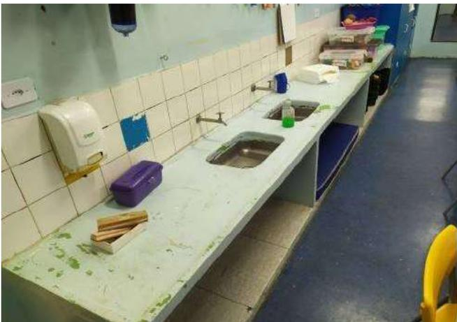
FOTO 71 Sala de aula 05, necessário revisão dos acabamentos e pintura da bancada.
