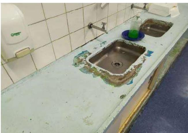
FOTO 65 Sala de aula 02, necessário revisão dos acabamentos e pinturas das bancadas e cubas.
