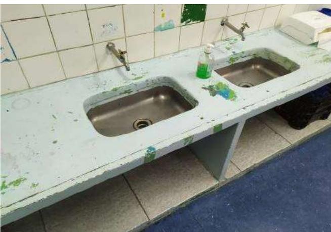
FOTO 73 Sala de aula 06, necessário revisão dos acabamentos e pintura da bancada.
