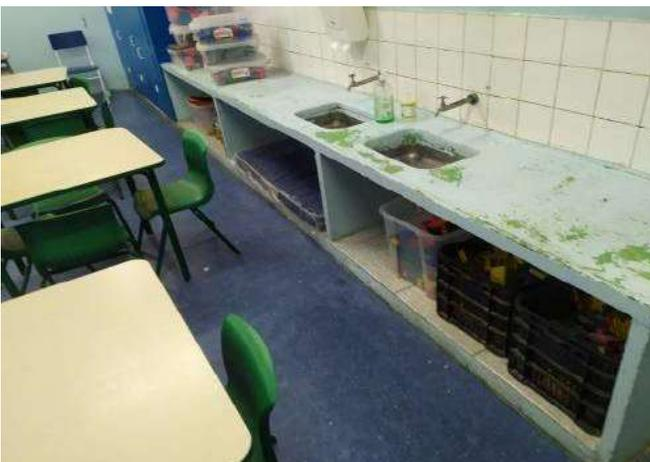
FOTO 83 Sala de aula 08, necessário revisão dos acabamentos e pintura da bancada.
