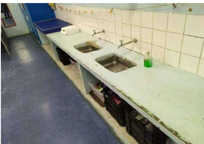
FOTO 79 Sala de aula 04, necessário revisão dos acabamentos e pintura da bancada.
