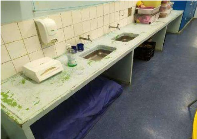
FOTO 81 Sala de aula 07, necessário revisão dos acabamentos e pintura da bancada.
