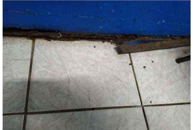
FOTO 32 Lavanderia, porta metálica da entrada, possui corrosão em sua base.
