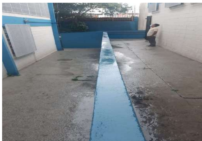
FOTO 4 RAMPA DE ACESSO AO REFEITÓRIO - OK
