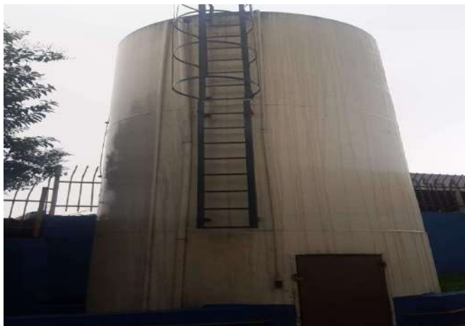
FOTO 1 CAIXA D'ÁGUA - OK
