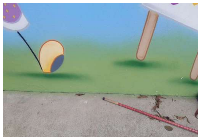
FOTO 10 DESNIVELAMENTO DO PISO DE ENTRADA DA ESCOLA
