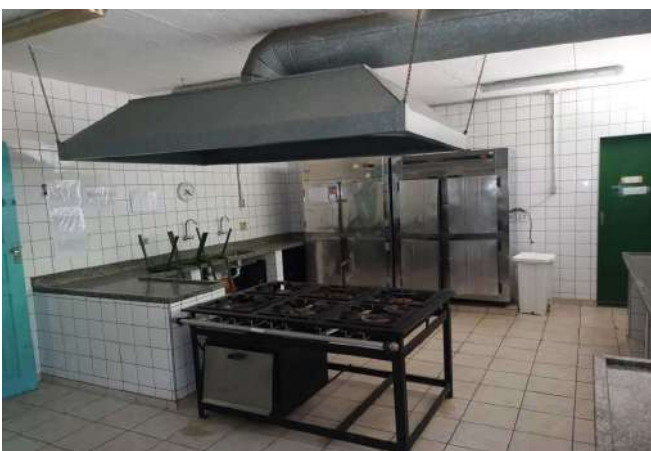
FOTO 29 Cozinha - Visão geral
