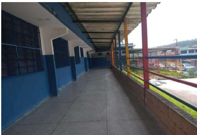
FOTO 15 Pátio Coberto - Visão geral
