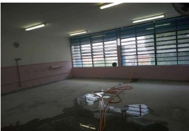
FOTO 47 Sala de Aula 06 - Visão geral
