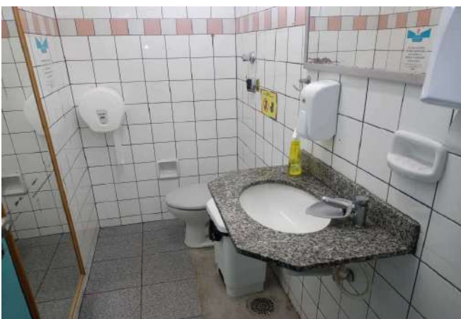
FOTO 65 Sanitário Feminino para Funcionários - Visão geral
