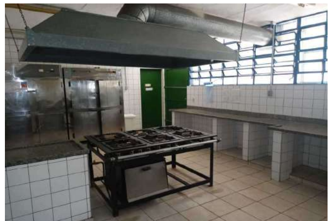
FOTO 28 Cozinha - Visão geral
