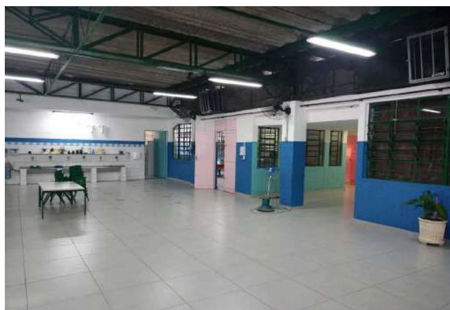
FOTO 12 Pátio Coberto - Visão geral
