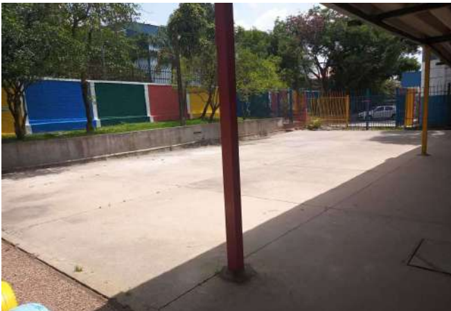
FOTO 19 Pátio Descoberto - Visão geral
