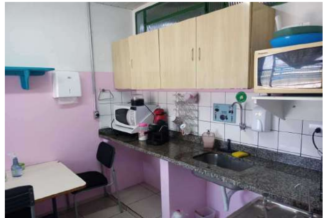
FOTO 26 Cozinha - Visão geral
