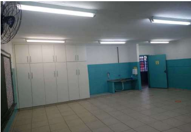
FOTO 43 Sala de Aula 04 - Visão geral
