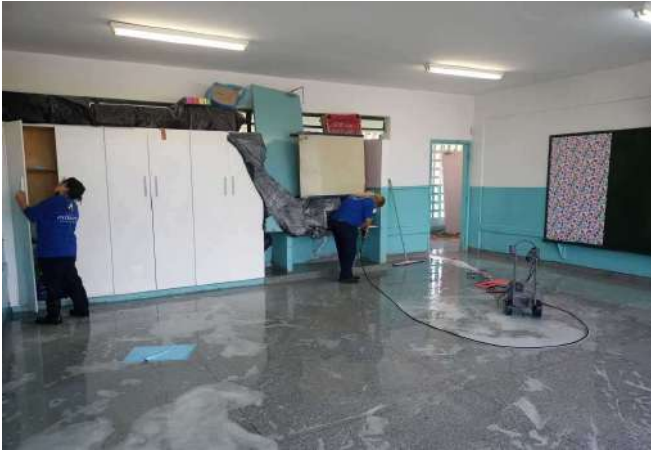
FOTO 49 Sala de Aula 07 - Visão geral
