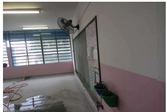
FOTO 46 Sala de Aula 06 - Visão geral
