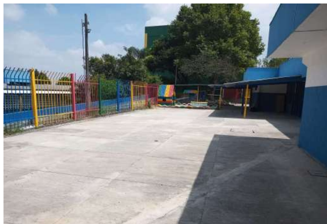
FOTO 16 Pátio Descoberto - Visão geral
