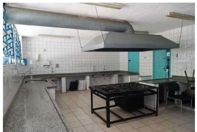
FOTO 30 Cozinha - Visão geral
