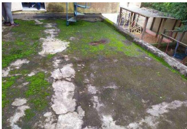
FOTO 84 Cobertura refeitório, impermeabilização desgastada, e com perfurações, refazer manta
