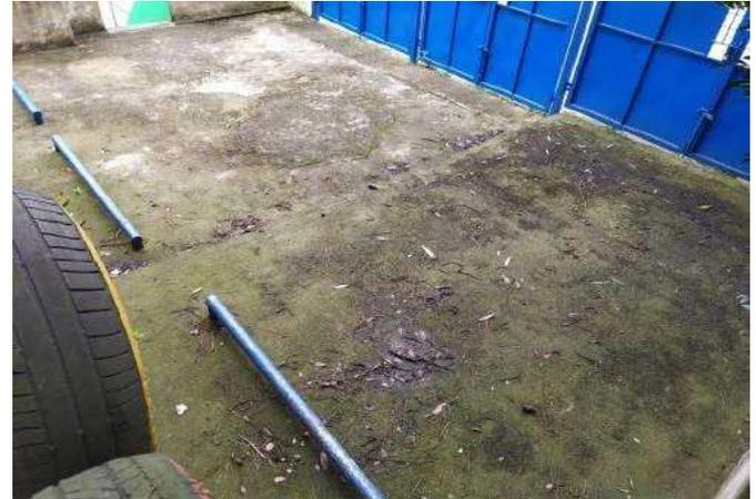
FOTO 116 estacionamento - Necessário contrapiso novo, demarcação de vagas
