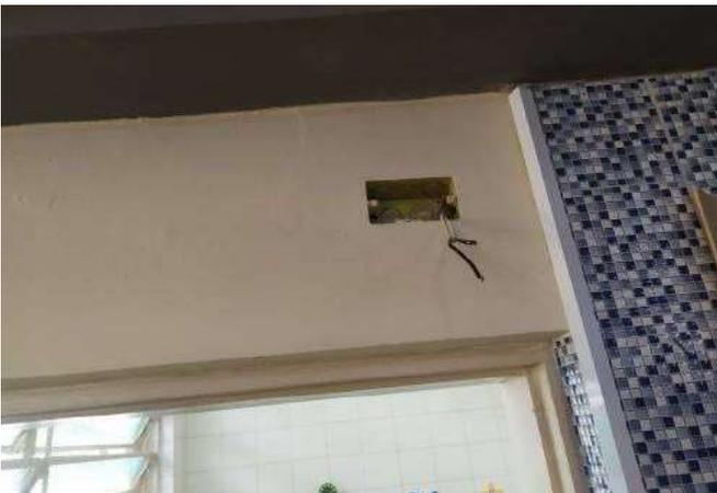
FOTO 39 Depósito materiais de limpeza, necessário revisão da luminária e instalação elétrica.
