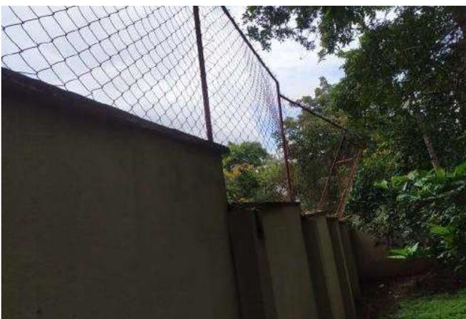
FOTO 113 Necessário troca dos alambrados danificados do muro de divisa, atrás parque arboreo
