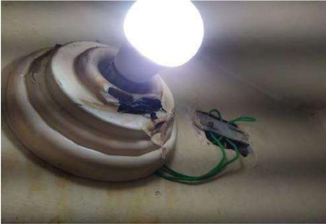
FOTO 37 Depósito materiais de limpeza, necessário revisão da luminária e instalação elétrica.
