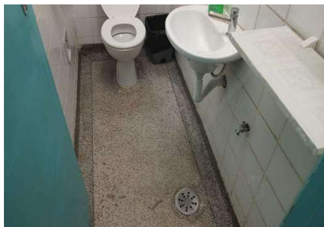
FOTO 59 BANHEIRO FEMININO ADMINISTRATIVO
