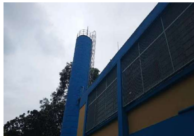
FOTO 18 FACHADA E RESERVATÓRIO ELEVADO
