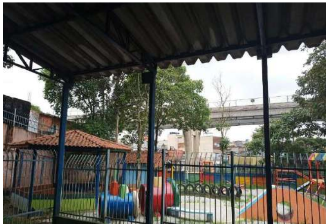
FOTO 7 PÁTIO EXTERNO COBERTO
