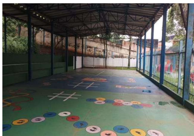
FOTO 8 PÁTIO EXTERNO COBERTO
