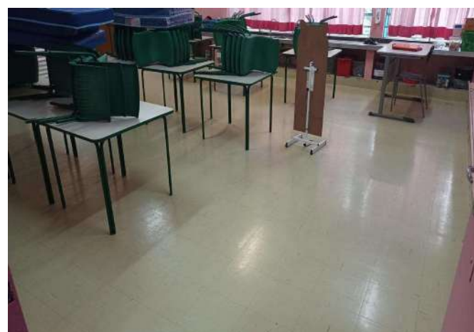
FOTO 108 SALA DE AULA 05 IMPROVISO NA REDE ELÉTRICA DE ILUMINAÇÃO E VENTILAÇÃO
