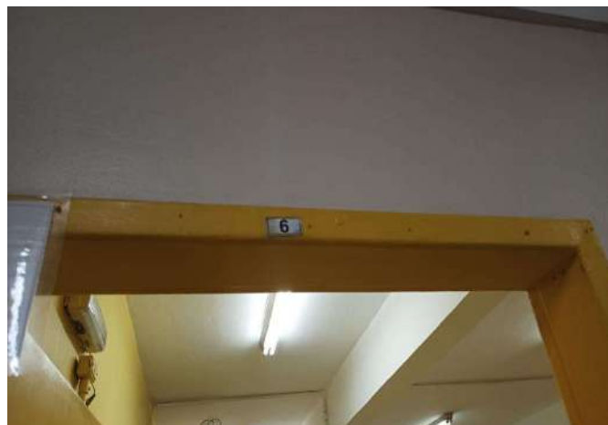
FOTO 110 SALA DE AULA 06
