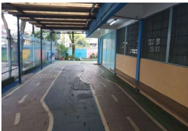
FOTO 11 PÁTIO EXTERNO COBERTO
