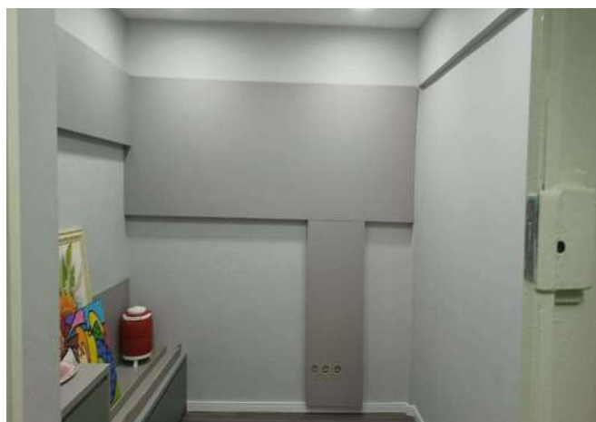
FOTO 69 SALA DA DIREÇÃO(EM MANUTENÇÃO)
