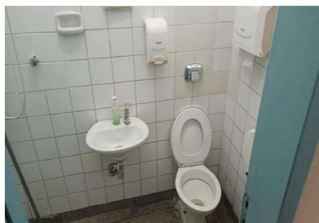
FOTO 48 BANHEIRO MASCULINO FUNCIONÁRIOS
