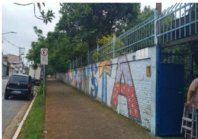
FOTO 1 MURO COM GRADIL DA FRENTE DA ESCOLA
