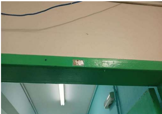
FOTO 91 SALA DE AULA 02
