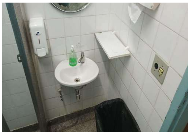
FOTO 51 BANHEIRO FEMININO ADMINISTRATIVO
