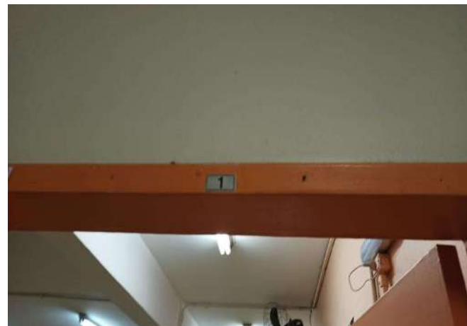
FOTO 94 SALA DE AULA 01
