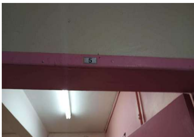
FOTO 107 SALA DE AULA 05
