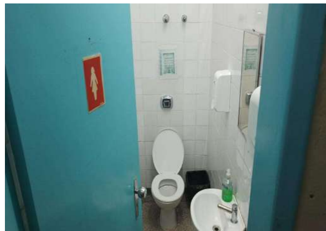
FOTO 58 BANHEIRO FEMININO ADMINISTRATIVO
