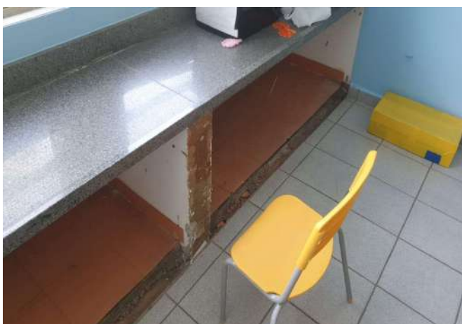
FOTO 95 SALA DE AULA 2 EM MANUTENÇÃO
