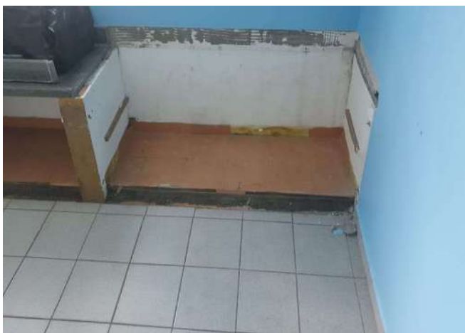
FOTO 115 SALA DE AULA 4 EM MANUTENÇÃO
