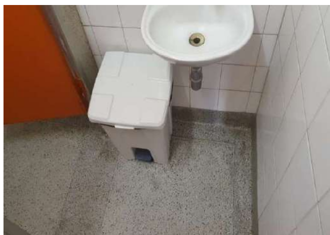
FOTO 132 BANHEIRO FEMININO DE FUNCIONÁRIO
