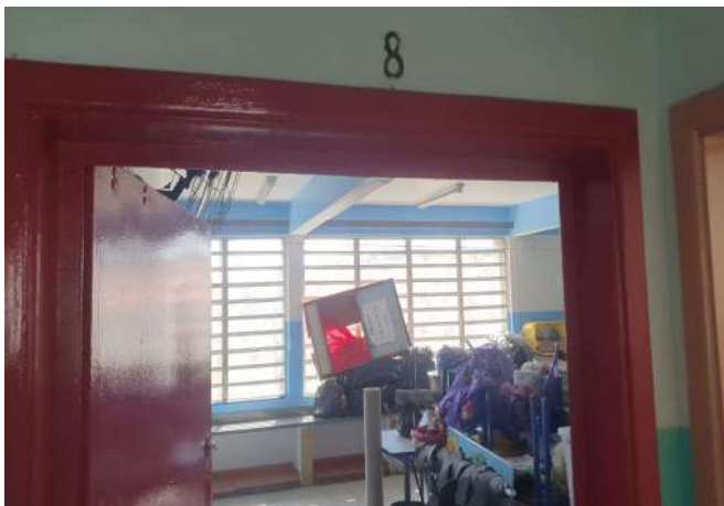
FOTO 157 SALA DE AULA 8
