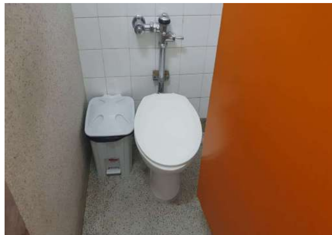
FOTO 134 BANHEIRO FEMININO DE FUNCIONÁRIO
