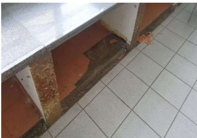
FOTO 93 SALA DE AULA 2 EM MANUTENÇÃO
