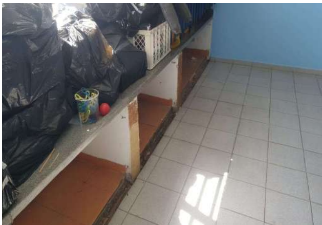
FOTO 163 SALA DE AULA 8 EM MANUTENÇÃO
