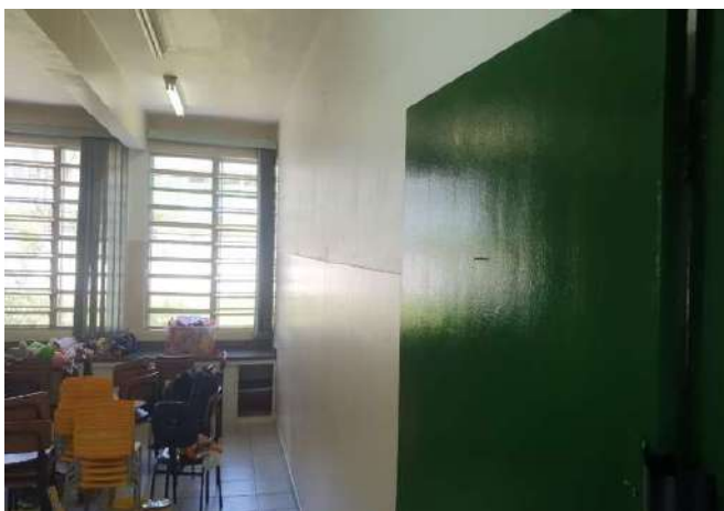
FOTO 77 SALA DE AULA 2
