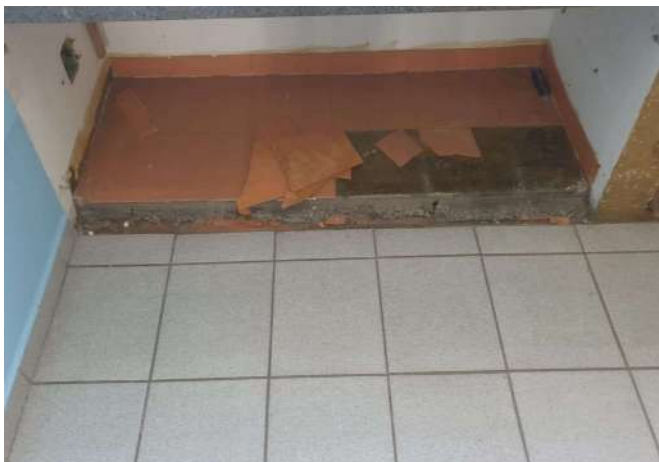
FOTO 91 SALA DE AULA 2 EM MANUTENÇÃO
