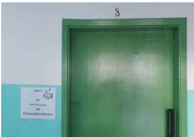
FOTO 107 SALA DE AULA 3
