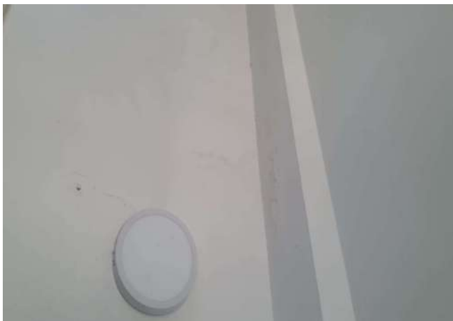
FOTO 229 CASA DE MÁQUINA DO ELEVADOR
