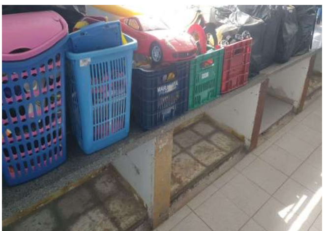
FOTO 131 SALA DE AULA 5 EM MANUTENÇÃO
