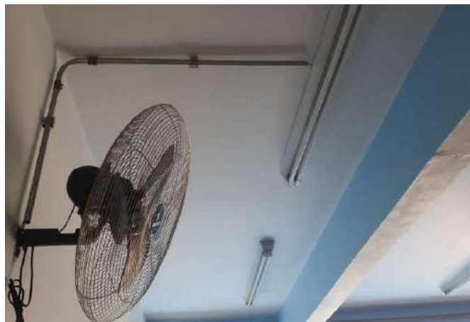
FOTO 8 SALA DE AULA 1
