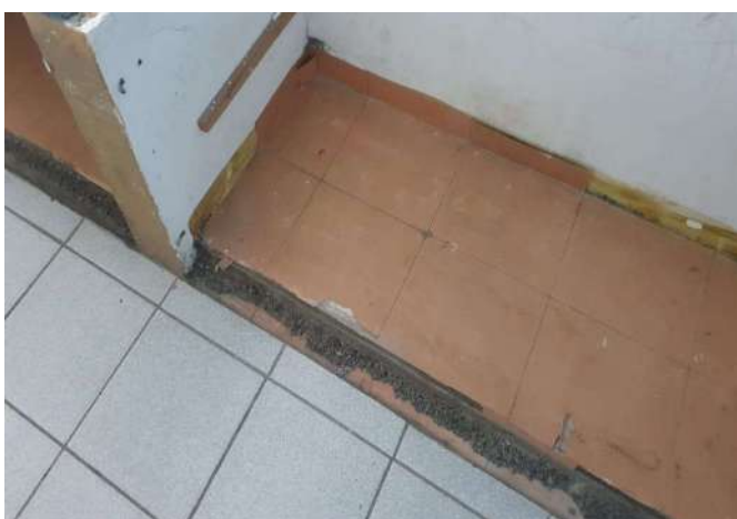
FOTO 117 SALA DE AULA 4 EM MANUTENÇÃO
