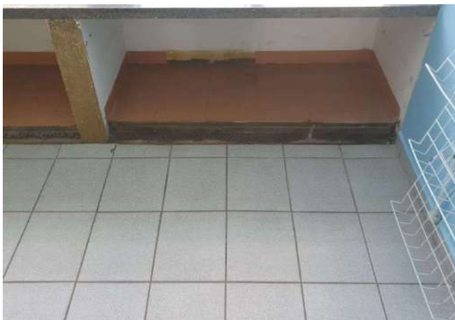
FOTO 209 SALA DE AULA 3 EM MANUTENÇÃO
