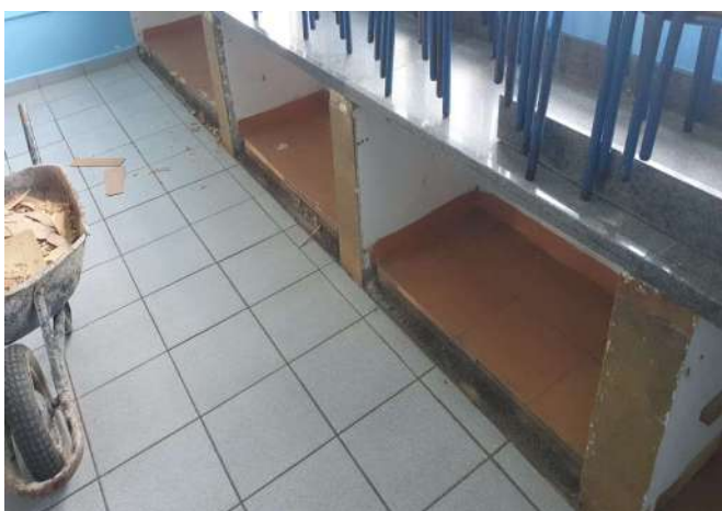
FOTO 119 SALA DE AULA 4 EM MANUTENÇÃO
