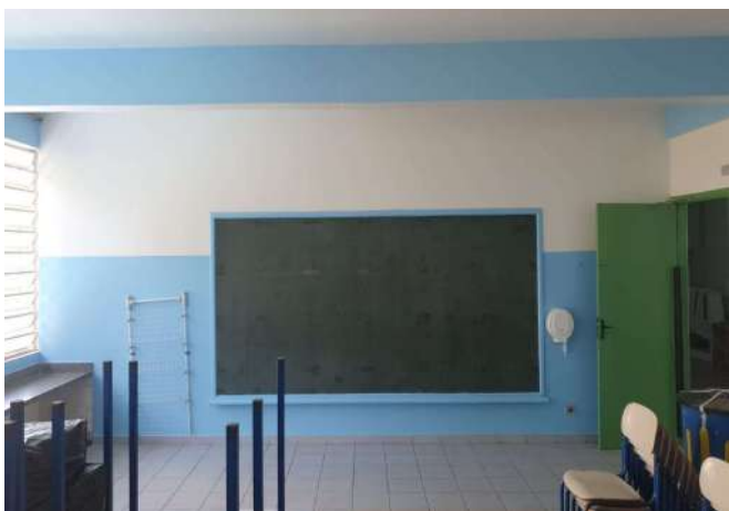
FOTO 5 SALA DE AULA 1
