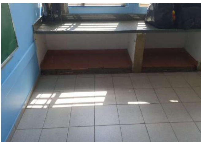
FOTO 161 SALA DE AULA 8 EM MANUTENÇÃO
