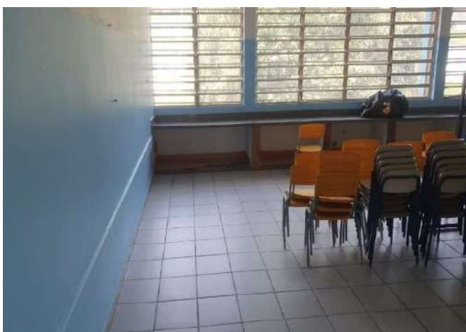
FOTO 89 SALA DE AULA 2 EM MANUTENÇÃO
