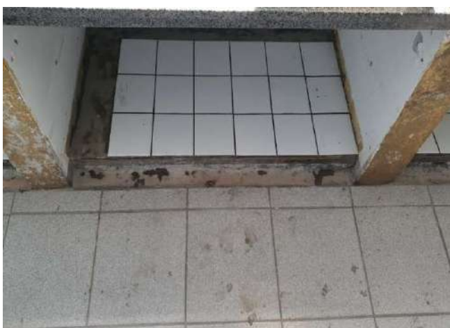
FOTO 143 SALA DE AULA 6 EM MANUTENÇÃO
