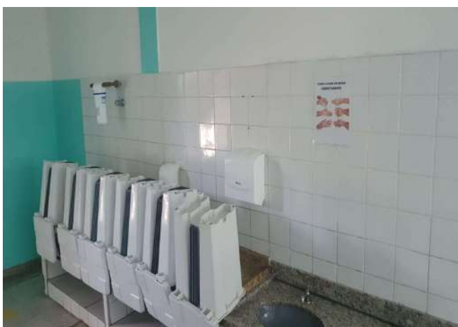
FOTO 75 LAVATÓRIO NO CORREDOR INTERNO
