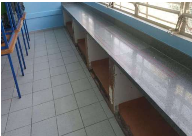
FOTO 211 SALA DE AULA 3 EM MANUTENÇÃO
