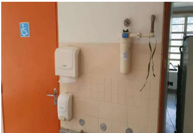
FOTO 7 SANITÁRIO DE DEFICIENTE
