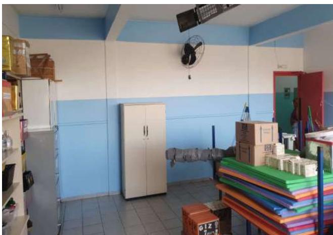
FOTO 167 SALA DE AULA 8 COM IMPROVISOS NA ELÉTRICA
