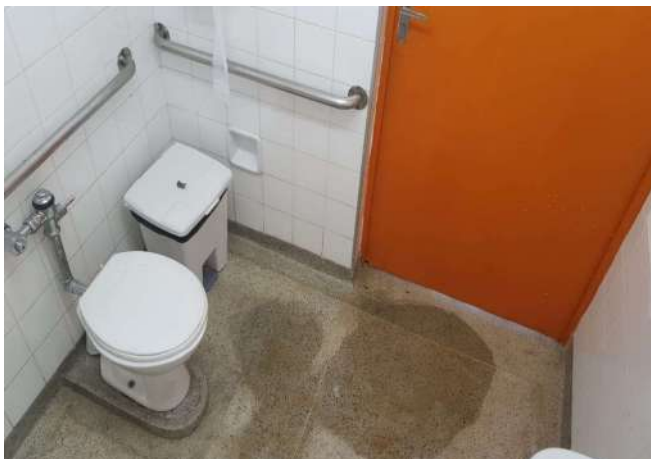
FOTO 43 BANHEIRO ACESSÍVEL DE ALUNOS UNISSEX
