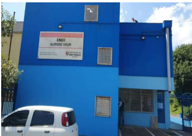
FOTO 215 FACHADA FRONTAL DA UNIDADE ESCOLAR
