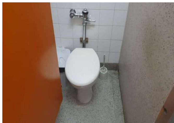
FOTO 136 BANHEIRO FEMININO DE FUNCIONÁRIO
