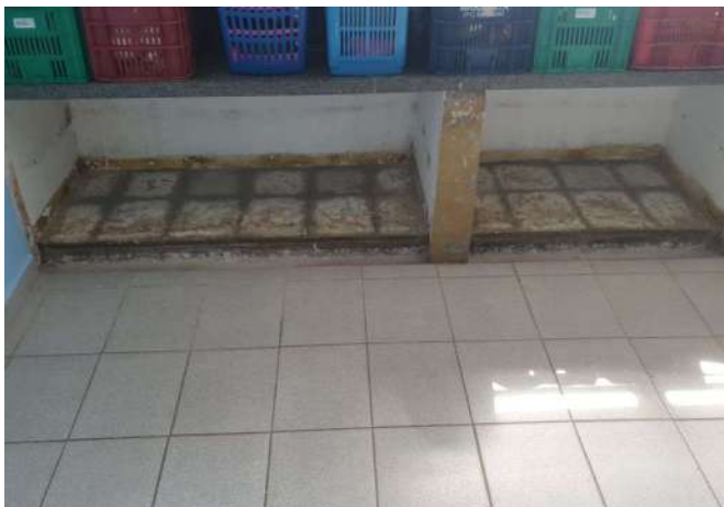
FOTO 127 SALA DE AULA 5 EM MANUTENÇÃO
