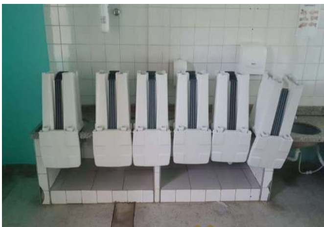
FOTO 71 LAVATÓRIO NO CORREDOR INTERNO
