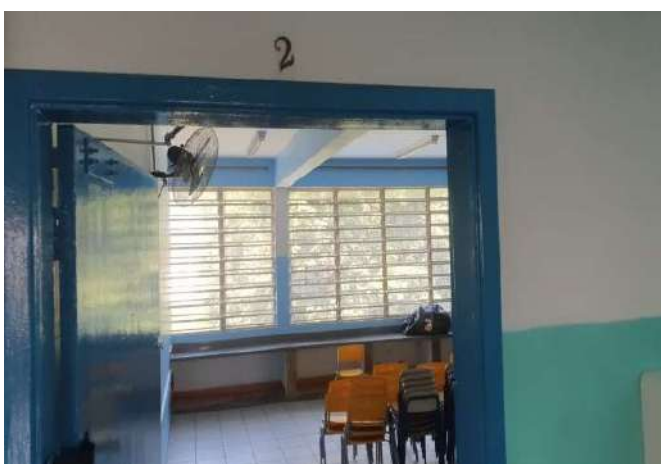
FOTO 87 SALA DE AULA 2
