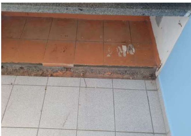
FOTO 165 SALA DE AULA 8 EM MANUTENÇÃO
