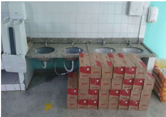
FOTO 73 LAVATÓRIO NO CORREDOR INTERNO
