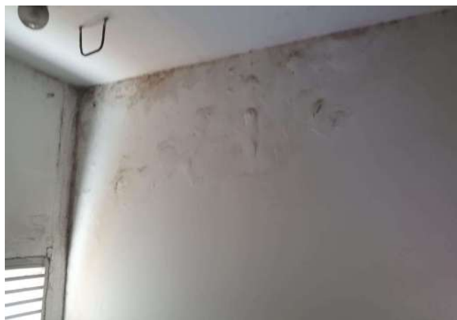
FOTO 222 CASA DE MÁQUINA DO ELEVADOR
