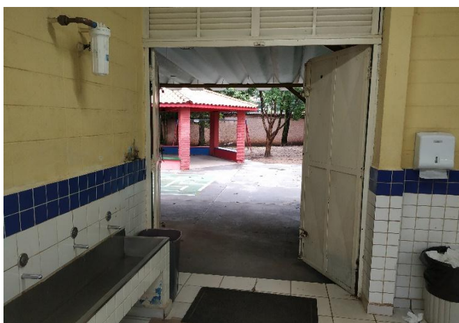
FOTO 21 Portão acesso a área externa.
