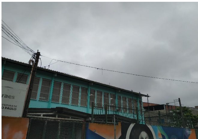
FOTO 1 Entrada de serviço, vista ampla.
