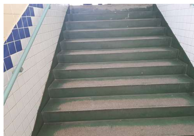
FOTO 18 Imagem ampla da escada
