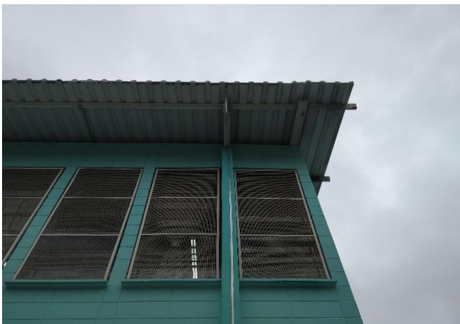
FOTO 7 Descida da barra chata.
