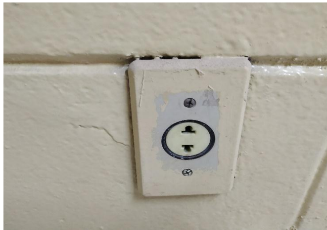
FOTO 68 Tomada padrão americano antigo, substituir por padrão brasileiro, sala da gestão.
