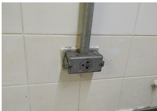
FOTO 76 Tomada padrão americano antigo, substituir por padrão brasileiro. Cozinha.
