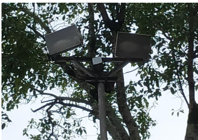
FOTO 63 Refletores com lâmpadas de vapor de sódio, inoperantes. Quadra poliesportiva.
