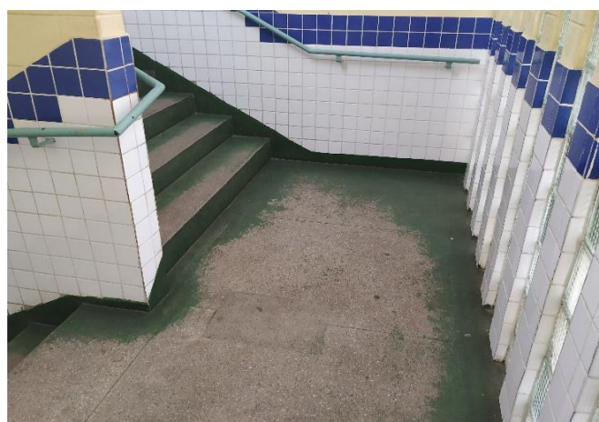
FOTO 24 Patamar da escadaria.
