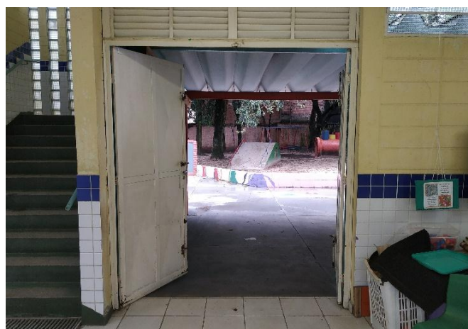
FOTO 22 Portão acesso a área externa.
