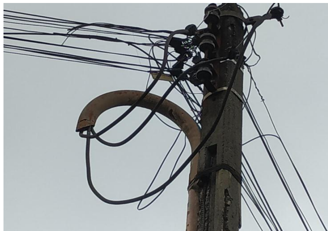
FOTO 2 Entrada de serviço.
