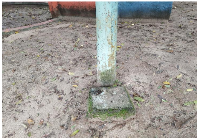
FOTO 62 Base do poste de concreto.
