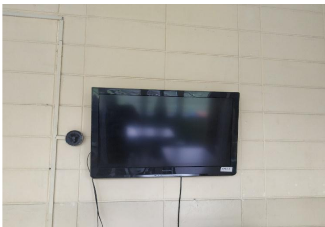
FOTO 95 Televisor instalado na sala de aula 2.
