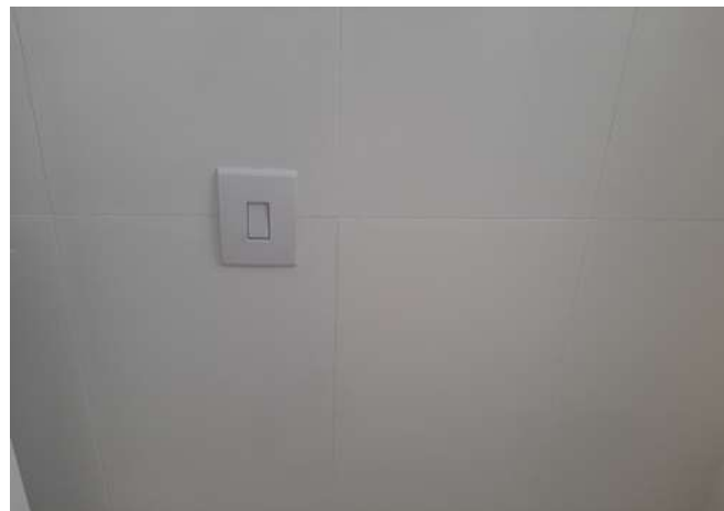
FOTO 14 Interruptor banheiro funcionários
