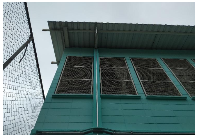
FOTO 4 Descida da barra chata.
