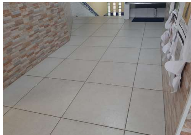
FOTO 22 Circulação horizontal, corredor das salas
