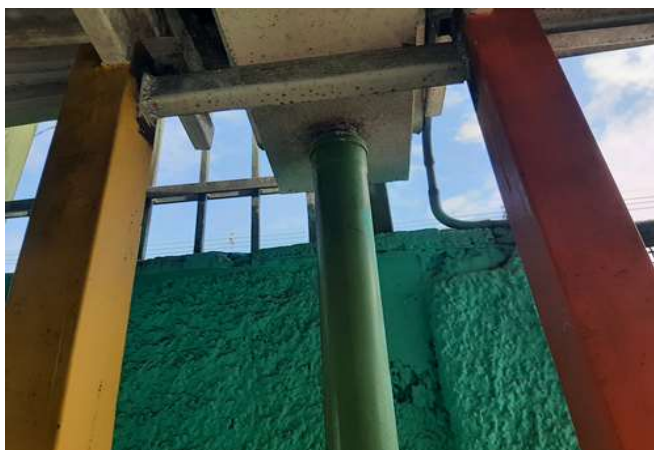
FOTO 35 Calha cobertura do pátio
