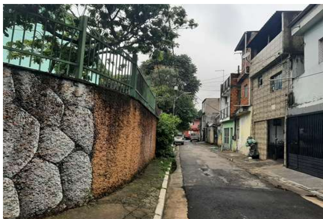
FOTO 3 Iluminação Pública, falta sinalização de vagas para idosos e PNE
