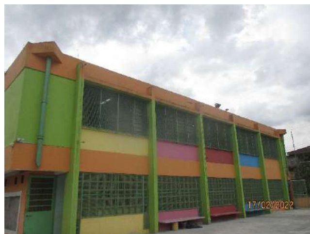
FOTO 3 FACHADA LATERAL ESQUERDA
