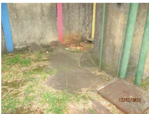
FOTO 10 RESERVATÓRIO DE ÁGUA
