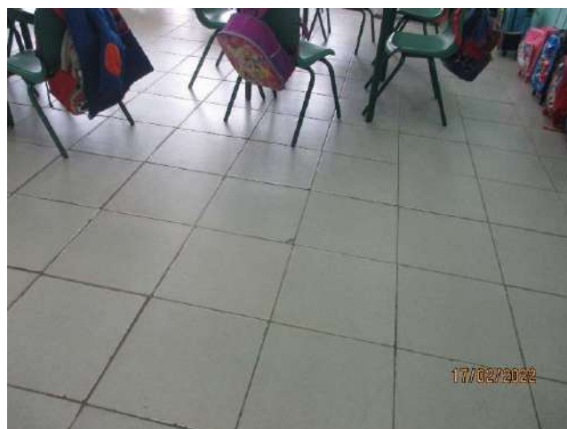
FOTO 30 SALA DE AULA 01
