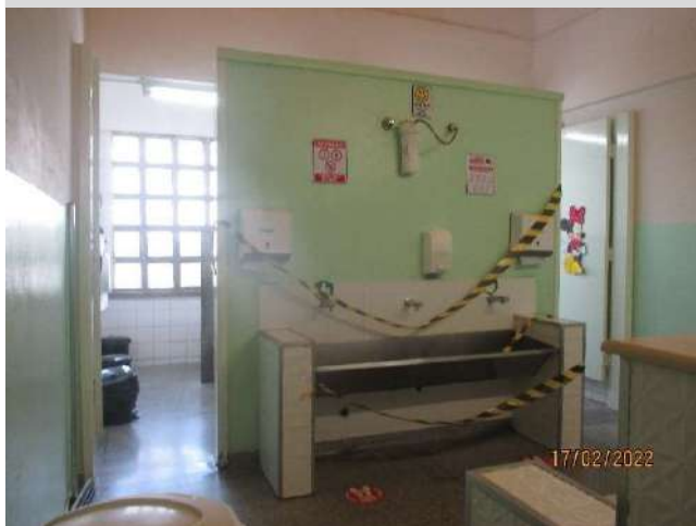
FOTO 59 HALL SANITÁRIOS PAVIMENTO SUPERIOR
