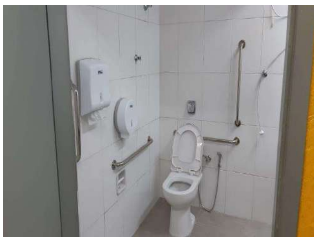
FOTO 82 SANITÁRIO PCD TÉRREO
