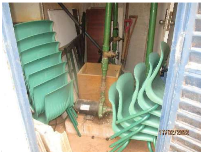
FOTO 11 RESERVATÓRIO DE ÁGUA
