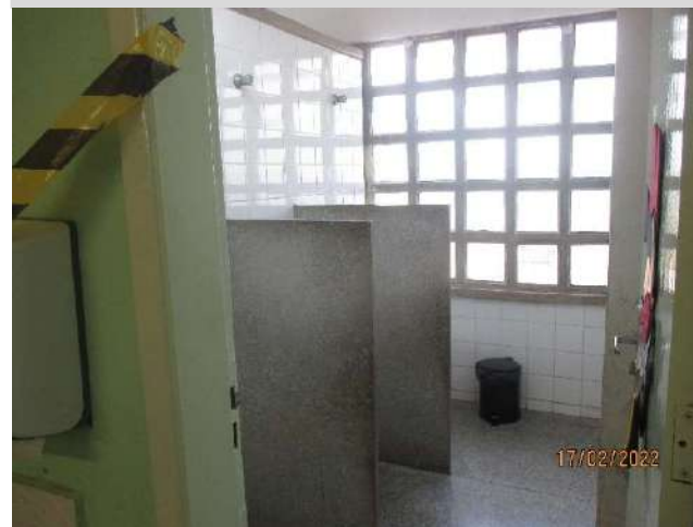
FOTO 60 SANITÁRIO FEMININO ALUNOS PAVIMENTO SUPERIOR
