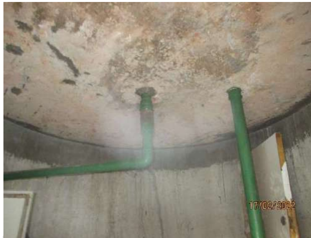
FOTO 12 RESERVATÓRIO DE ÁGUA
