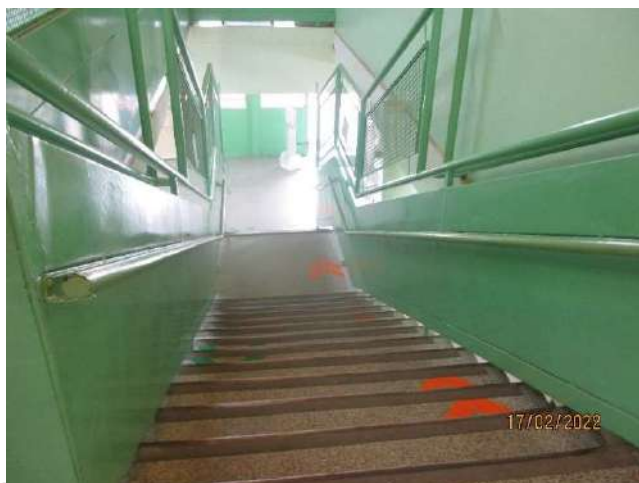
FOTO 43 ACESSO PISO TÉRREO
