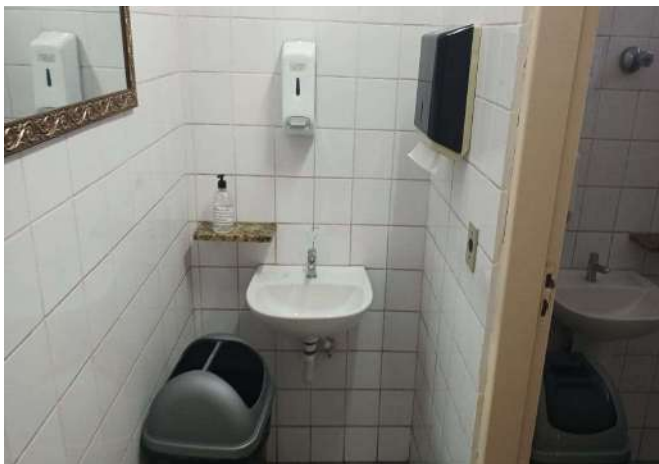
FOTO 217 BANHEIRO DE FUNCIONARIOS FEMININO
