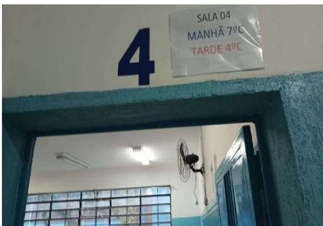
FOTO 183 SALA DE AULA 4
