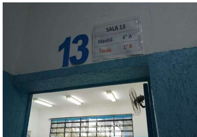
FOTO 246 SALA DE AULA 13
