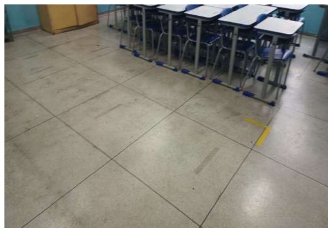
FOTO 184 SALA DE AULA 4
