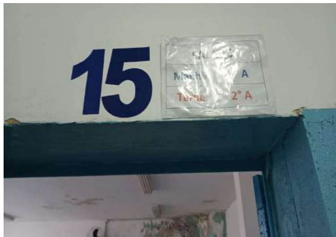
FOTO 266 SALA DE AULA 15
