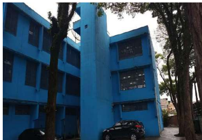
FOTO 306 FACHADA LATERAL ESQUERDA
