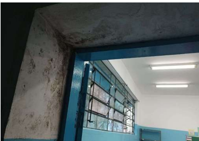
FOTO 197 JUNTA DE DILATAÇÃO DO BLOCO PRINCIPAL E ANEXO
