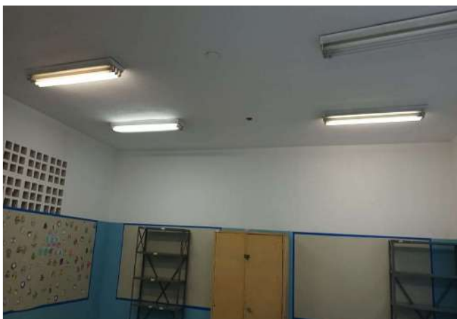
FOTO 185 SALA DE AULA 4
