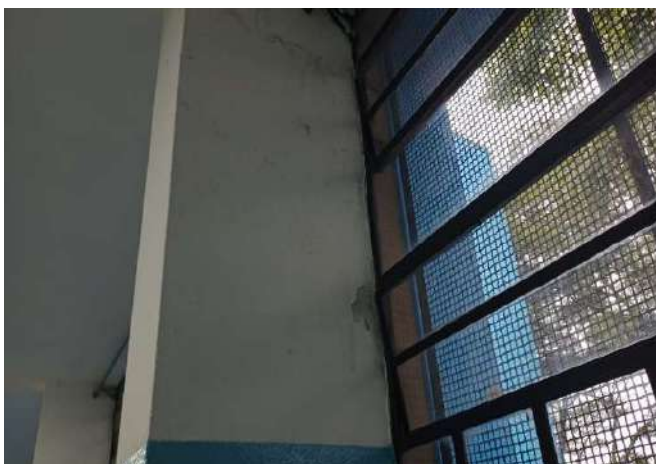
FOTO 251 SALA DE AULA 18 COM VEDAÇÃO DOS CAIXILHOS
