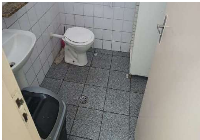
FOTO 218 BANHEIRO DE FUNCIONARIOS FEMININO
