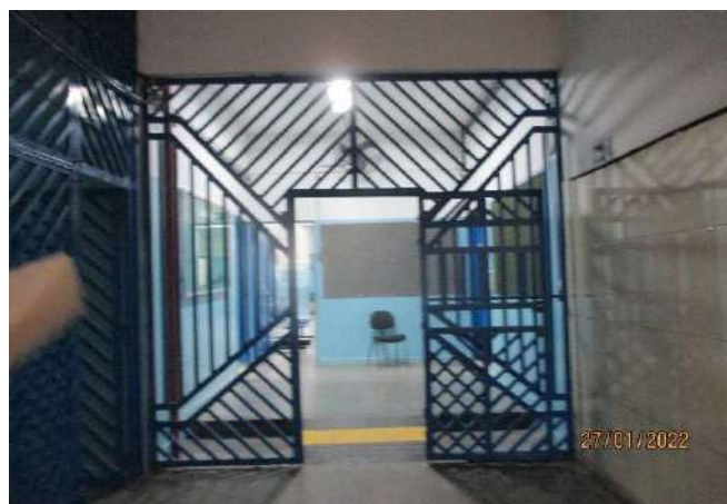
FOTO 23 ACESSO SECRETARIA / PÁTIO COBERTO
