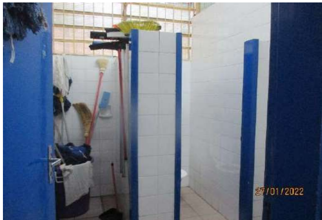
FOTO 43 VESTIÁRIO MASCULINO TERCEIRIZADA
