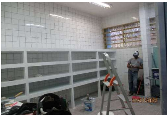
FOTO 49 DISPENSA (EM REFORMA)
