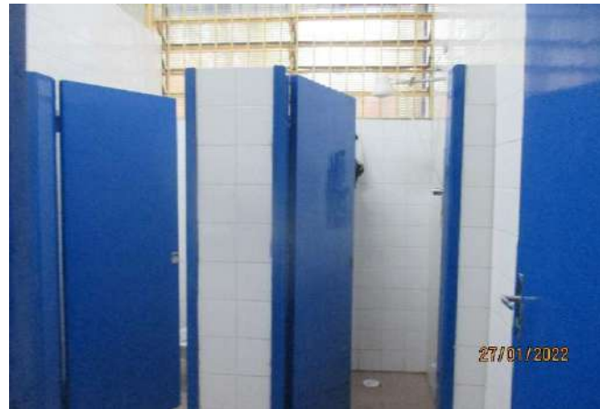
FOTO 44 VESTIÁRIO FEMININO TERCEIRIZADA
