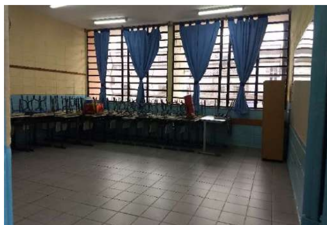
FOTO 98 SALA DE AULA 12
