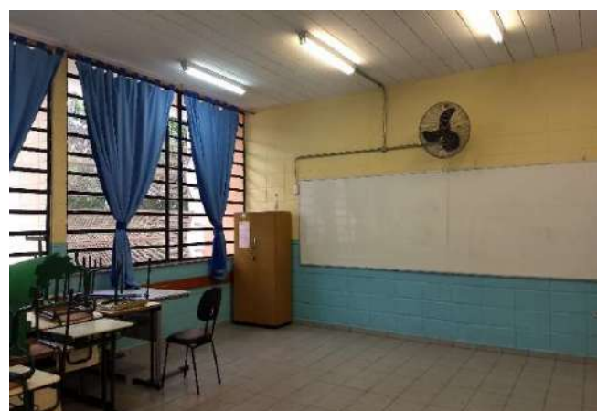
FOTO 112 SALA DE AULA 15
