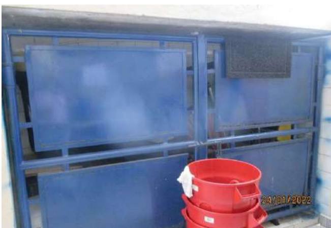
FOTO 63 DEPÓSITO UTENSÍLIOS LIMPEZA
