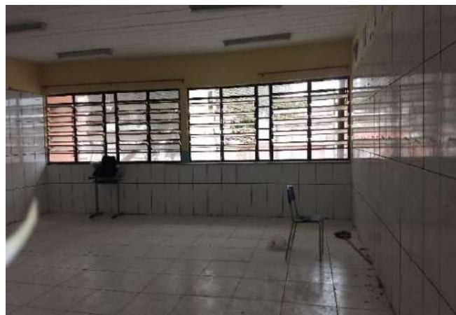
FOTO 82 SALA DE AULA 9 (EM REFORMA)
