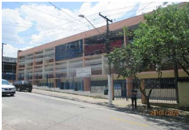
FOTO 1 FACHADA PRINCIPAL COM SUJIDADES
