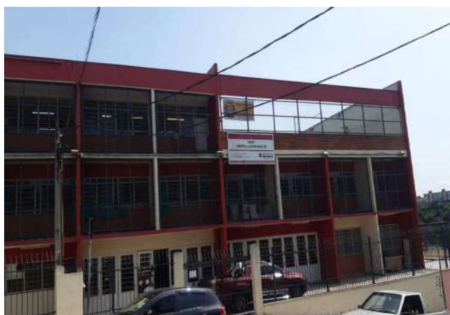
FOTO 5 FACHADA DA ESCOLA
