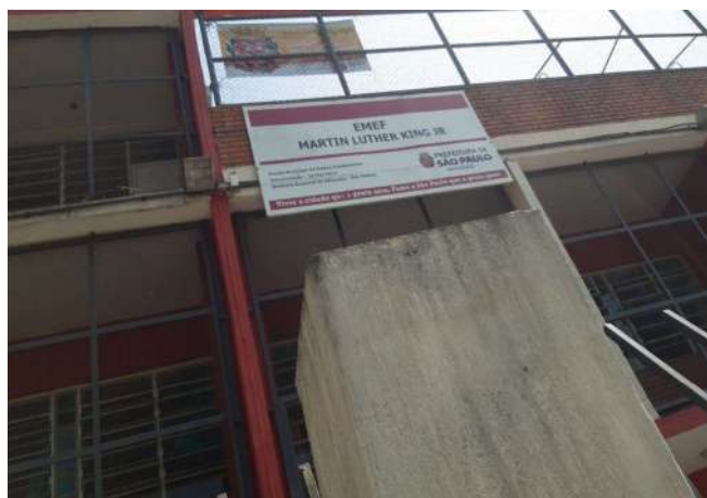
FOTO 4 PLACA IDENTIFICAÇÃO NA FACHADA
