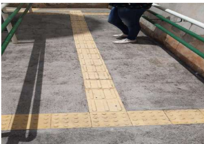
FOTO 27 RAMPAS DE ACESSO CONTAM COM PISO TÁTIL
