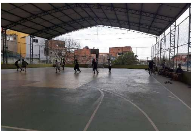
FOTO 63 Quadra coberta- Visão geral
