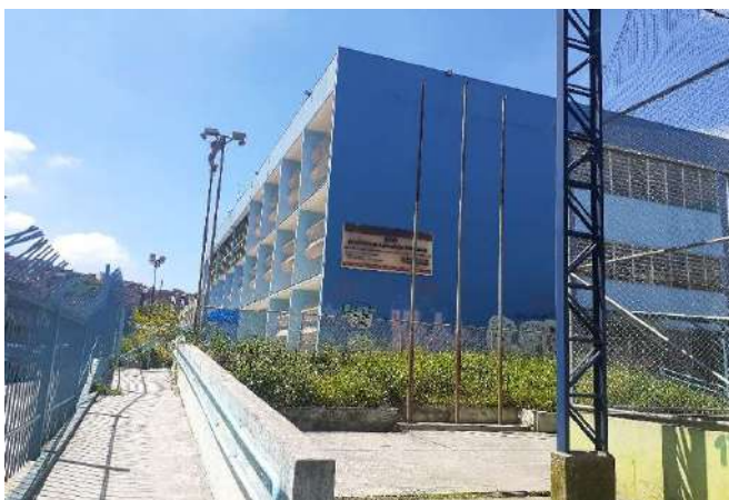
FOTO 1 Fachada / Entrada - Visão geral Placa
