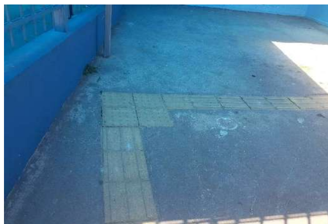
FOTO 106 Piso tátil - Visão Geral
