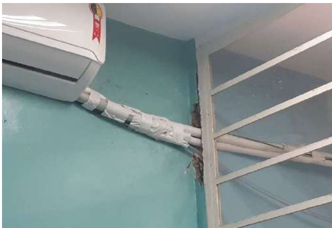
FOTO 85 Sala de Leitura - Abertura
