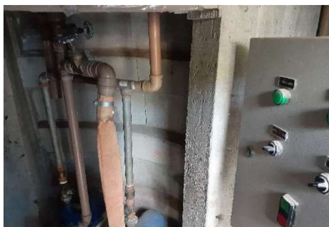
FOTO 35 Casa de máquinas da Caixa d' Água - Visão geral
