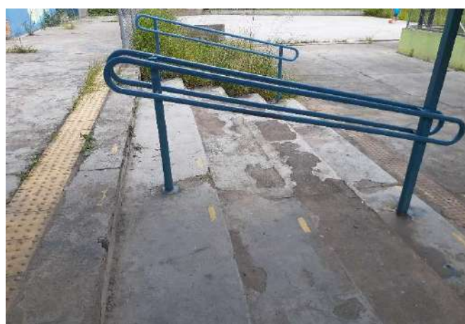
FOTO 14 Área Externa - Escada sem antiderrapante
