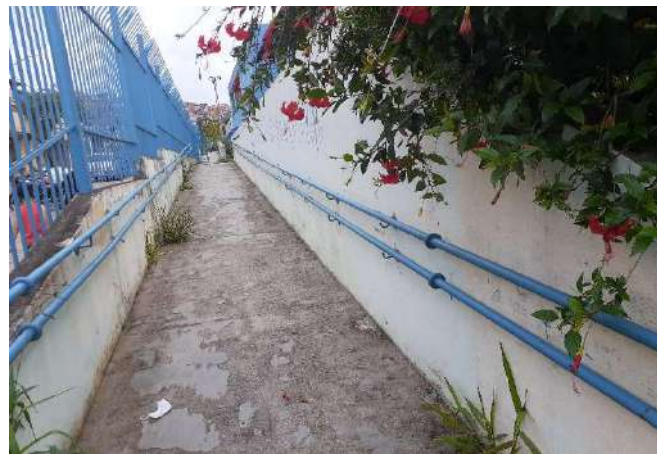
FOTO 6 Área Externa Rampa de Acesso - Visão geral
