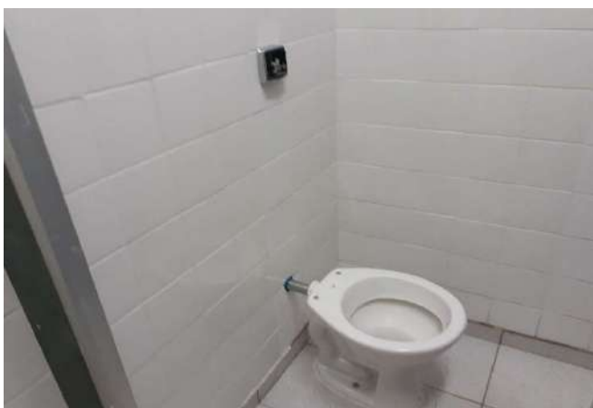
FOTO 105 Vestiário - Acabamento descarga flsntne
