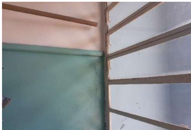
FOTO 104 Sala 13 - Trinca
