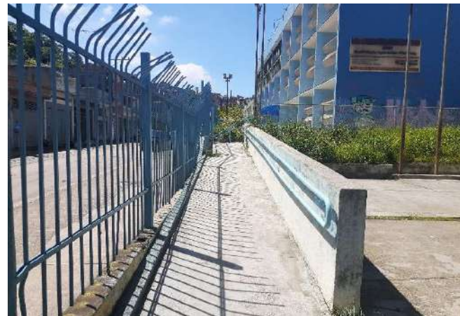
FOTO 4 Acesso - Rampa para aluno pne (deficiente)
