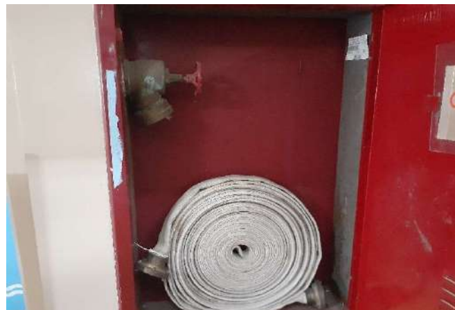
FOTO 104 Hidrante - Visão
