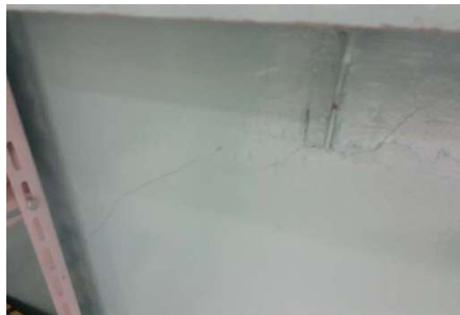
FOTO 104 Sala 12 - Trinca
