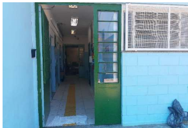
FOTO 2 Fachada / Entrada - Visão geral
