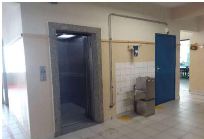
FOTO 104 Elevador - Visão geral
