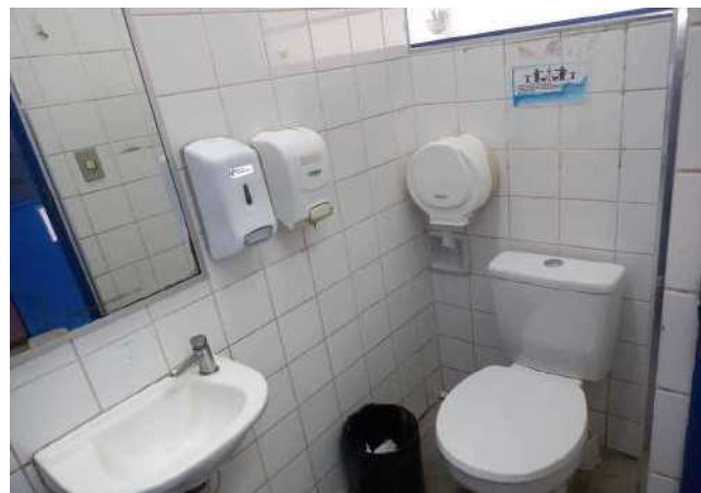
FOTO 56 Sanitário funcionário feminino - Visão geral
