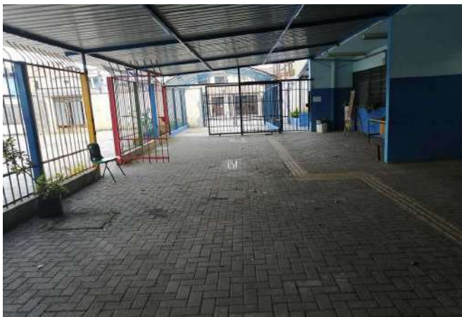
FOTO 13 Pátio Coberto - Visão geral
