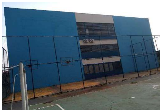
FOTO 66 Fachada de fundo da Unidade Escolar
