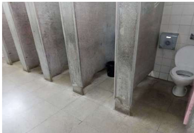
FOTO 50 Sanitário aluno feminino - Visão parcial
