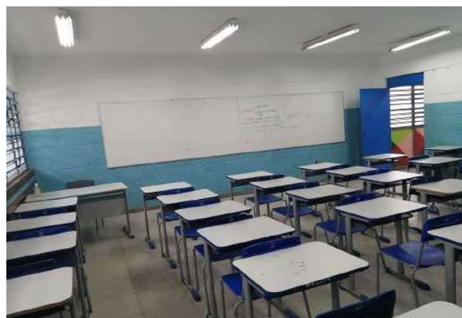
FOTO 30 Sala de Aula 06 - Visão geral
