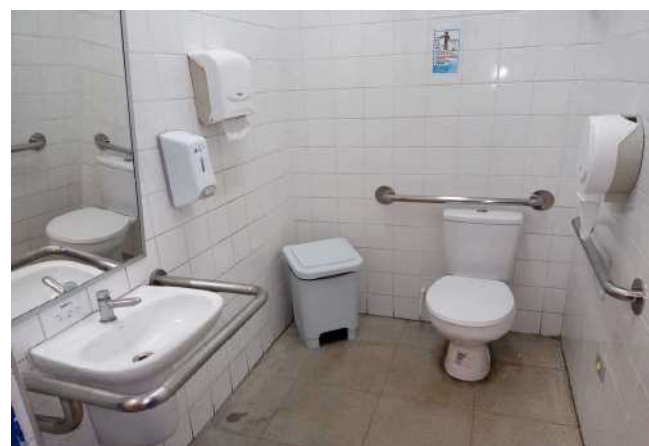
FOTO 57 Sanitário PNE funcionários Masculino - Visão geral
