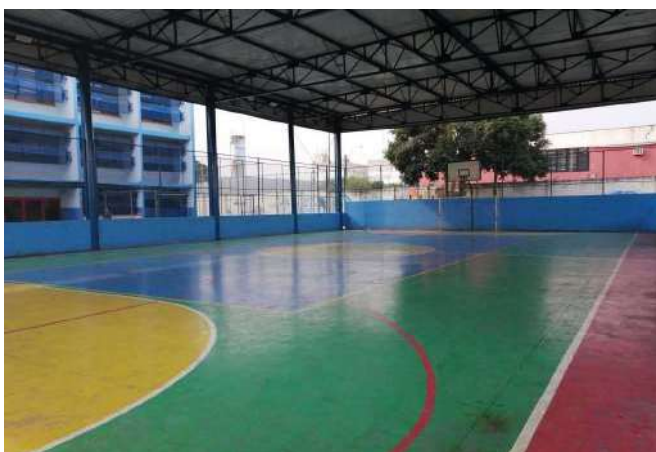
FOTO 17 Quadra Coberta - Visão geral
