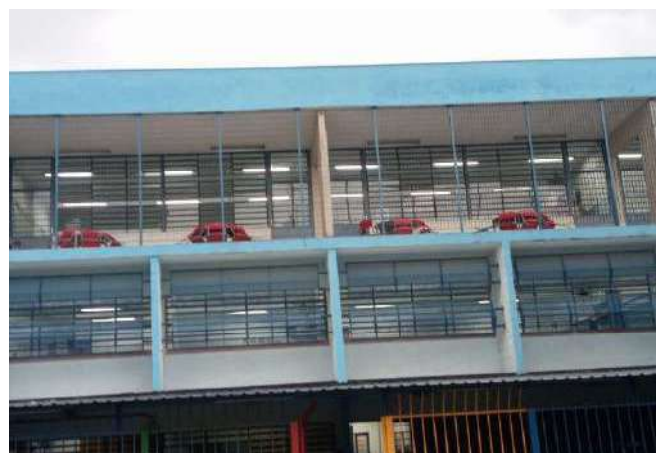
FOTO 64 Fachada lateral direita da Unidade Escolar
