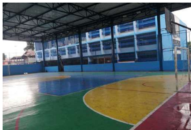
FOTO 16 Quadra Coberta - Visão geral
