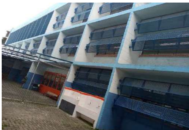
FOTO 63 Fachada lateral esquerda da Unidade Escolar
