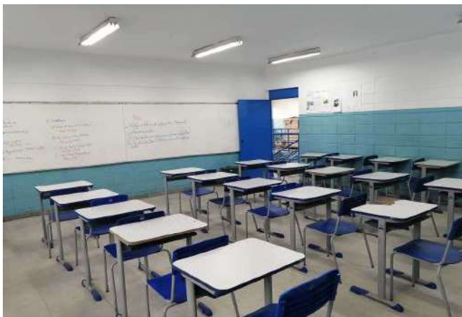
FOTO 31 Sala de Aula 07 - Visão geral
