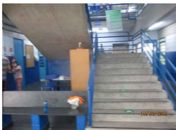
FOTO 50 ESCADA 1 ACESSO PISO INTERMEDIÁRIO
