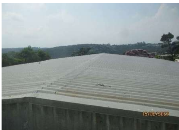
FOTO 161 TELHADO QUADRA DE ESPORTES
