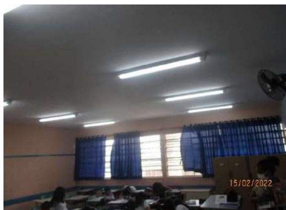
FOTO 128 SALA DE AULA 02
