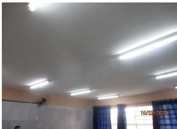
FOTO 141 SALA 03 COM VIDRO QUEBRADO
