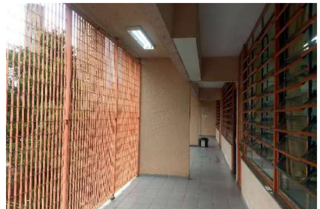
FOTO 116 VARANDA FACHADA POSTERIOR
