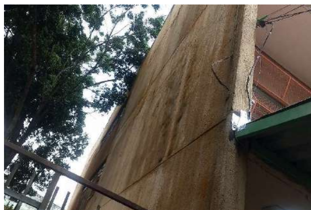
FOTO 116 FACHADA LATERAL DIREITA
