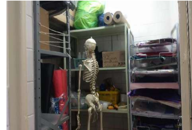
FOTO 120 SALA MATERIAL PEDAGÓGICO COM INFILTRAÇÃO NA PAREDE
