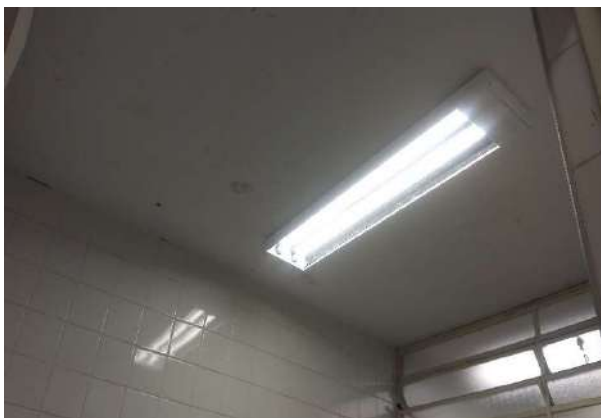
FOTO 89 SANITÁRIO ALUNO MASCULINO PRIMEIRO PAVIMENTO
