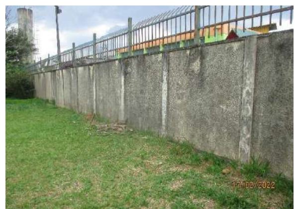
FOTO 6 MURO DIVISA LATERAL ESQUERDA
