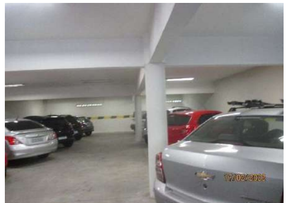
FOTO 12 ESTACIONAMENTO VAGAS COBERTAS
