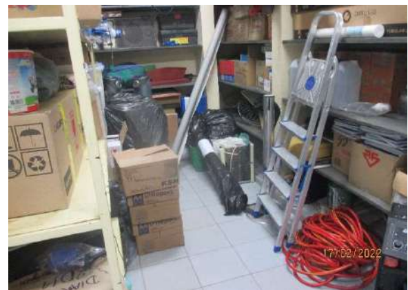
FOTO 28 ALMOXARIFADO COM SUJEIRAS NA PAREDE E FORRO
