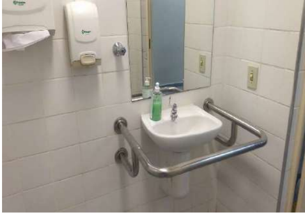
FOTO 85 SANITÁRIO PCD PRIMEIRO PAVIMENTO
