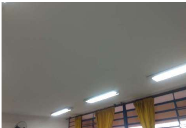
FOTO 119 SALA DE AULA 14 COM INFILTRAÇÃO
