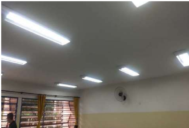
FOTO 75 SALA DE AULA 04
