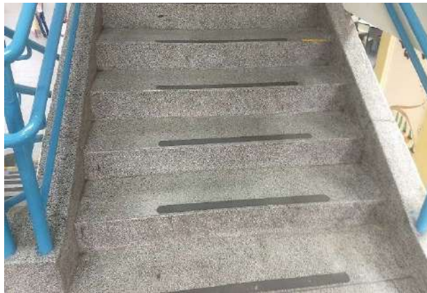
FOTO 67 ACESSO SEGUNDO PAVIMENTO
