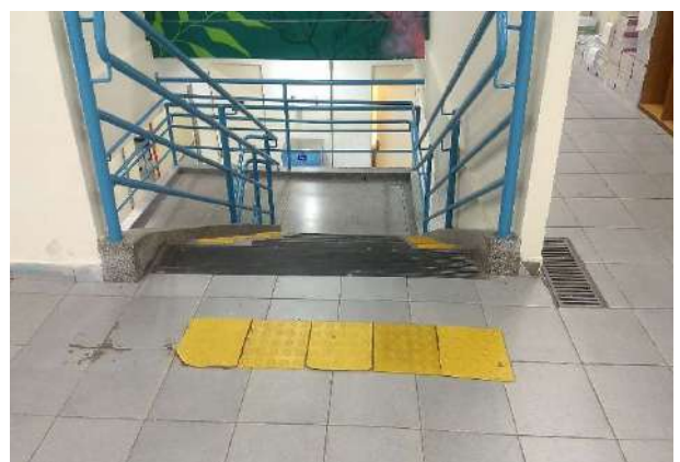
FOTO 108 ESCADA ACESSO SEGUNDO / TERCEIRO PAVIMENTO
