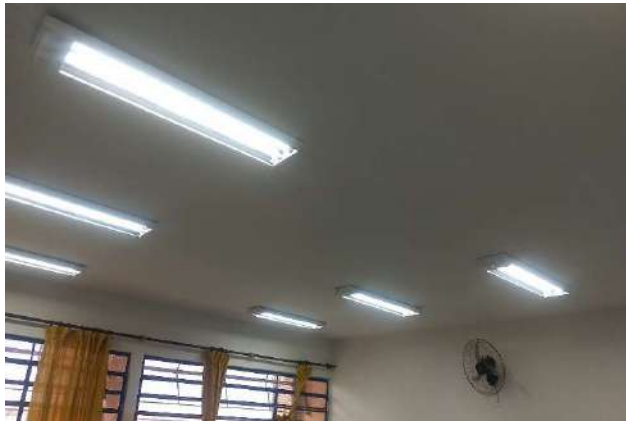
FOTO 97 SALA DE AULA 09
