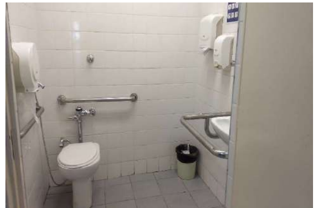
FOTO 84 SANITÁRIO PCD PRIMEIRO PAVIMENTO
