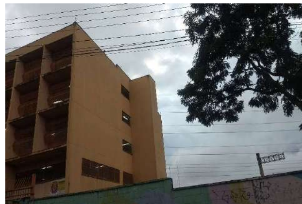
FOTO 118 FACHADA LATERAL DIREITA
