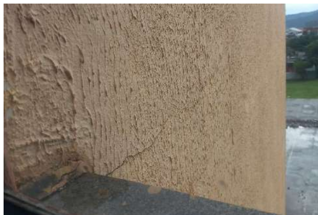
FOTO 115 FACHADA LATERAL DIREITA
