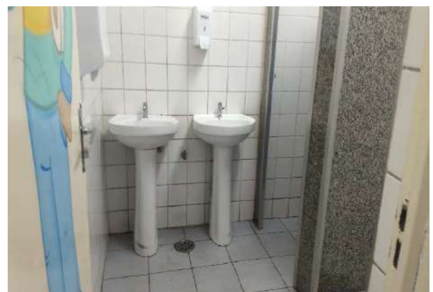
FOTO 88 SANITÁRIO ALUNO MASCULINO PRIMEIRO PAVIMENTO
