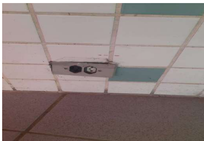
FOTO 76 Reparo na tomada no palco do pátio
