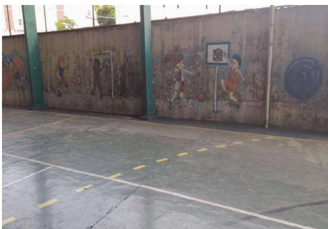
FOTO 5 Pintura geral das grades e paredes da quadra de esportes
