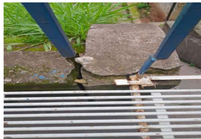
FOTO 42 Reparo no gradil e muro de acesso às águas pluviais no lado externo da cozinha
