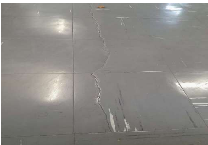
FOTO 57 Reparo no piso de entrada da sala de coordenação
