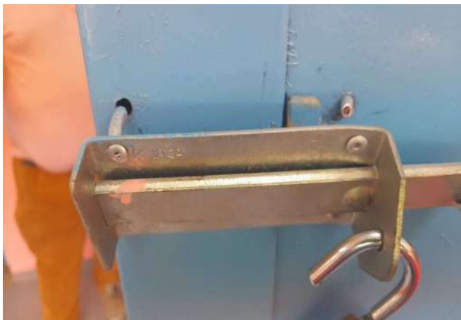
FOTO 1 Reparo na fechadura do banheiro masculino do piso
