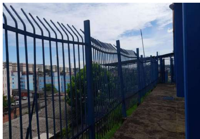
FOTO 58 Manutenção no gradil aproximadamente 200 metros
