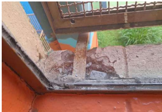
FOTO 14 Reparo no vidro frente a sala 11
