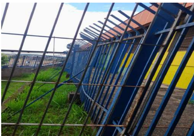
FOTO 39 Manutenção no gradil, aproximadamente 200 metros
