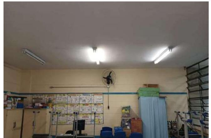
FOTO 38 SALA DE AULA 14, SISTEMA DE ILUMINAÇÃO INEFICIENTE E COM LÂMPADAS QUEIMADAS.
