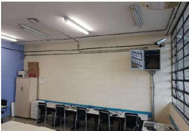
FOTO 49 SALA DE INFORMÁTICA COM IMPROVISO NA REDE ELÉTRICA.
