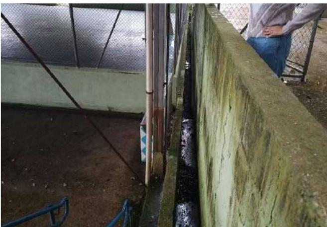
FOTO 113 QUADRA DE ESPORTES CANALETA EM MAU ESTADO DE CONSERVAÇÃO E MUROS COM FISSURAS.
