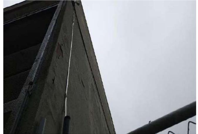
FOTO 110 FACHADA COM PARTES SOLTAS E INFILTRAÇÃO.
