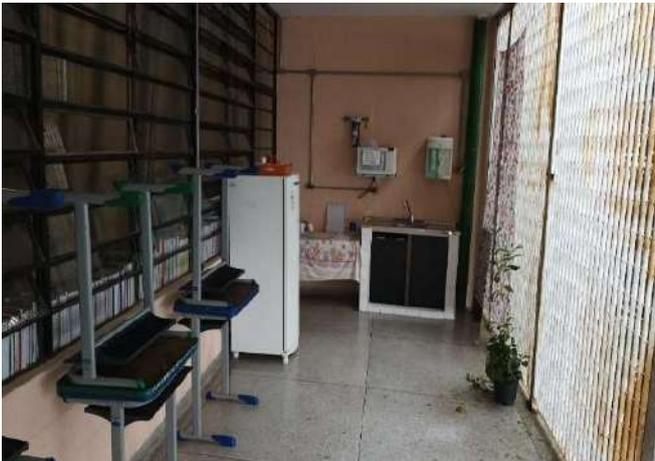
FOTO 31 SALA DOS PROFESSORES COM COPA IMPROVISO NA LIGAÇÃO HIDRÁULICA.
