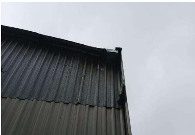
FOTO 129 QUADRA DE ESPORTES COBERTURA DANIFICADA E CONDUTORES DE ÁGUA.
