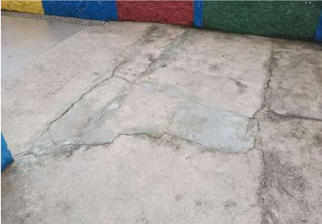
FOTO 169 FISSURAS CIMENTADO, ÁREA EXTERNA.
