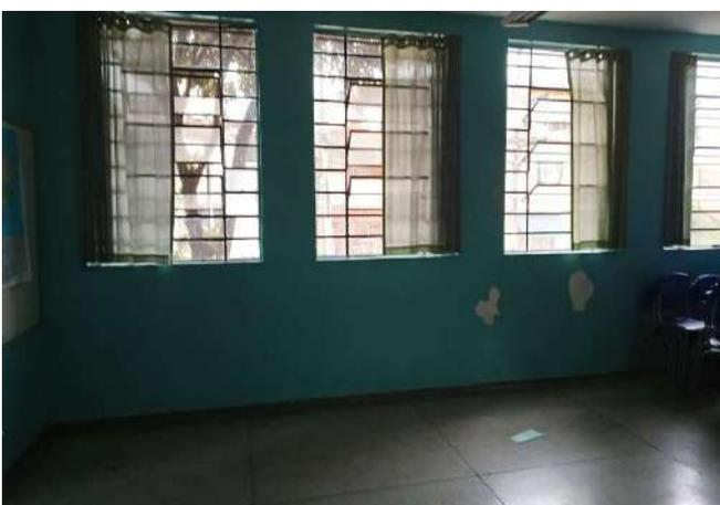
FOTO 113 SALA DE AULA 06 REVESTIMENTO DE PINTURA DESPLACANDO
