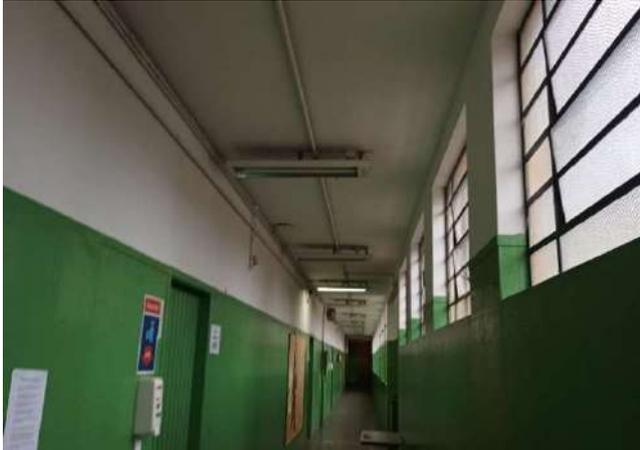
FOTO 79 CORREDOR INTERNO NECESSITA REVISÃO NA ILUMINAÇÃO
