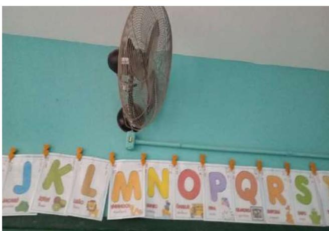
FOTO 90 SALA DE AULA 03 IMPROVISO NA REDE ELÉTRICA E DE VENTILAÇÃO
