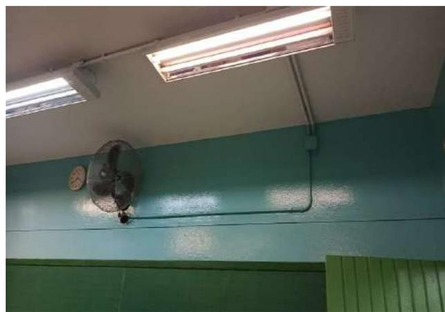
FOTO 140 SALA DE AULA 07 IMPROVISO NA REDE DE ALIMENTAÇÃO DO VENTILADOR
