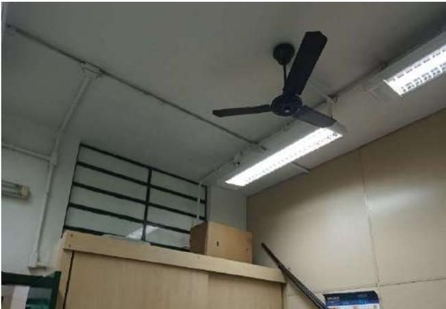
FOTO 19 SALA DA DIREÇÃO E COOR. IMPROVISO NA REDE ELÉTRICA DE ILUMINAÇÃO E VENTILAÇÃO.
