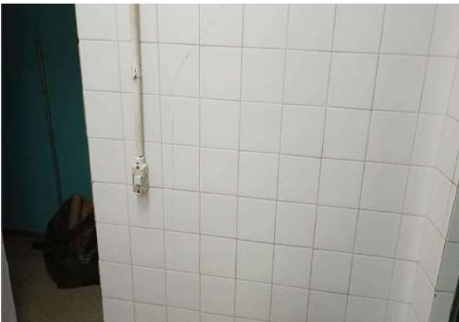
FOTO 57 COPA FUNCIONÁRIOS COM REVESTIMENTO CERÂMICO FISSURADO.
