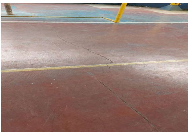
FOTO 5 TRINCAS NO PISO DA QUADRA COBERTA
