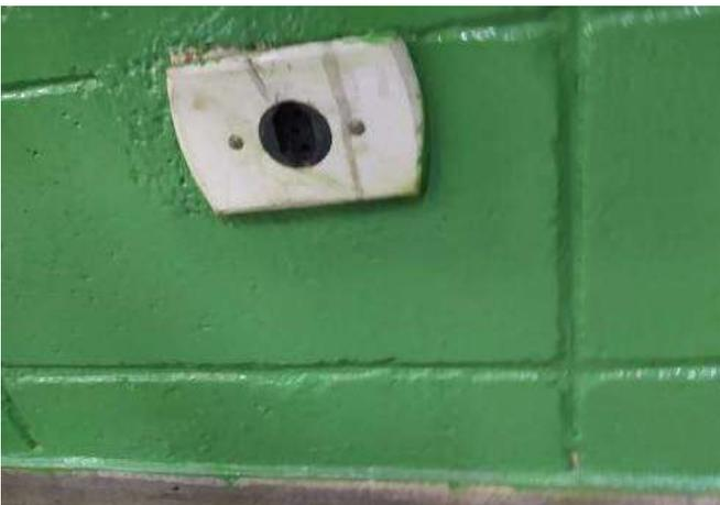
FOTO 69 Sala de aula 05, necessário revisão das instalações elétricas.
