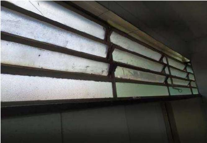
FOTO 19 Banheiro masculino dos alunos, necessário revisão dos caixilho com troca de vidros quebrados.
