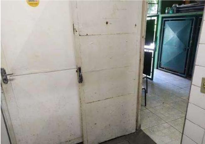
FOTO 31 Lavandaria, necessário pintura das portas metálicas, e troca de fechadura.
