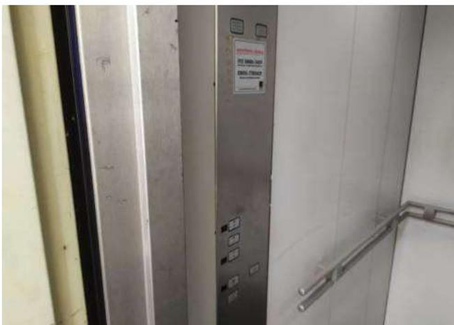
FOTO 51 Elevador, não funciona sirene nem o alarme não possui botoeira de emergência..
