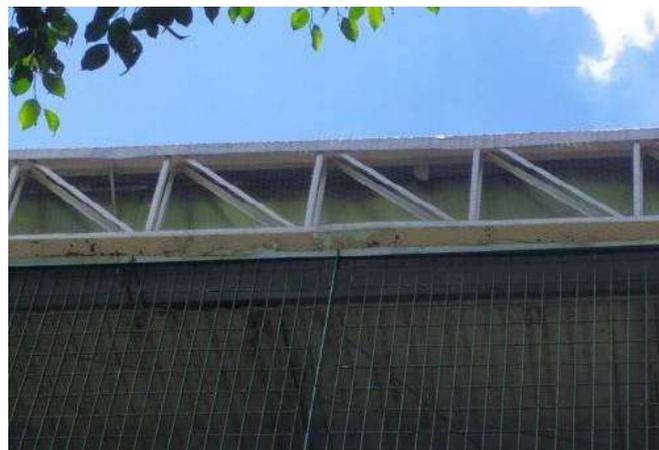
FOTO 140 Trelças metálicas da cobertura com alto nível de desgaste, com buracos em sua estrutura.
