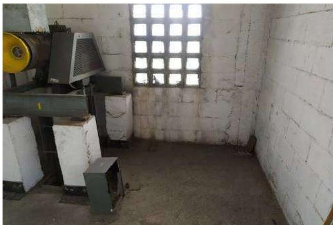
FOTO 149 Casa de máquinas do elevador, necessita de pintura das paredes, teto e piso.
