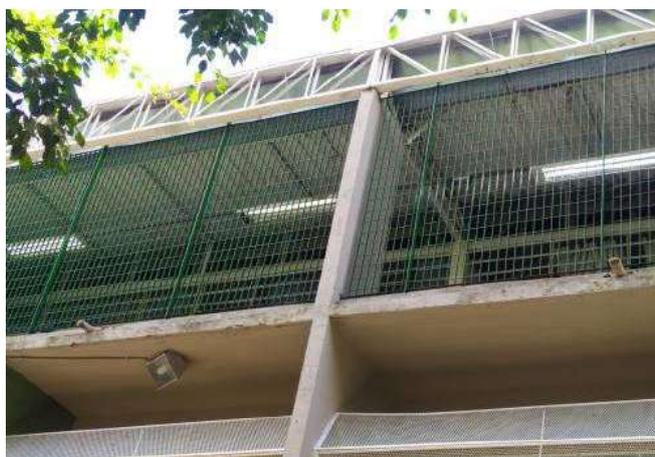
FOTO 141 Trelças metálicas da cobertura com alto nível de desgaste, com buracos em sua estrutura.
