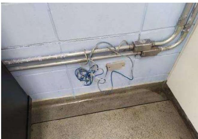
FOTO 125 Sala da direção, necessário revisão das instalações elétricas.
