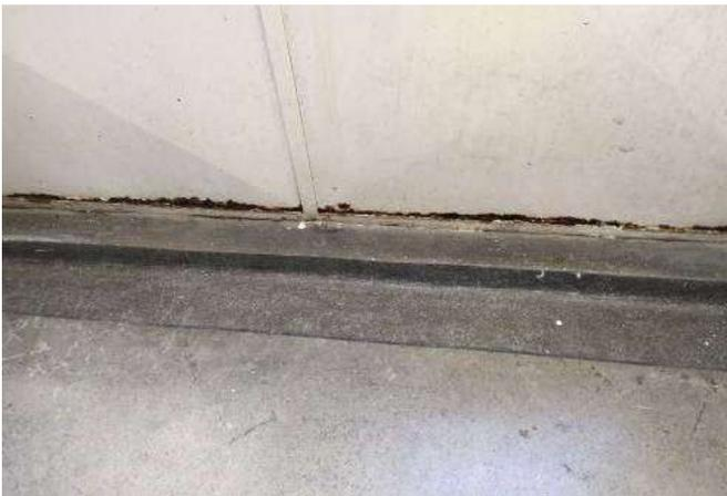
FOTO 87 Depósito 03 no corredor do pavimento superior 01, necessário reparos e pintura dos caixilhos.
