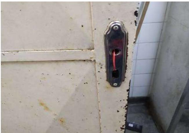
FOTO 33 Vestiário dos funcionários de limpeza, necessário troca de fechadura danificada.
