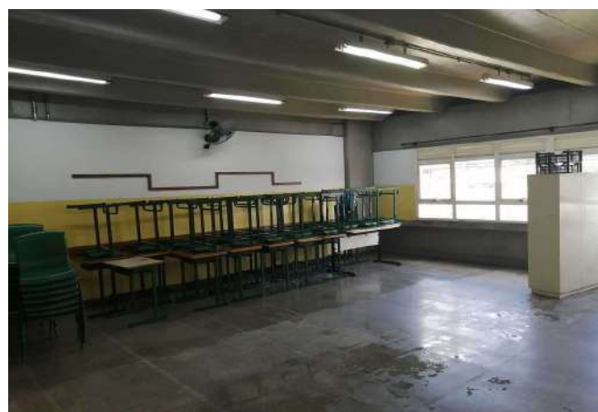
FOTO 48 Sala de Aula 05 - Visão geral
