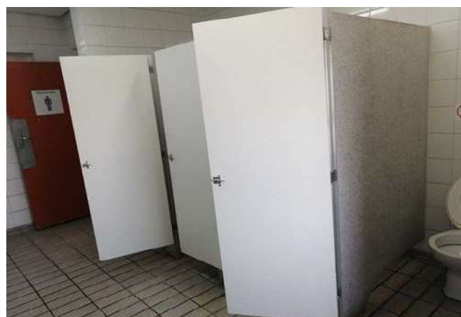
FOTO 88 Sanitário masculino aluno - Visão parcial
