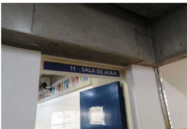
FOTO 39 Sala de Aula 01 - Identificação
