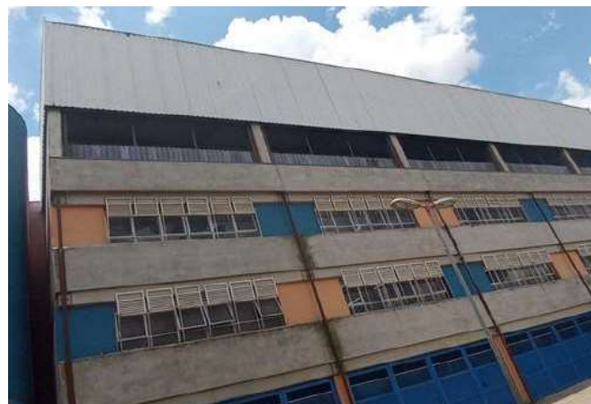
FOTO 98 Fachada dos fundos da Unidade Escolar. Terreo, 1º e 2º andar salas, e o 3º a quadra poliesportiva
