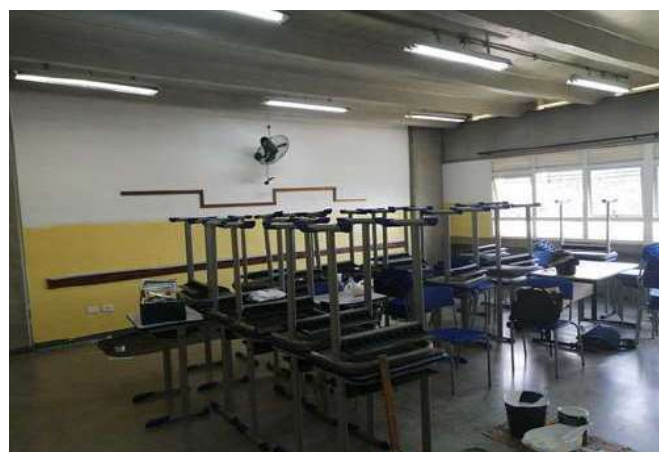
FOTO 66 Sala de Aula 13 - Visão geral
