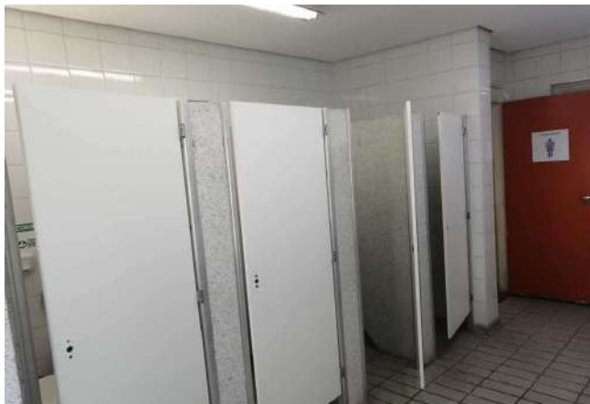
FOTO 79 Sanitário masculino aluno - Visão parcial
