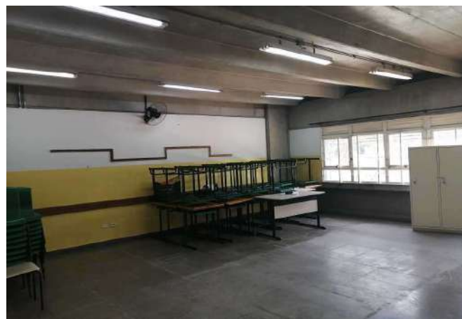
FOTO 42 Sala de Aula 02 - Visão geral
