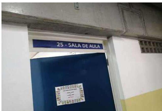
FOTO 69 Sala de Aula 15 - Identificação
