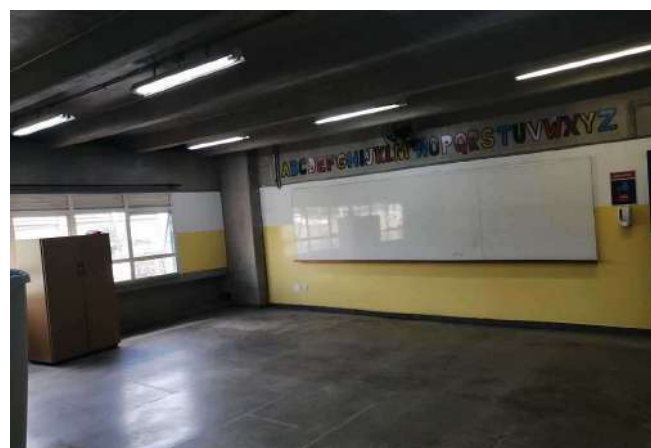
FOTO 40 Sala de Aula 01 - Visão geral
