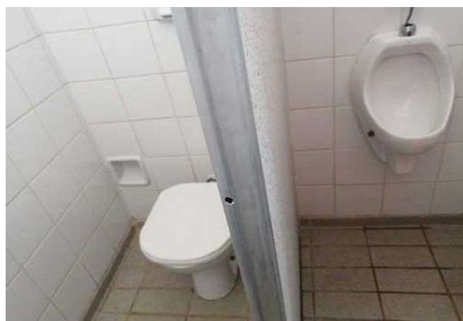
FOTO 82 Sanitário masculino administração - Visão parcial
