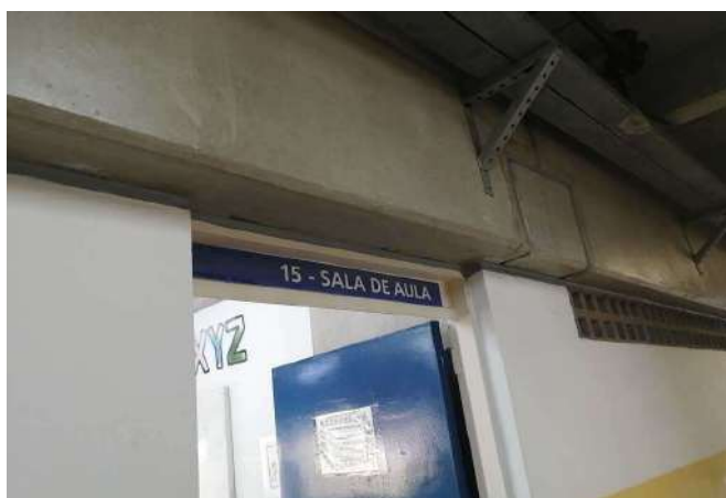
FOTO 47 Sala de Aula 05 - Identificação
