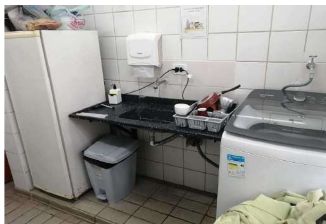
FOTO 34 Lavanderia - Revestimento e rejunte diferente do original
