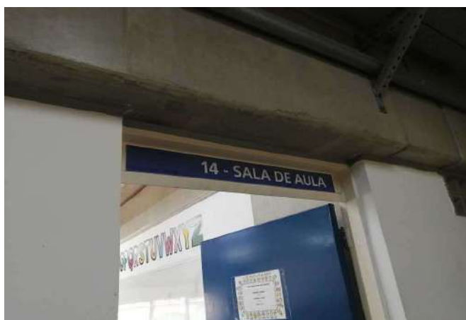
FOTO 45 Sala de Aula 04 - Identificação
