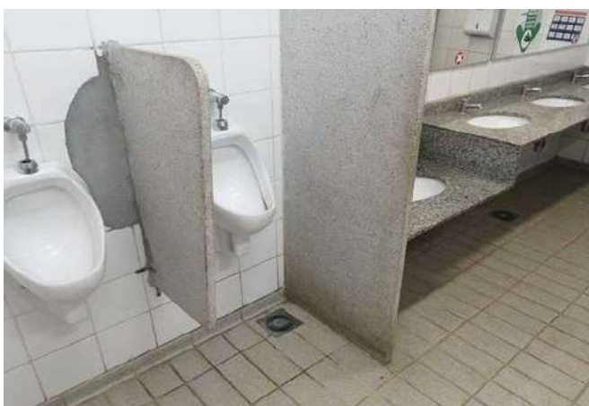
FOTO 87 Sanitário masculino aluno - Visão parcial
