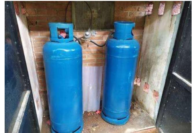
FOTO 46 Abrigo do gás, necessário revisão do registro e tubulação de gás.
