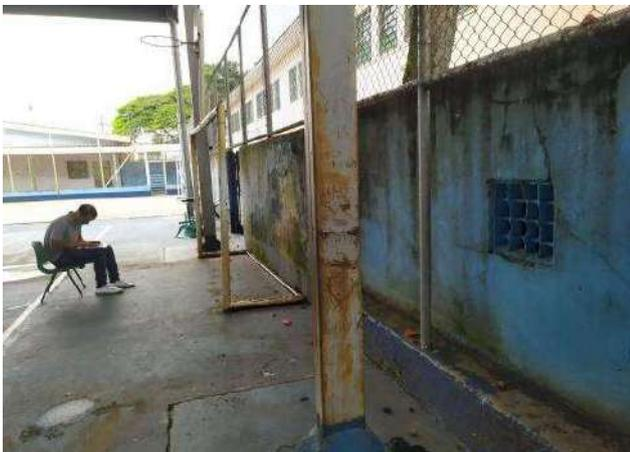
FOTO 113 Necessário revisão das estruturas metálicas da quadra de esportes coberta.
