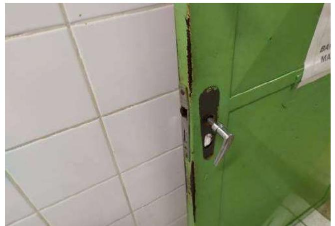
FOTO 60 Vestiário dos funcionários unissex, necessário substituição de fechadura danificada.
