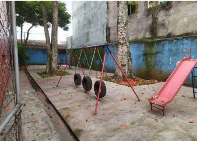
FOTO 111 Playground, necessário pintura dos muros de divisa e instalações de tampas das canaletas.
