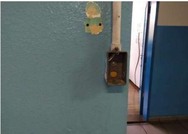
FOTO 15 Corredor da entrada da unidade escolar, necessário revisão das instalações elétricas.
