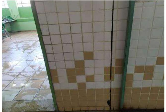
FOTO 98 Necessário, revisão das juntas de dilatação do pavimento superior.
