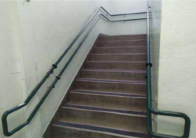
FOTO 67 Escadas para o piso superior com corrimões acessíveis, necessário pintura das paredes.
