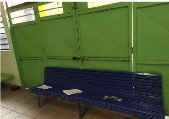
FOTO 51 Pátio coberto, necessário pintura das portas metálicas.
