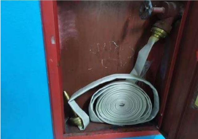
FOTO 19 Corredor da entrada, possui hidrante, está com esguicho e mangueira conectados.
