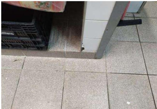
FOTO 32 Despensa da cozinha, necessário revisão dos revestimentos cerâmicos danificados.
