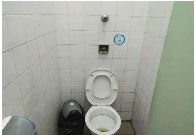
FOTO 22 Banheiro masculino dos funcionários, necessário instalação acabamento da valvula da descarga.
