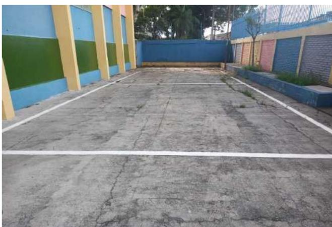
FOTO 17 Patio Descoberto - Falha nas juntas de dilatação e fissuras
