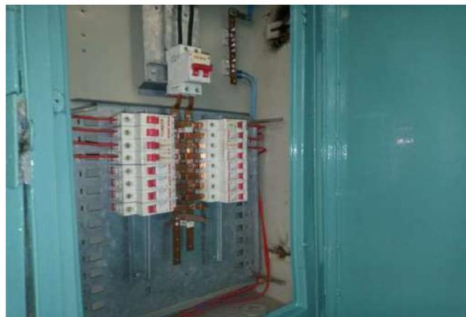
FOTO 98 QD com disjuntores DIN e sem canaleta para fiação
