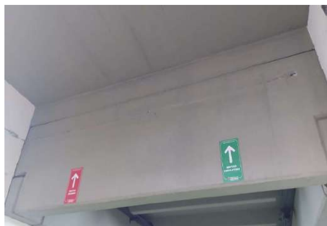
FOTO 6 Furo para retirar água parada infiltrando
