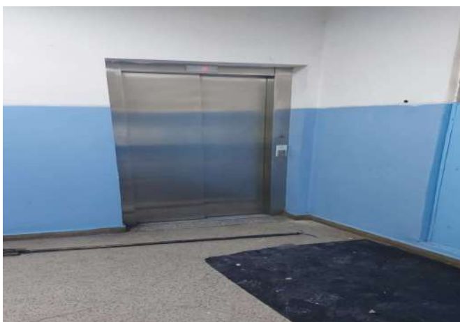
FOTO 57 A escola possui elevador para atender a acessibilidade, Todavia da manutenção
