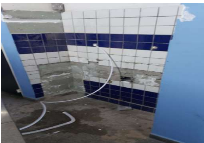
FOTO 3 Sala de artes 2º pavimento instalar pia
