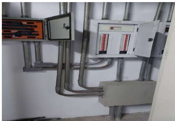
FOTO 18 Sala de artes 2º pavimento instalar pia
