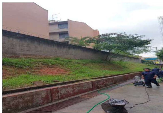
FOTO 42 Sistema pluvial em frente o pátio coleta no do condomínio externo e também da escola, todavia em
