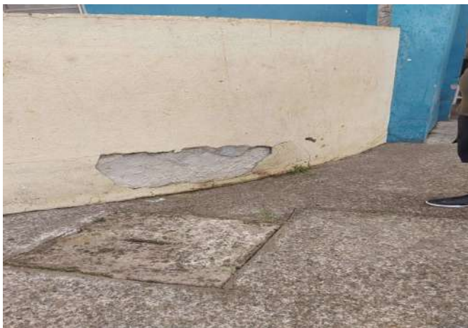
FOTO 19 Reparos na entrada e escada
