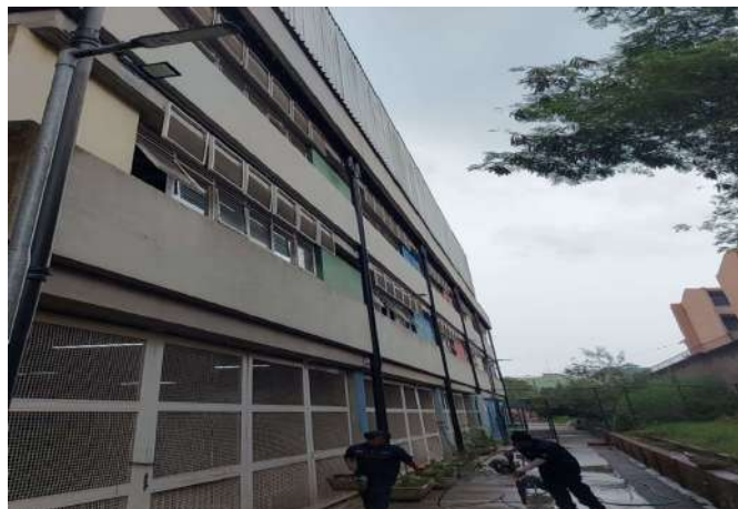
FOTO 14 Pintura na fachada geral
