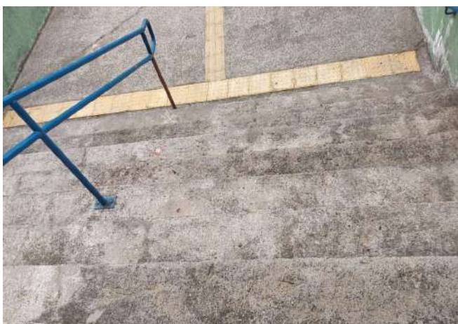
FOTO 39 Reparos na entrada e escada
