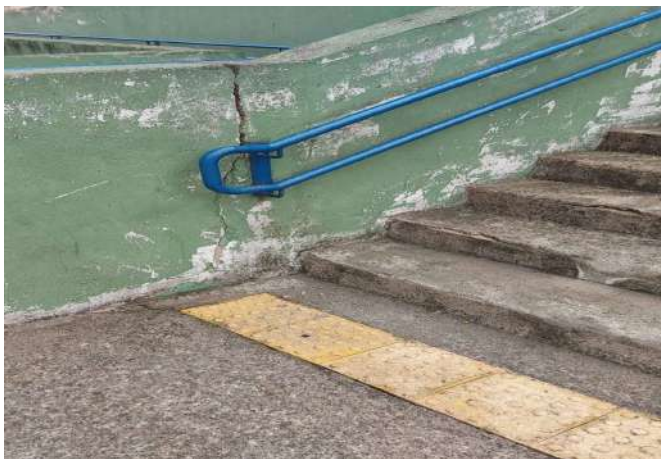
FOTO 1 Reparos na entrada e escada
