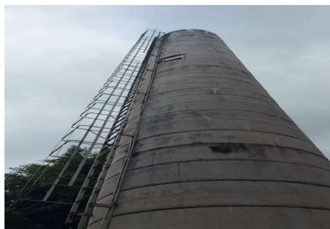
FOTO 12 Infiltração
