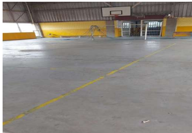
FOTO 62 Executar um piso na quadra ou pintura
