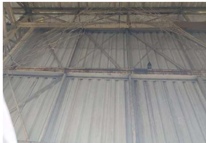
FOTO 38 Fixação dos rotores
