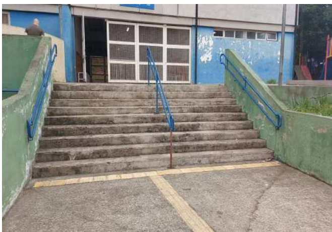
FOTO 59 Reparos na entrada e escada
