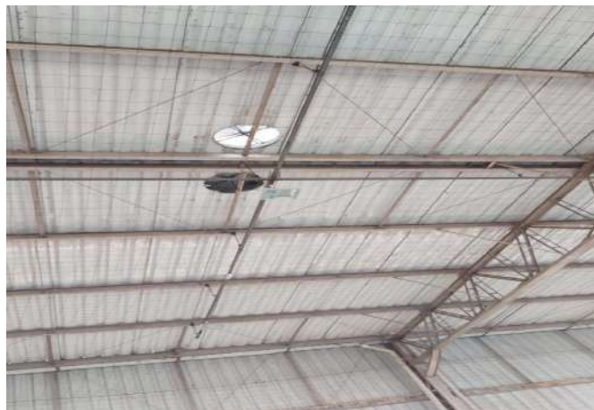
FOTO 56 Fixação dos rotores
