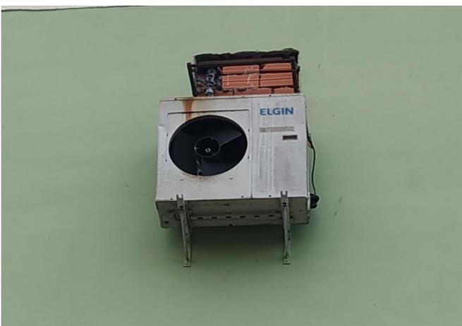
FOTO 95 Unidade condensadora, necessidade de revisão.
