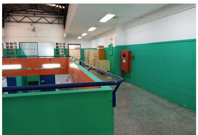
FOTO 18 Pavimento superior, detalhamento construtivo (parapeito) não oferece segurança.
