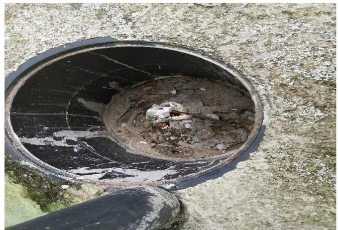
FOTO 6 Caixa de inspeção, barra chata conectada a haste de aterramento.
