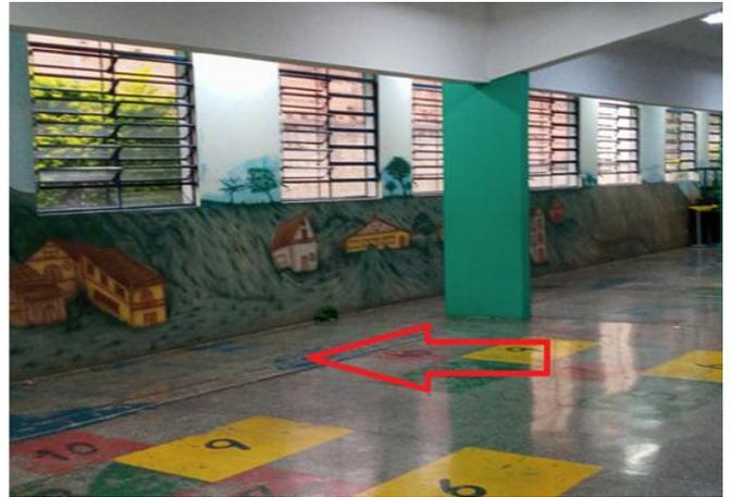
FOTO 38 Pátio com desnível devido a recalque
