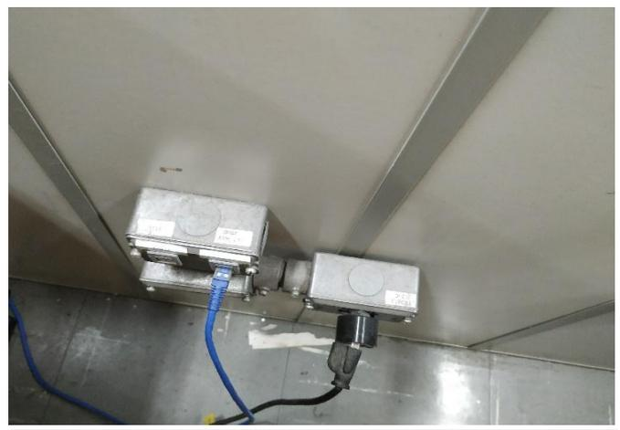
FOTO 72 Caixas condutete com tomada simples e conexão para cabo de rede.
