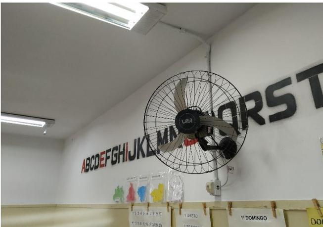
FOTO 99 Ventilador de parede, com adaptação na instalação elétrica, sala de aula.
