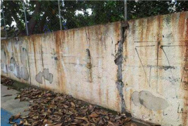
FOTO 55 Muro divisa deteriorado
