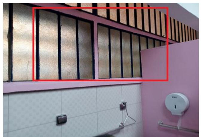
FOTO 30 Banheiro PNE com improvisos de alvenaria
