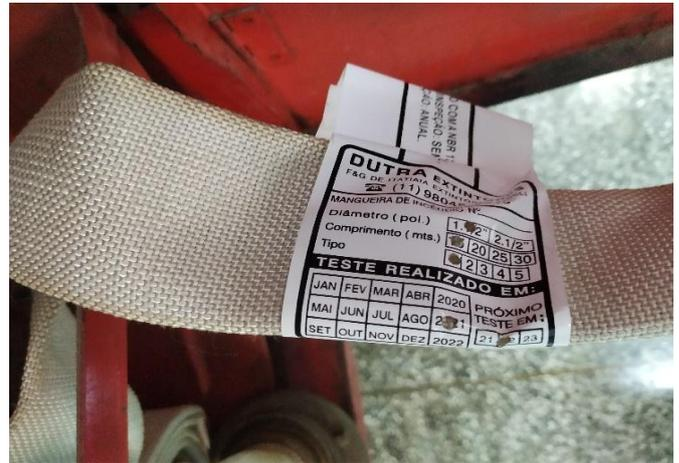
FOTO 26 Identificação do teste hidrostático da mangueira.
