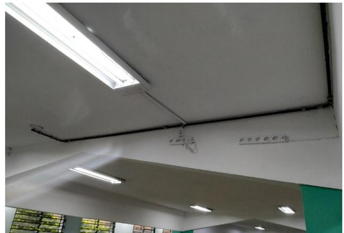
FOTO 88 Régua de tomadas, instaladas com adaptações, palco do pátio.
