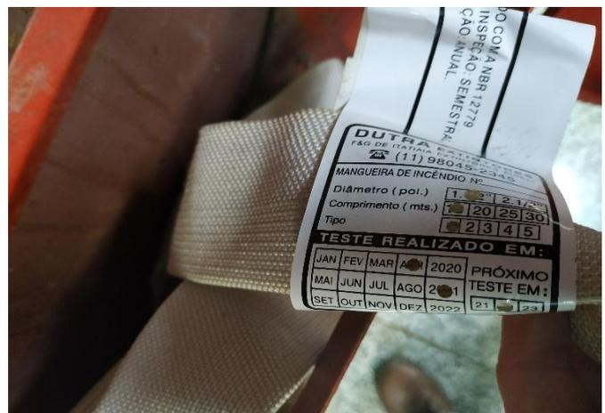
FOTO 30 Identificação do teste hidrostático da mangueira.
