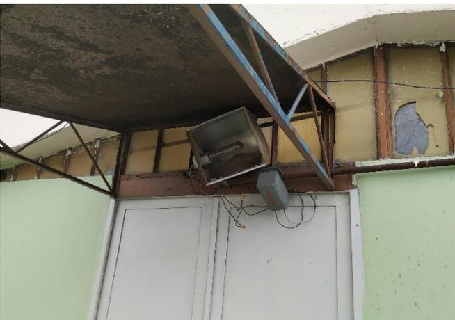
FOTO 65 Refletor danificado, com lâmpada de vapor de sódio. Cabos elétricos expostos.
