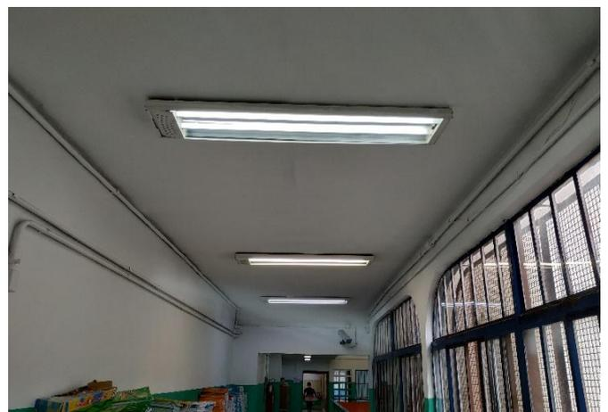
FOTO 36 Iluminação sobrepor com lâmpada tubular de LED, corredor.
