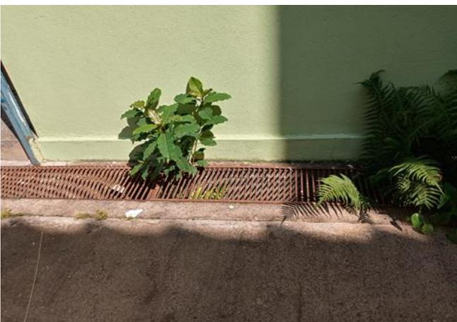
FOTO 53 Grelha hidráulica, pé de jaca na parte interna
