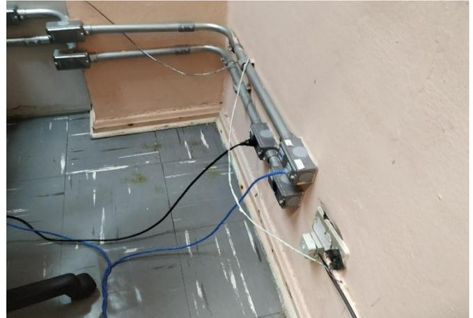
FOTO 74 Caixas condutele com tomada simples e conexão para cabo de rede.
