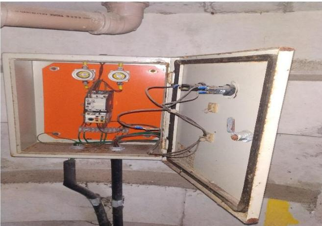
FOTO 21 Quadro elétrico da bomba de incêndio, revisar os componentes e o funcionamento.
