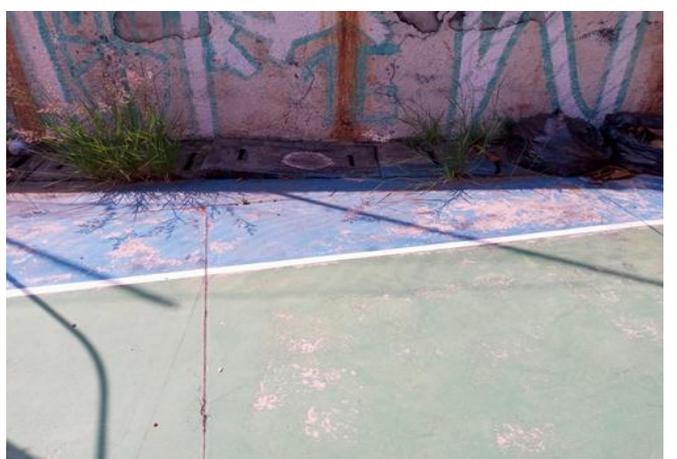
FOTO 48 Calha hidráulica desencaixada/quebrada
