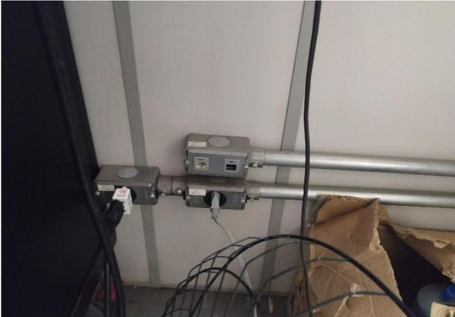
FOTO 73 Caixas condutele com tomada simples e conexão para cabo de rede.
