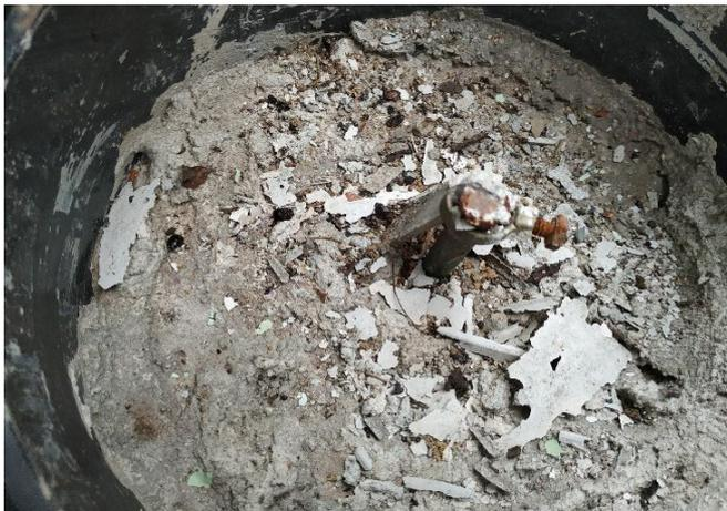
FOTO 9 Caixa de inspeção, barra chata conectada a haste de aterramento.
