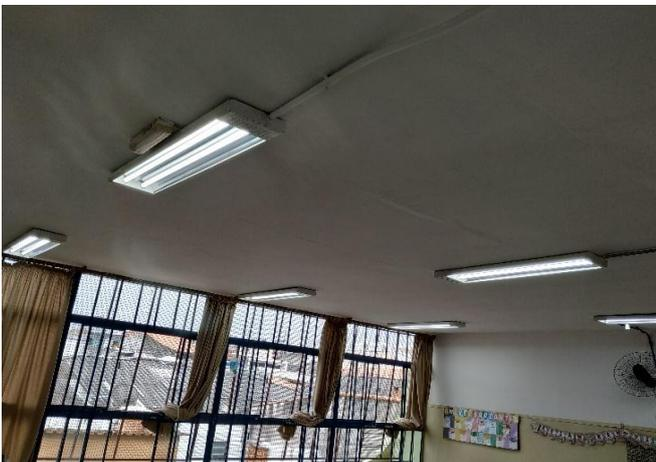
FOTO 35 Iluminação sobrepor com lâmpadas tubular de LED, sala de aula.
