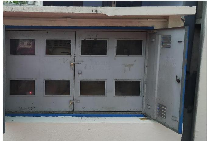
FOTO 4 Caixa de medição de energia.
