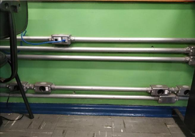
FOTO 31 Sistema de condutores para tomadas, passagem e cabeamento de rede.
