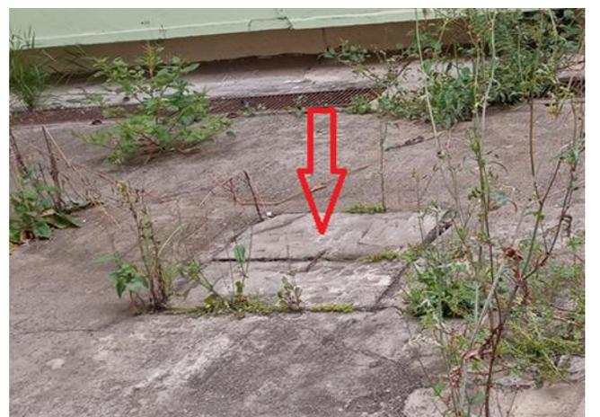
FOTO 60 Caixa de passagem com a tampa rachada
