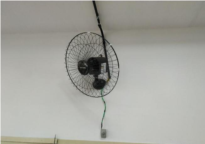
FOTO 97 Ventilador de parede, com adaptação na instalação elétrica, cabos expostos. Sala de aula.
