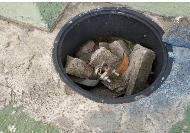
FOTO 17 Caixa de inspeção sem tampa.
