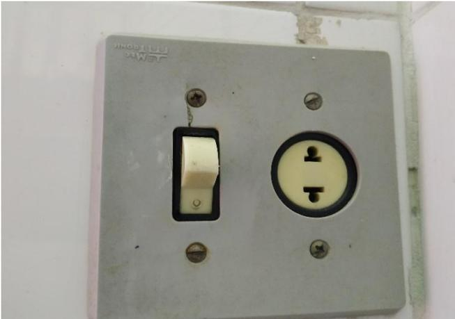
FOTO 55 Interruptor e tomada padrão americano antigo, banheiro. Substituir o conjunto.
