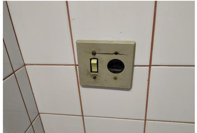
FOTO 56 Interruptor e tomada, banheiro funcionários. Substituir o conjunto.
