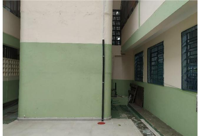
FOTO 2 Descida da barra chata e tubo de proteção.
