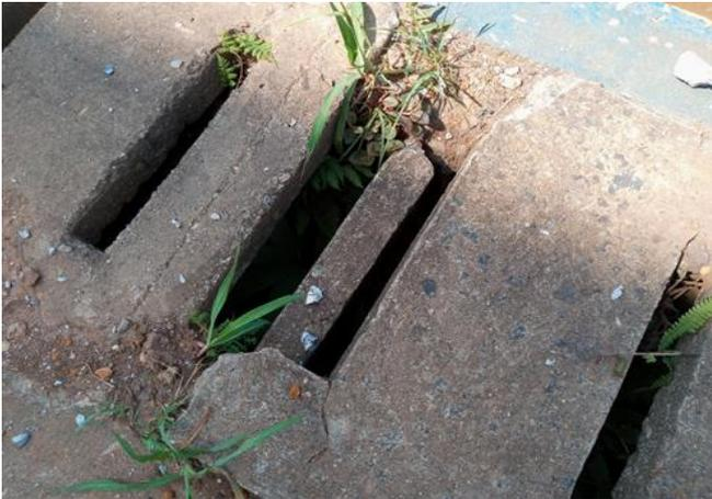
FOTO 55 Grelha hidráulica de pré moldado danificada
