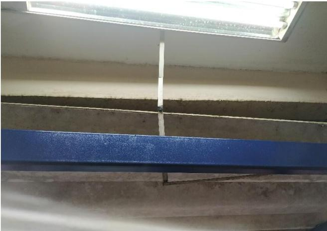
FOTO 49 Luminária instalada com improviso, corredor de acesso a unidade. Realizar instalação de condutele.
