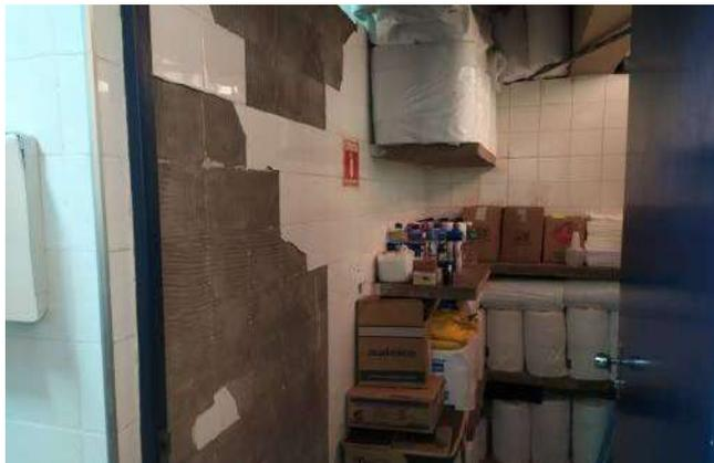
FOTO 21 Depósito de limpeza com necessidade de recomposição de ladrilhos.
