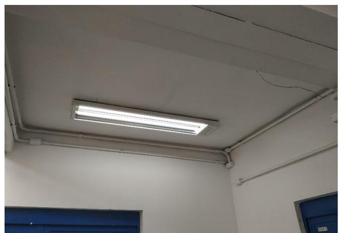
FOTO 30 Sistema de condutores para iluminação, tomadas e cabimento de rede.
