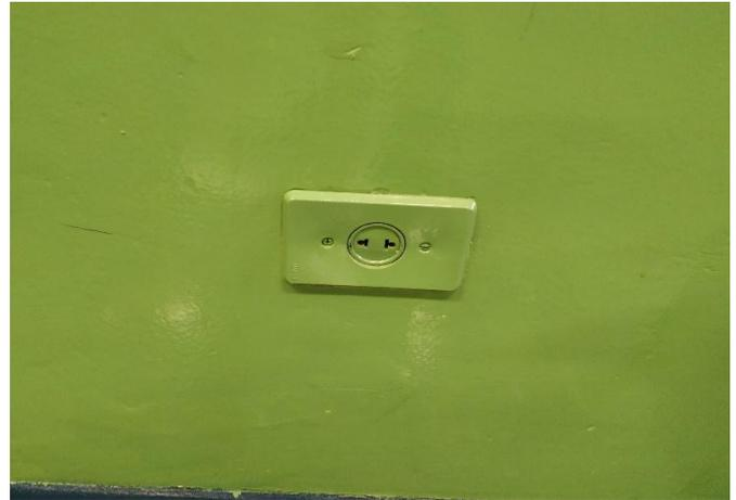
FOTO 68 Tomada simples, padrão americano antigo, sala de informática. Substituir por padrão brasileiro.
