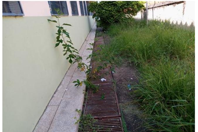
FOTO 52 Grelha hidráulica, pé de amora crescendo na parte interna
