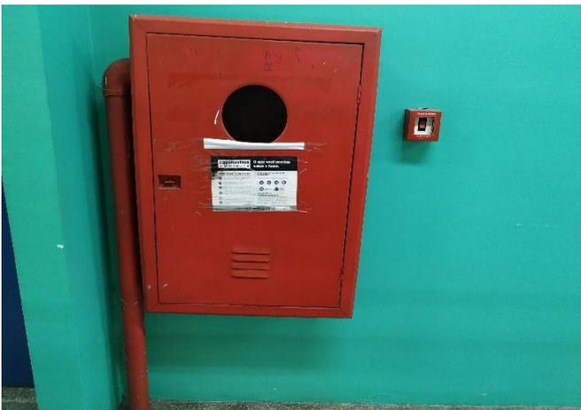
FOTO 27 Abrigo do hidrante, pavimento superior.
