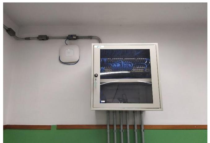
FOTO 90 Rack dos switch, sala de informática.
