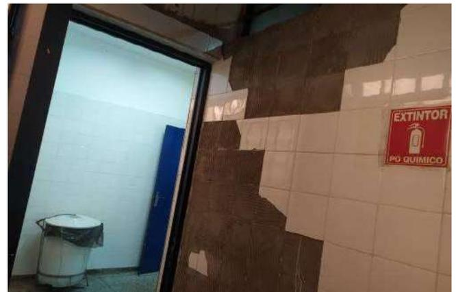
FOTO 22 Depósito de limpeza com necessidade de recomposição de ladrilhos.
