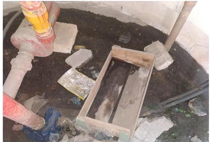
FOTO 22 Interior da casa de bomba, sujeidade e com água no chão.
