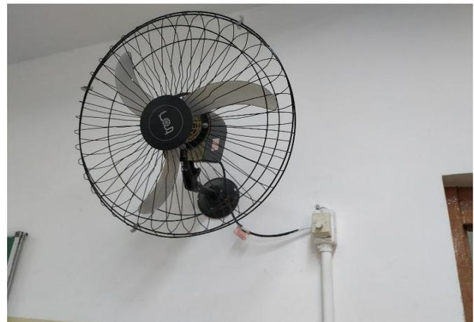
FOTO 100 Ventilador de parede, com adaptação na instalação elétrica, sala de aula.
