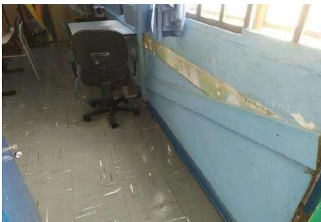
FOTO 45 Almoarifado pav. Superior.- pintura dos caixilhos e paredes com reparo nos bate carteira.
