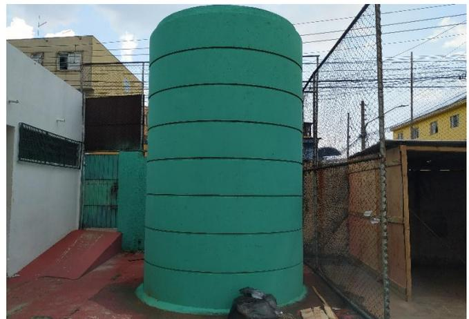
FOTO 18 Reservatório de incêndio, capacidade de 12 m³.
