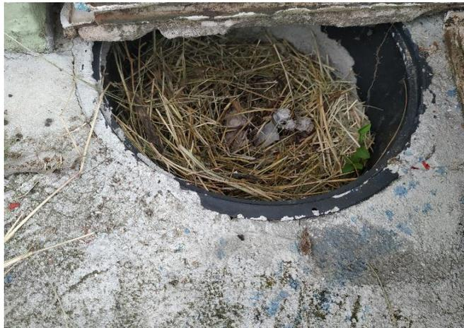
FOTO 15 Caixa de inspeção sem tampa.
