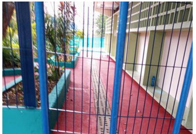
FOTO 58 Grelhas de pré moldados instaladas recentemente
