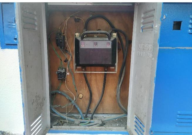
FOTO 5 Dispositivo de proteção. Condutor fase, neutro e terra.
