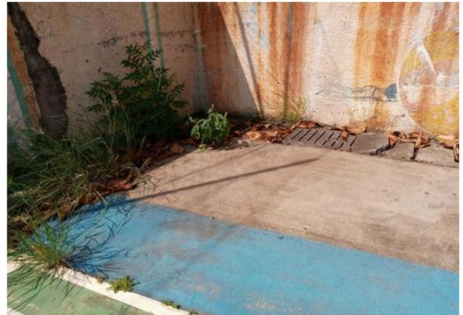
FOTO 56 Grelha hidráulica necessita de manutenção
