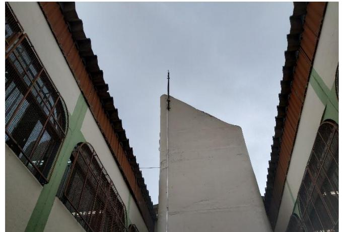
FOTO 4 Captor e descida da barra chata, caixa d'água esquerda.
