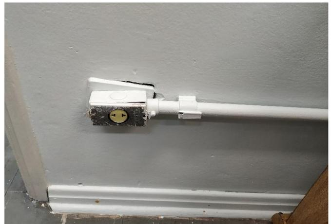
FOTO 76 Tomada simples padrão americano antigo. Substituir por padrão brasileiro.
