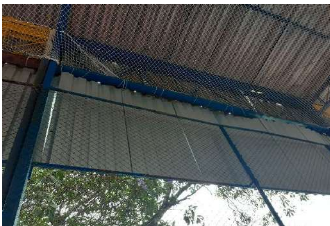
FOTO 71 Quadra coberta - Cobertura com abertura
