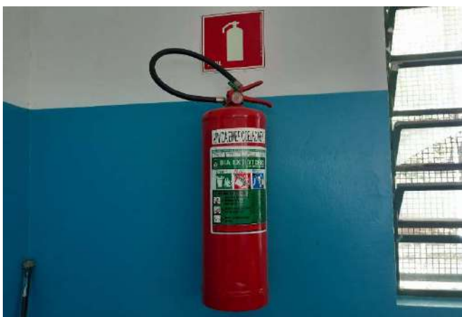
FOTO 105 Extintor - Em conformidade
