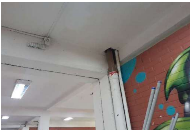
FOTO 103 Corredor - Abertura teto
