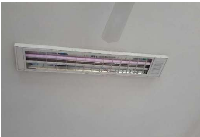
FOTO 47 Laboratório informática - Lâmpadas queimadas
