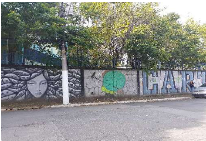
FOTO 1 Fachada/Entrada - Visão geral
