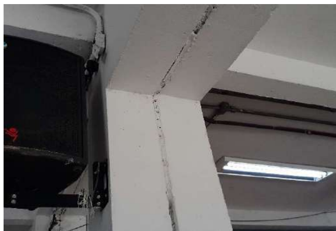
FOTO 60 Pátio coberto - Junta de dilatação
