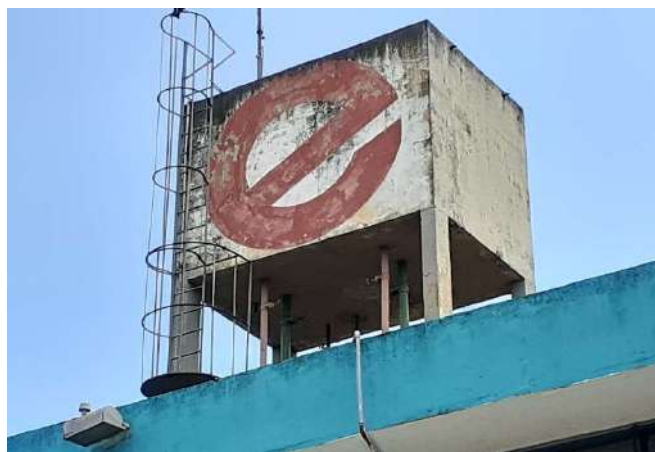
FOTO 30 Reservatório - Visão geral
