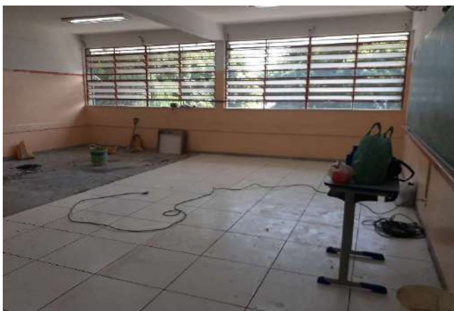
FOTO 107 Sala 6 - Visão geral em reforma
