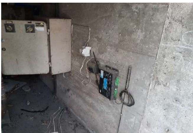
FOTO 15 Casa de Máquina do Reservatório - Improviso
