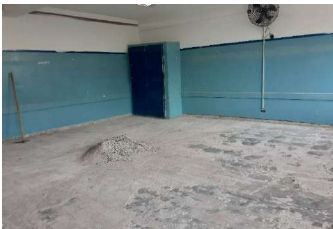
FOTO 107 Sala 8 - Visão geral (em reforma)
