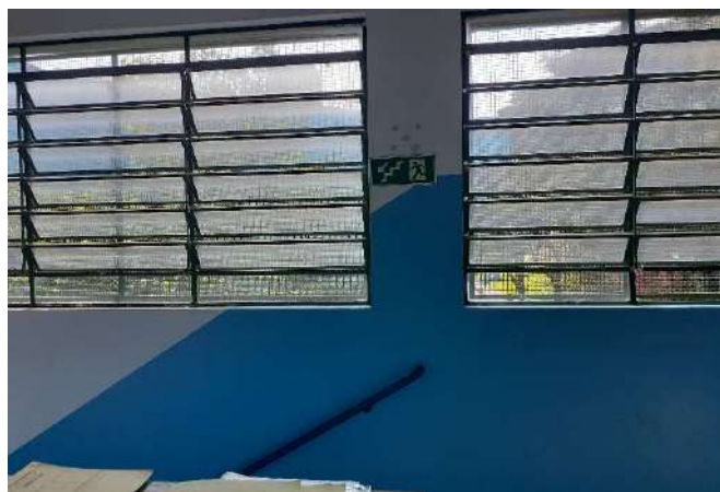
FOTO 108 Sinalização rota de fuga - Em conformidade
