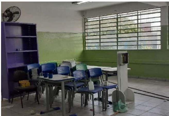
FOTO 103 Sala 12 a 14 - Visão geral
