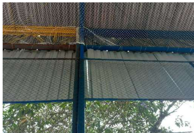
FOTO 72 Quadra coberta - Cobertura com abertura
