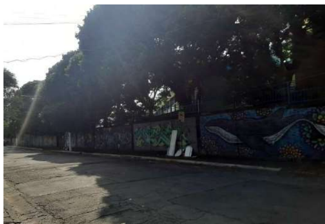
FOTO 4 Fachada - Muro de fecho
