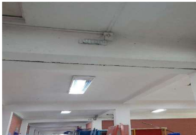
FOTO 104 Corredor - Junta de dilatação
