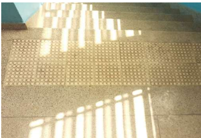
FOTO 107 Piso tatil - Visão parcial
