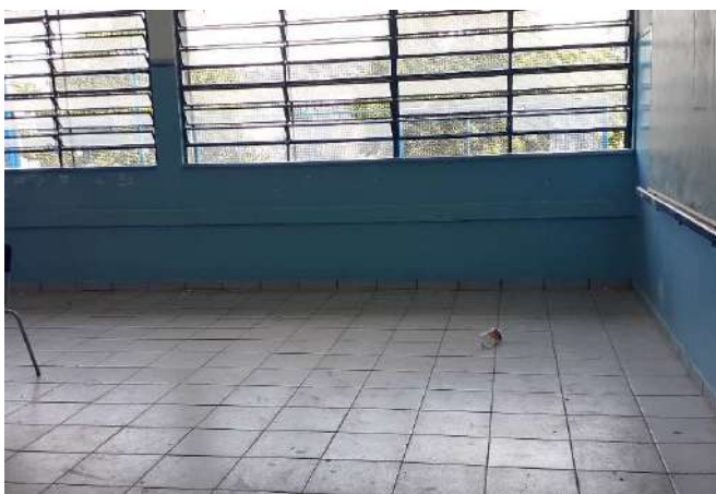
FOTO 105 Sala 12 a 14 - Visão geral
