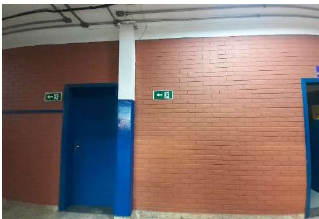
FOTO 107 Sinalização rota de fuga - Em conformidade
