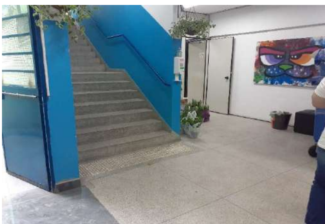
FOTO 107 Escadas - Sem anti deslizante
