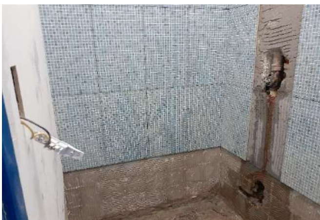
FOTO 105 Sanit. Func. Masc. - Em reforma
