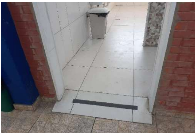
FOTO 103 Sanit. aluno Fem. - Entrada acessível
