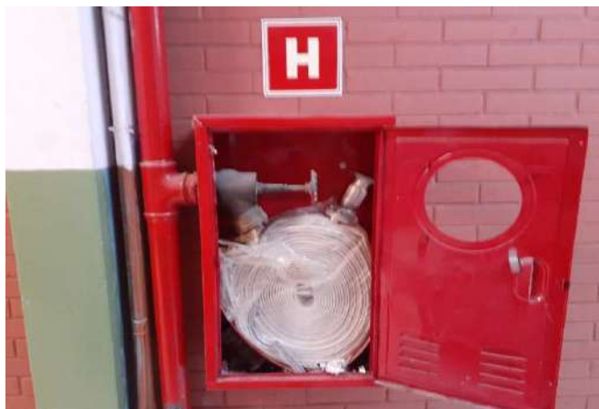
FOTO 106 Hidrante - Em conformidade
