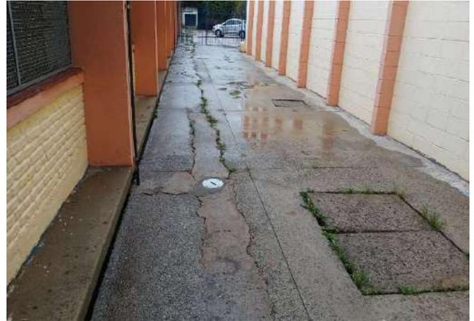
FOTO 86 PASSEIO INTERNO PISO CIMENTADO COM REMENDOS PARA PASSAGEM DE AVCB/CORDOALHA
