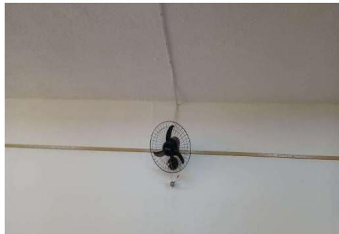
FOTO 80 SALA DE AULA 04 IMPROVISO NA REDE ELÉTRICA DE ILUMINAÇÃO E VENTILAÇÃO
