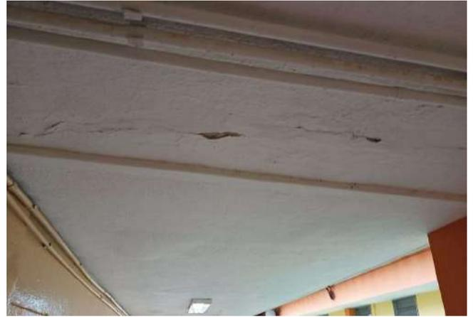
FOTO 44 CORREDOR INTERNO PRESENÇA DE UMIDADE E PARTES SOLTAS NO REVESTIMENTO DO TETO
