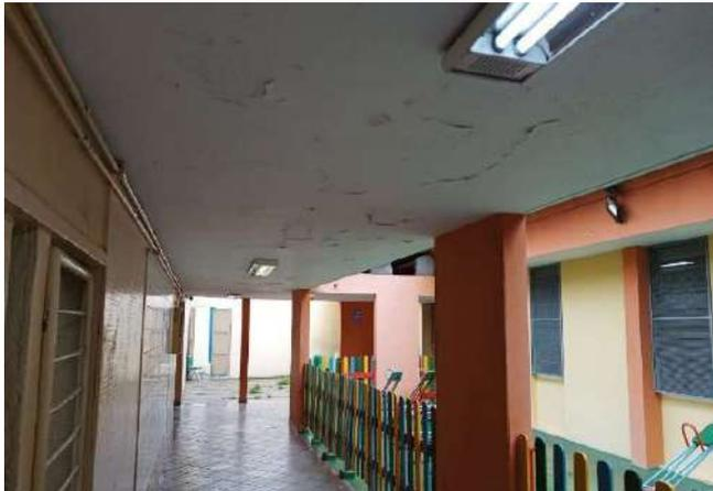
FOTO 45 CORREDOR INTERNO REVESTIMENTO DE PINTURA COM PARTES SOLTAS E PRESENÇA DE UMIDADE
