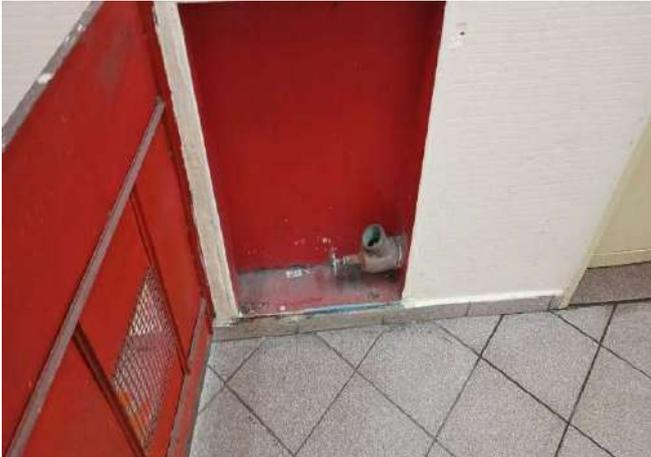
FOTO 49 HIDRANTE SEM COMPONENTES E IMPROVISO
