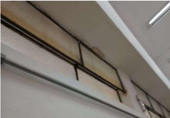
FOTO 67 SALA DE AULA 03 UMIDADE NO TETO NA JUNÇÃO COM O CAIXILHO
