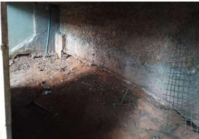
FOTO 201 ÁREA EXTERNA RECALQUE DE SOLO
