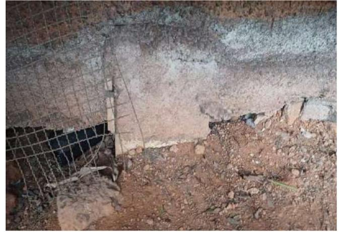
FOTO 200 ÁREA EXTERNA RECALQUE DE SOLO
