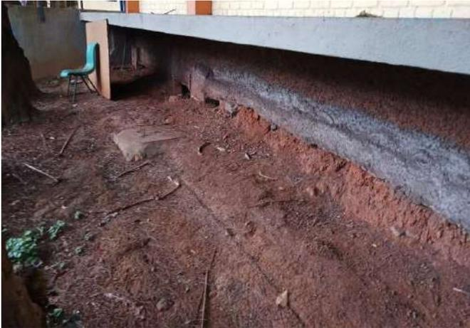
FOTO 199 ÁREA EXTERNA RECALQUE DE SOLO
