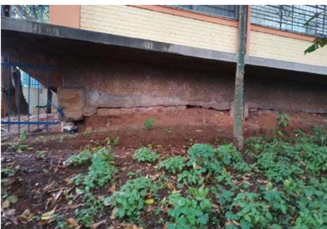
FOTO 203 ÁREA EXTERNA RECALQUE DE SOLO
