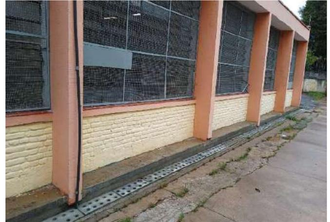
FOTO 116 ÁREA EXTERNA PISO CIMENTADO REMENDADO PARA PASSAGEM DE CORDOALHA
