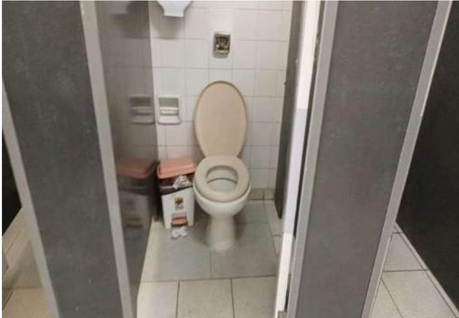
FOTO 169 BANHEIRO FEMININO ALUNOS SEM ACABAMENTO DE VÁLVULA DE DESCARGA
