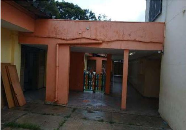
FOTO 85 PÁTIO EXTERNO UMIDADE NO PLATIBANDA
