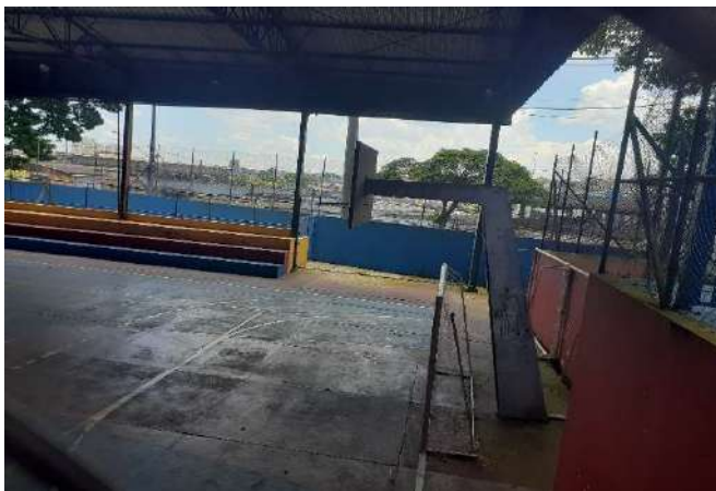
FOTO 61 Quadra coberta - Visão geral, sem acesso
