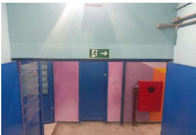
FOTO 117 Rota de fuga - Visão geral
