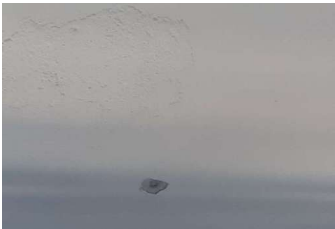
FOTO 109 Sala 7 - Descascamento
