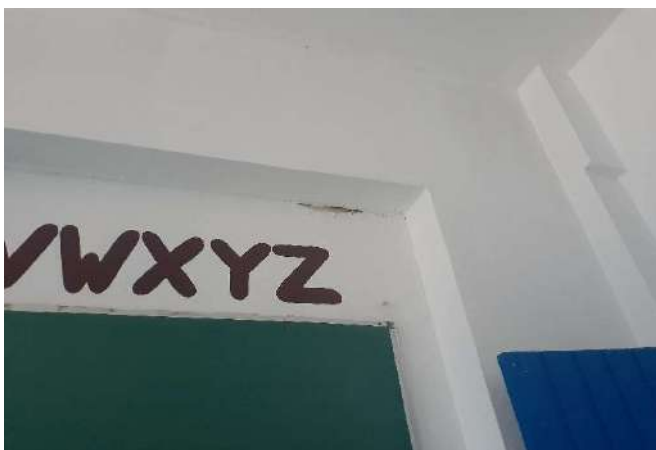
FOTO 119 Sala 11 - Trinca
