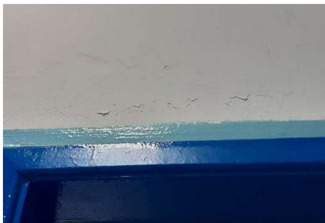
FOTO 89 Sala 2 - Descascamento
