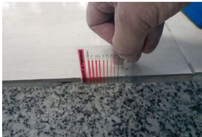
FOTO 116 Sala 9 - Piso colocado 9mm acima do nível da soleira
