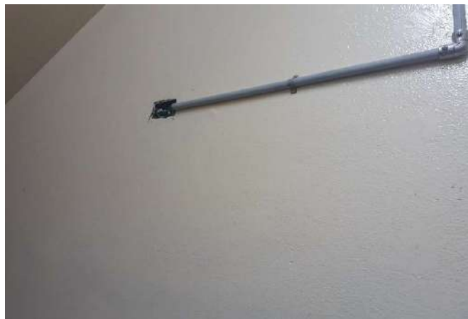
FOTO 26 Almojarifado - Abertura para passagem de cabos
