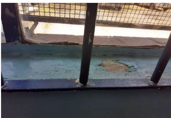
FOTO 117 Sala 13 - Descascamento
