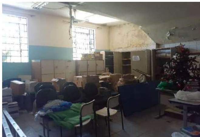
FOTO 30 Depósito - Visão geral
