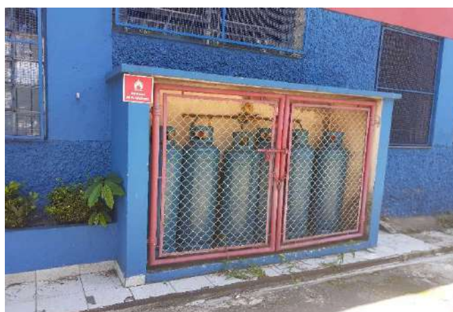
FOTO 118 Gás - Em conformidade
