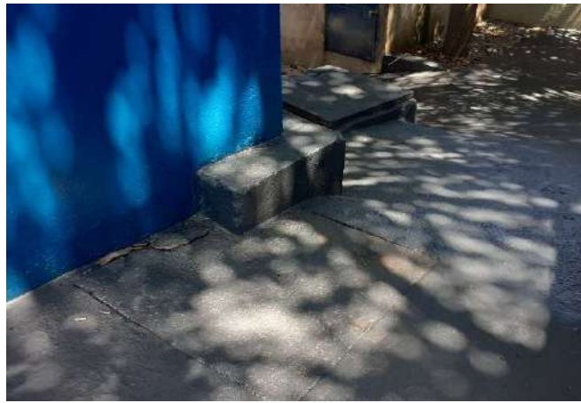
FOTO 58 Pátio descoberto - Juntas de dilatação
