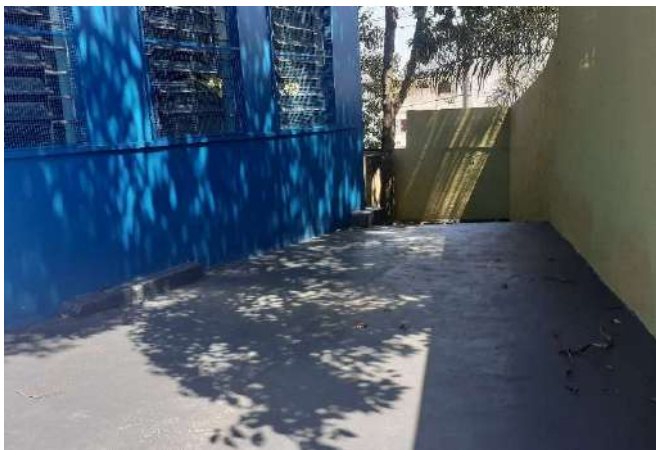
FOTO 55 Pátio descoberto - Visão geral
