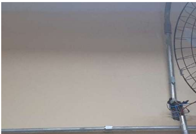
FOTO 73 Sala coordenação - Improviso
