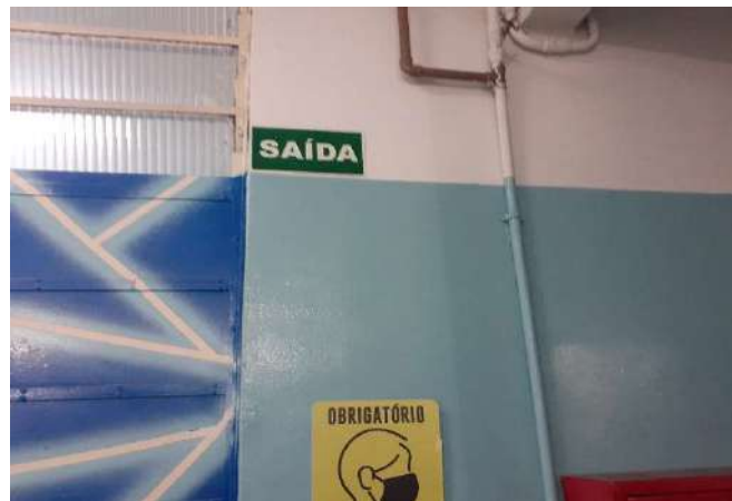
FOTO 116 Rota de fuga - Visão geral
