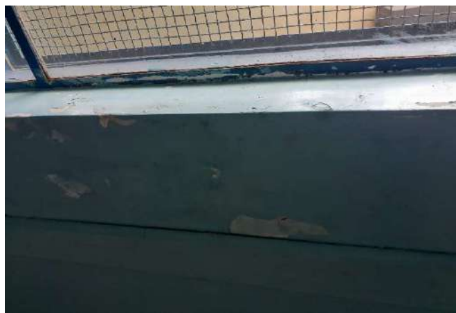
FOTO 120 Sala 15 - Descascamento
