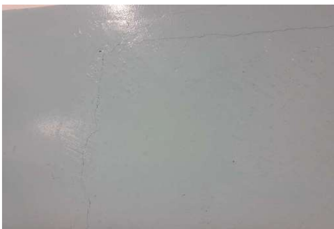
FOTO 81 Sala dos professores - Trinca
