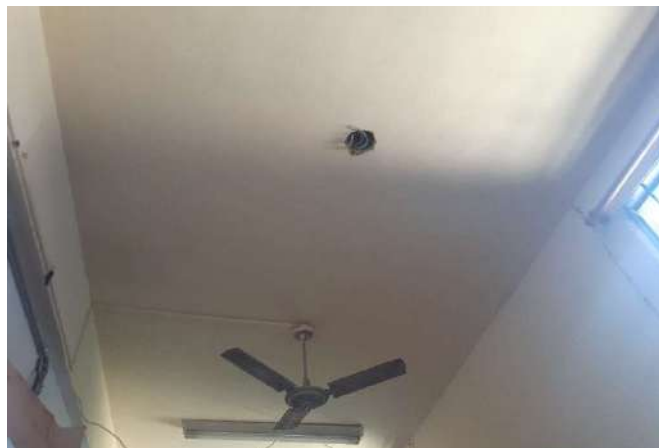
FOTO 38 Depósito - Abertura de passagem de cabos
