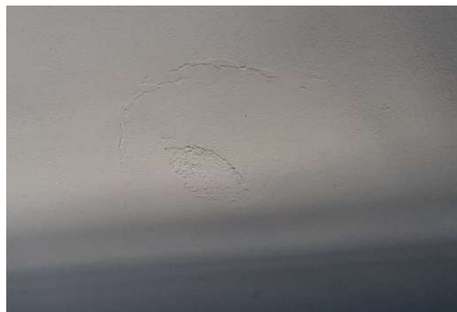
FOTO 90 Sala 2 - Trinca
