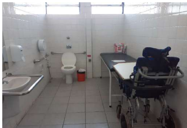
FOTO 118 Sanit. para Deficiente Masc. - Visão geral
