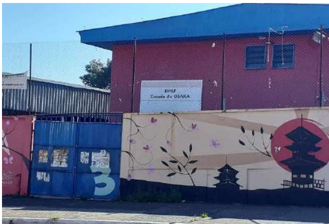
FOTO 1 Fachada/ Entrada - Visão geral
