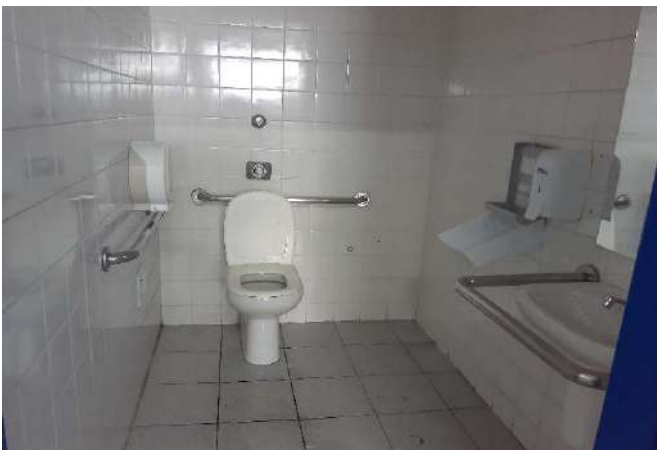
FOTO 120 Sanit. para Deficiente Unissex - Visão geral
