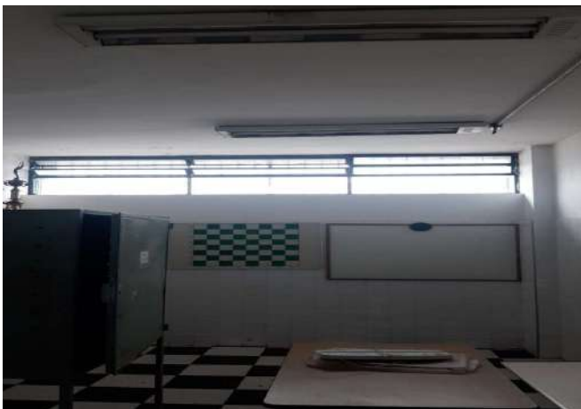
FOTO 13 Substituição de janelas da sala de xadrez
