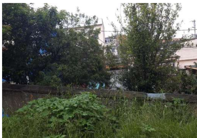
FOTO 30 Aumento do muro da quadra coberta
