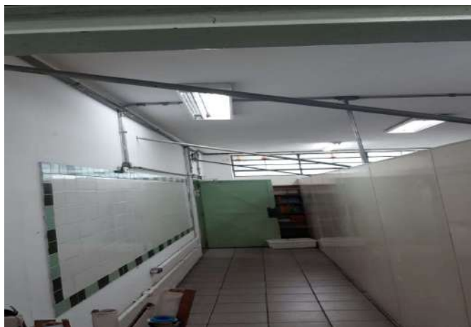
FOTO 73 Reforma da divisórias da sala dos professores
