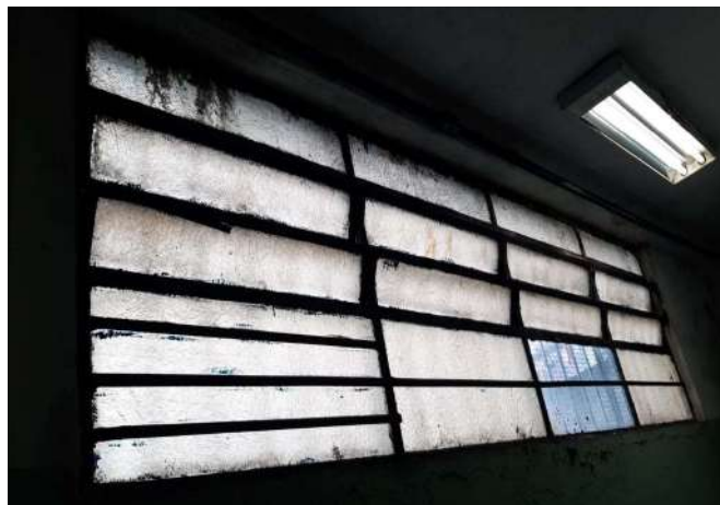
FOTO 14 Substituição de janelas do corredor do arquivo morto
