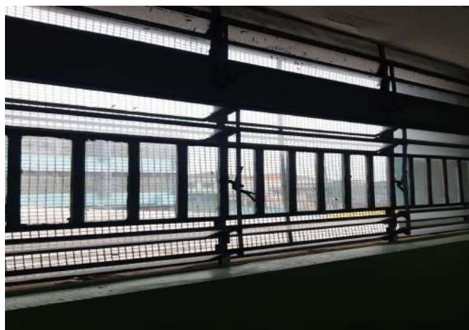
FOTO 18 Substituição de janelas do corredor da sala de aula 1
