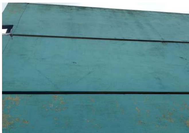
FOTO 46 Retirada do ladrilhos e reboca por toda extensão da escola
