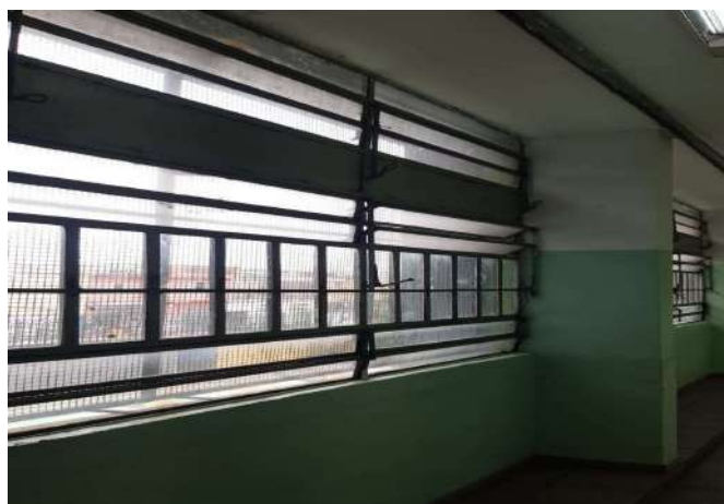
FOTO 40 Substituição de janelas do corredor de acesso a sala de aula 4
