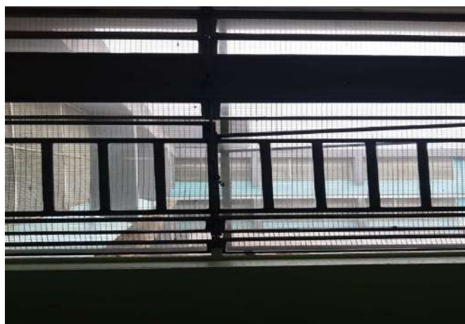
FOTO 28 Substituição de janelas e grades do corredor de acesso a sala de aula 5
