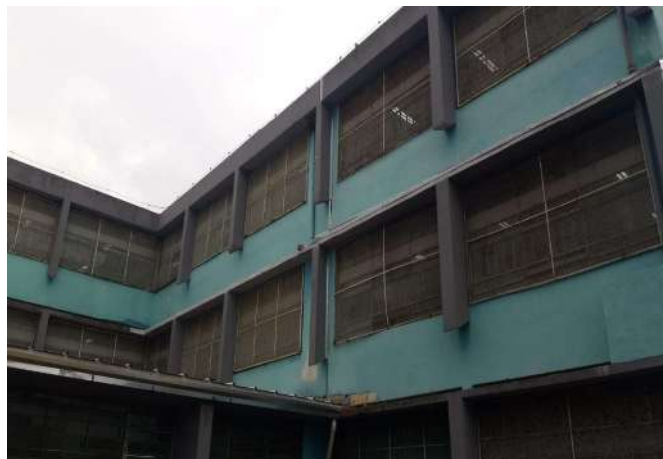
FOTO 26 Substituição de janelas de todas 16 salas de aula
