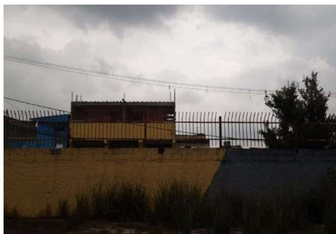
FOTO 10 Substituição das grades do muro do pátio descoberto fundo
