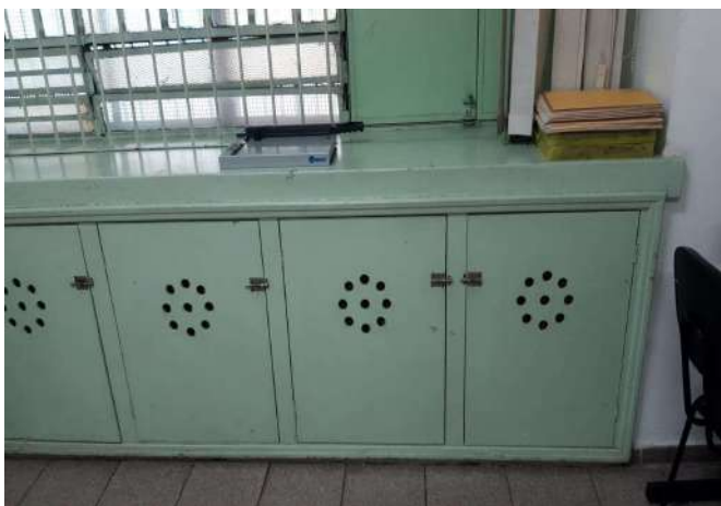
FOTO 47 Substituição dos armários embutidos
