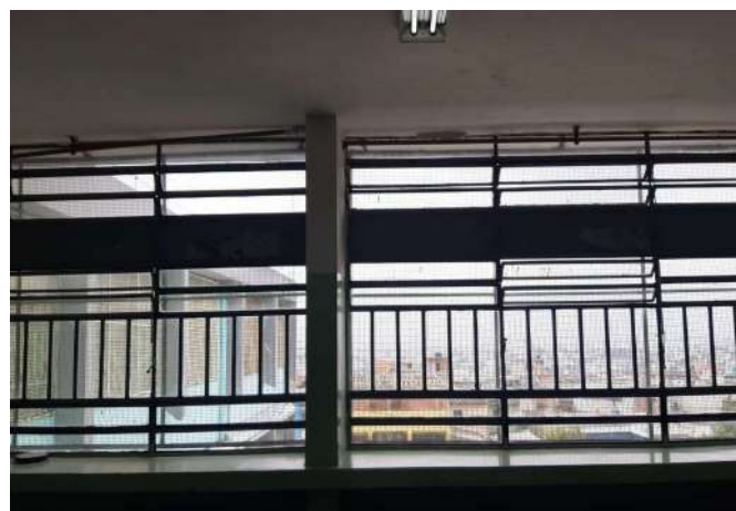
FOTO 4 Substituição de janelas de todas 16 salas de aula
