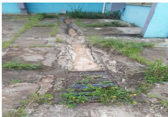
FOTO 12 Substituição da grade de ferro por grade de cimento e melhoramento do sistema de drenagem
