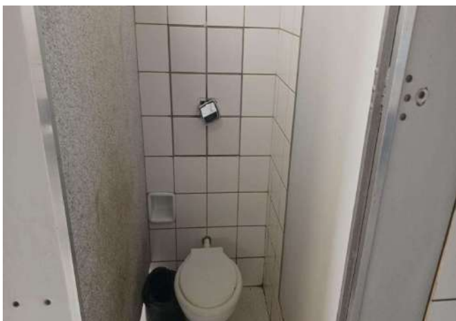
FOTO 73 BANHEIRO MASC ALUNO / VASO.
