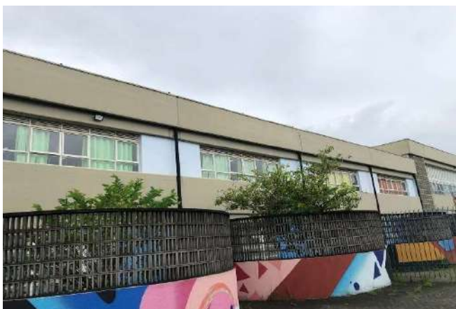
FOTO 263 SPDA DA FACHADA LATERAL DIREITA
