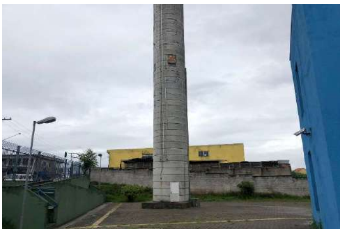
FOTO 267 CAIXA D'ÁGUA E CASA DE MÁQUINA
