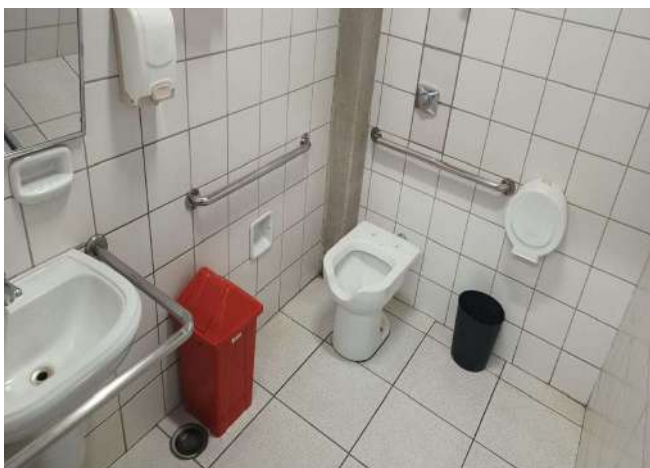
FOTO 209 BANHEIRO UNISSEX ALUNO / PISO E PAREDE.
