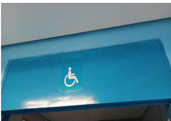
FOTO 57 BANHEIRO UNISSEX ALUNO / DEFICIENTE.
