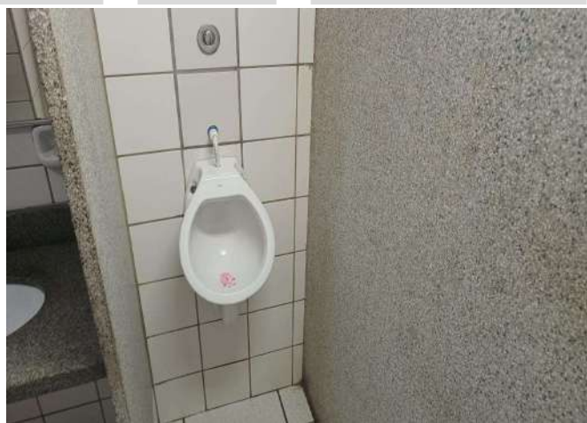
FOTO 242 BANHEIRO MASC FUNCIONÁRIO / MICTÓRIO
