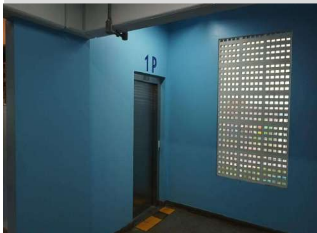
FOTO 228 CORREDOR DOS BANHEIROS.
