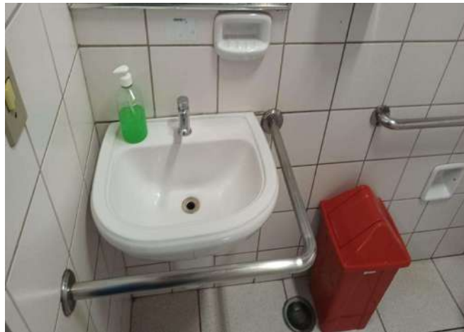
FOTO 210 BANHEIRO UNISSEX ALUNO / LAVATÓRIO.
