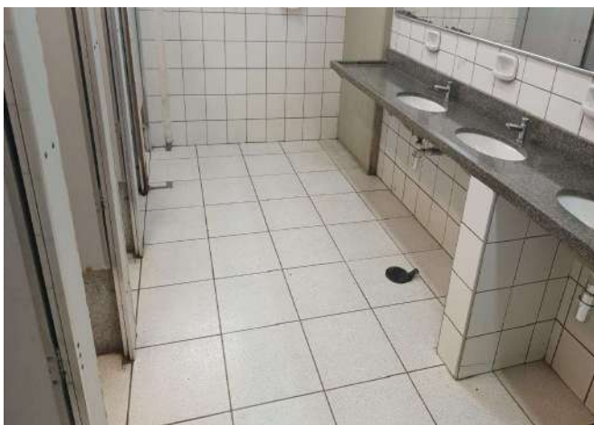
FOTO 67 BANHEIRO FEM ALUNO / PISO.
