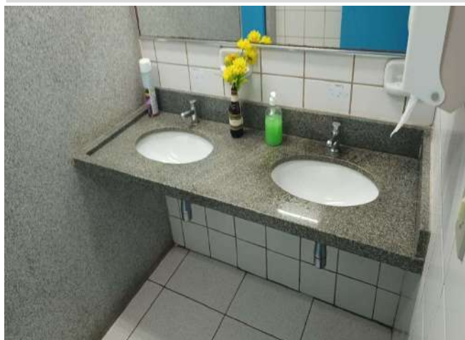
FOTO 246 BANHEIRO FEM FUNCIONÁRIO / PISO, BANCADA E LAVATÓRIO
