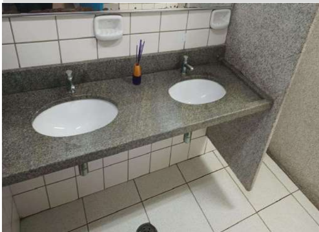
FOTO 241 BANHEIRO MASC FUNCIONÁRIO / PISO, BANCADA E LAVATÓRIO
