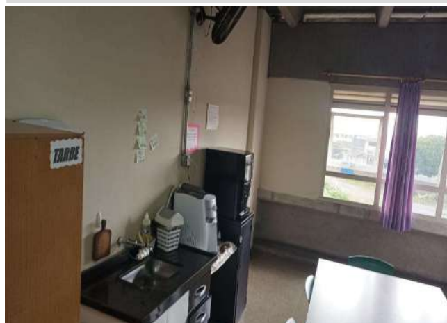
FOTO 204 COPA DA SALA DE COORDENAÇÃO PEDAGÓGICA / ADAPTAÇÕES DE VENTILADORES E TOMADAS
