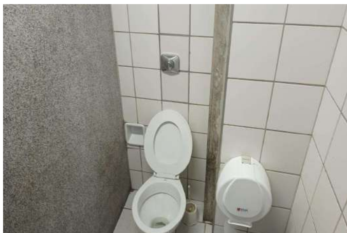
FOTO 243 BANHEIRO MASC FUNCIONÁRIO / VASO SANITÁRIO
