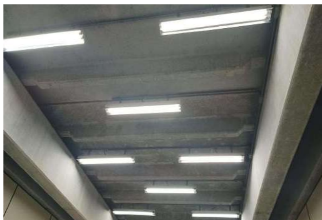
FOTO 137 CORREDOR P/ ACESSAR AS SALAS DE AULA / TETO
