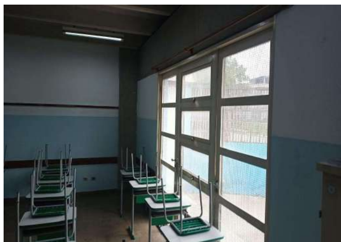
FOTO 40 SALA 5 DE ALUNO COM PAREDE E POTA DE VIDRO.
