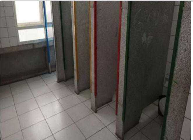
FOTO 216 BANHEIRO FEM ALUNO / PISO E DIVISÃO DE VASOS SANITÁRIOS
