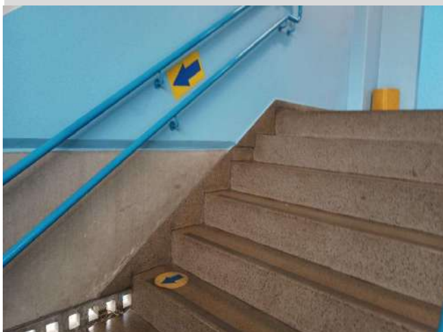
FOTO 233 ESCADA E CORRIMÃO
