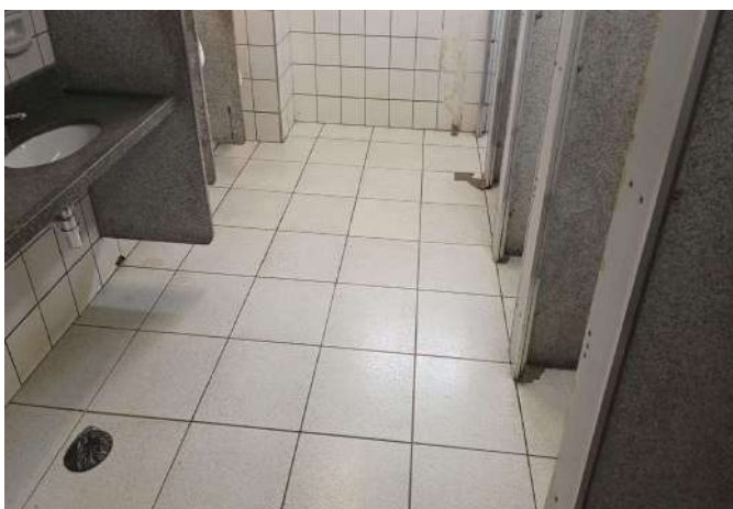
FOTO 71 BANHEIRO MASC ALUNO.
