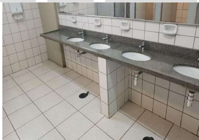
FOTO 68 BANHEIRO FEM ALUNO / PISO E BANCADA DO LAVATÓRIO.
