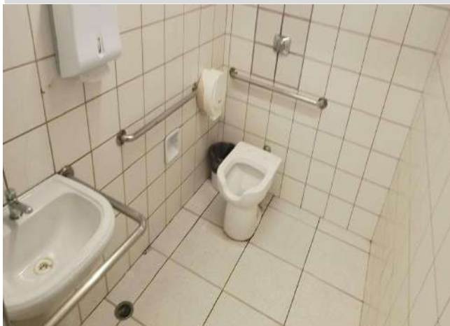
FOTO 235 BANHEIRO UNISSEX ALUNO / PISO E PAREDES
