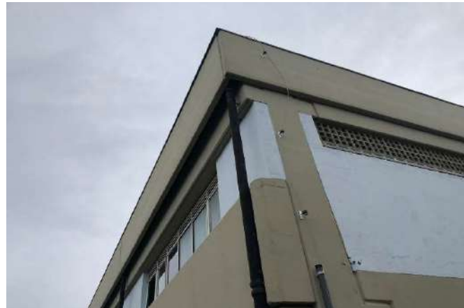
FOTO 272 SPDA DA FACHADA, LATERAL ESQUERDA DA ESCOLA.
