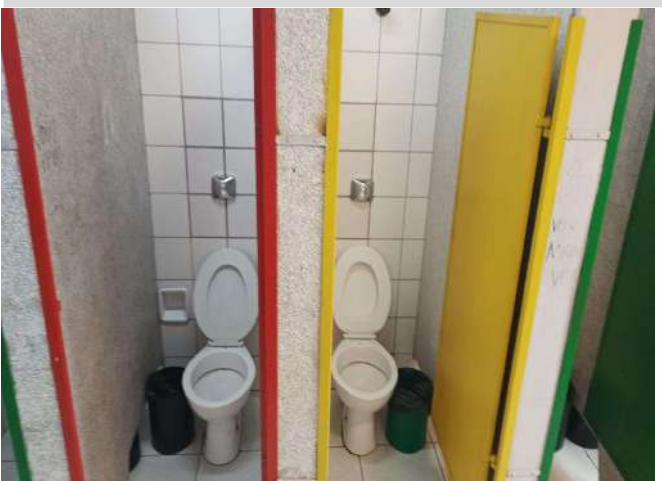
FOTO 222 BANHEIRO MASC ALUNO / VASO
