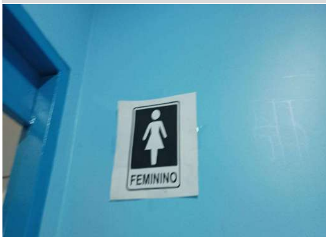
FOTO 214 BANHEIRO FEM ALUNO / PORTA
