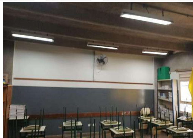
FOTO 176 SALA DE MATEMÁTICA / PAREDE E ADAPTAÇÕES DE TOMADAS E VENTILADORES
