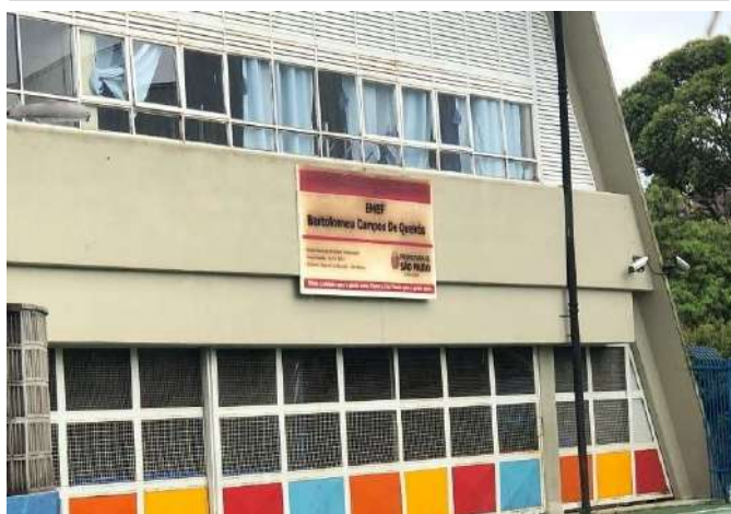
FOTO 255 FACHADA LATERAL DIREITA.
