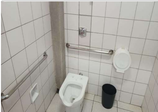
FOTO 211 BANHEIRO UNISSEX ALUNO / PISO
