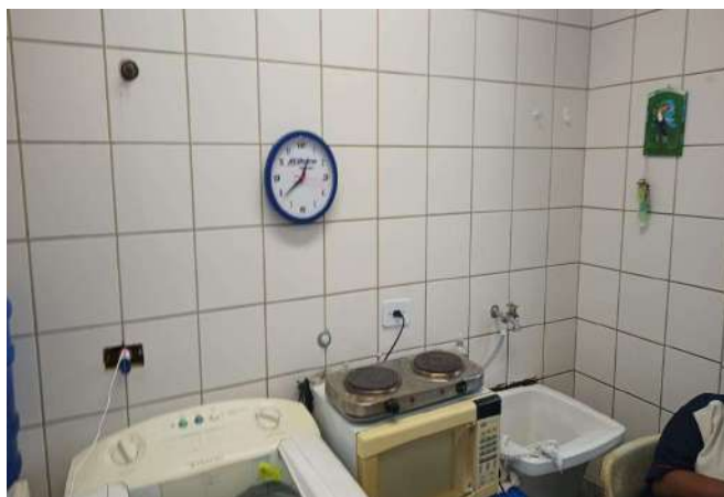
FOTO 253 COPA, LAVADERIA E VESTIÁRIO DE FUNCIONÁRIO
