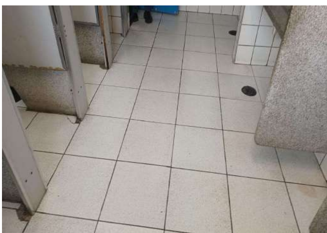
FOTO 75 BANHEIRO MASC ALUNO / PISO.
