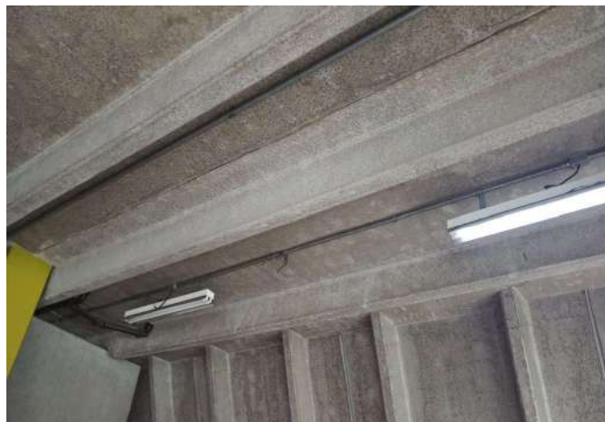
FOTO 80 PÁTIO COBERTO / TETO E LUMINÁRIA
