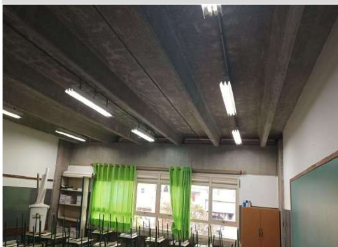
FOTO 190 SALA DE GEOGRAFIA / TETO, JANELA DE VIDRO
