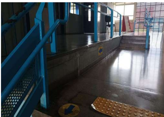
FOTO 105 PÁTIO COBERTO / PISO E CORRIMÃO.
