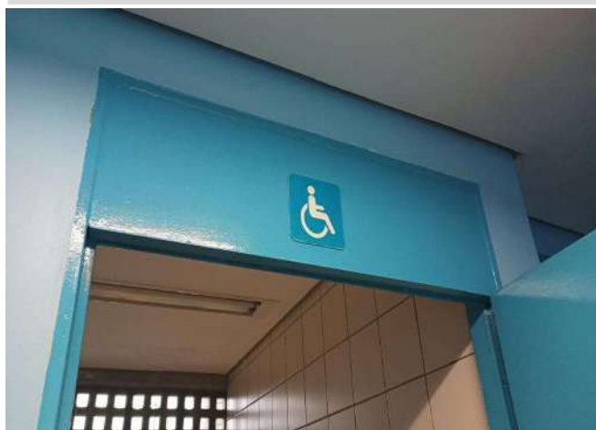
FOTO 234 BANHEIRO UNISSEX ALUNO / DEFICIENTE
