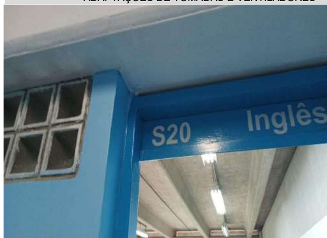
FOTO 180 SALA DE INGLÊS / PORTA
