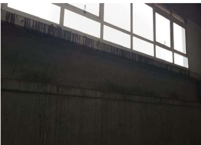
FOTO 231 PÁTIO COBERTO / JANELA DE VIDRO
