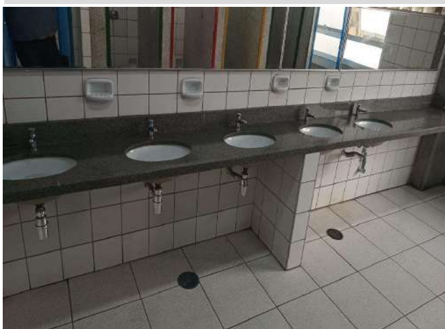
FOTO 215 BANHEIRO FEM ALUNO / BANCADA E LAVATÓRIO
