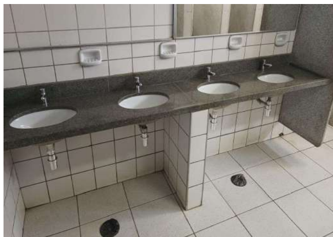
FOTO 70 BANHEIRO MASC ALUNO, BANCADA DO LAVATÓRIO.
