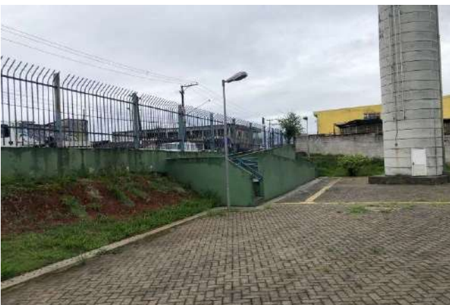
FOTO 270 SPDA DA CAIXA D'ÁGUA E CASA DE MÁQUINA
