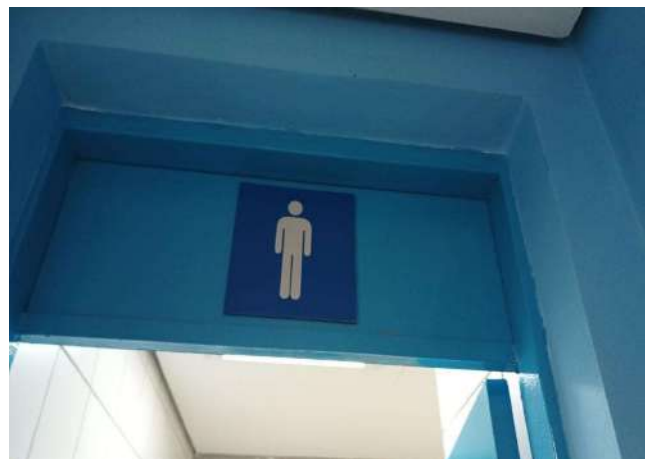
FOTO 240 BANHEIRO MASC FUNCIONÁRIO / PORTA
