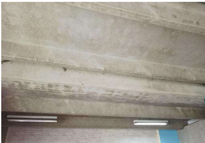
FOTO 79 PÁTIO COBERTO / TETO E LUMINÁRIA
