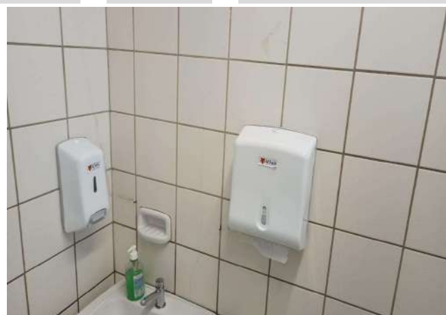
FOTO 236 BANHEIRO UNISSEX ALUNO / PAREDE
