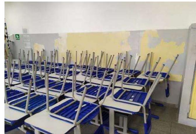
FOTO 142 Sala de aula 05, necessário pintura das paredes.
