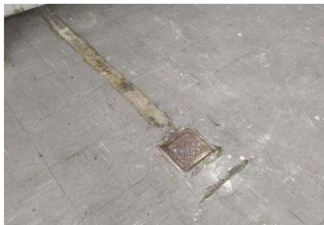
FOTO 122 Sala de aula 01, necessário reparos e substituição de piso vinílico danificado.
