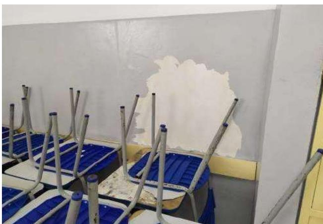
FOTO 137 Sala de aula 04, necessita de pintura das paredes.
