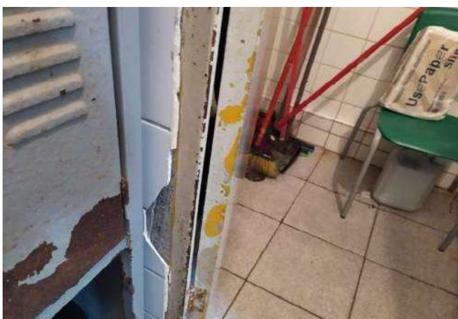
FOTO 77 Vestibário dos funcionários da limpeza, possui revestimento cerâmico danificado.
