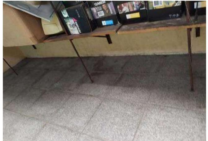
FOTO 196 Depósito 02 pav. Superior 02 - necessário pintura das paredes e instalação de rodapés.
