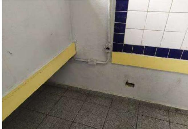
FOTO 146 Sala de aula 06, necessário revisão das paredes e instalações elétricas.
