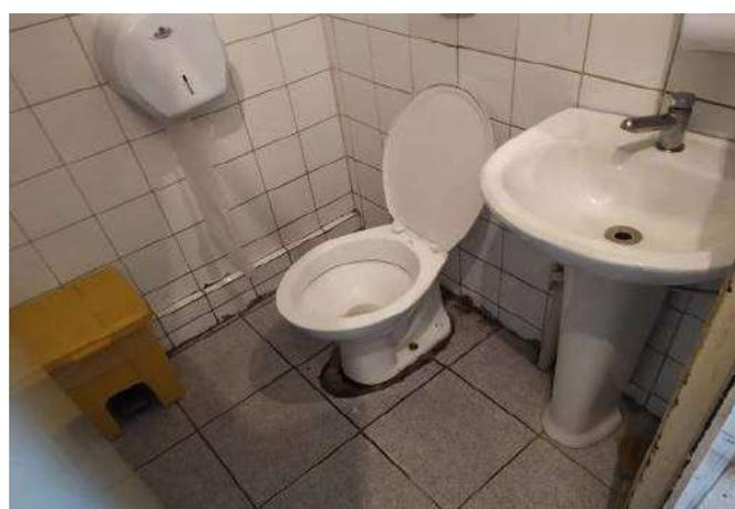
FOTO 78 Vestibário dos funcionários da limpeza, necessário substituição dos pisos danificados.
