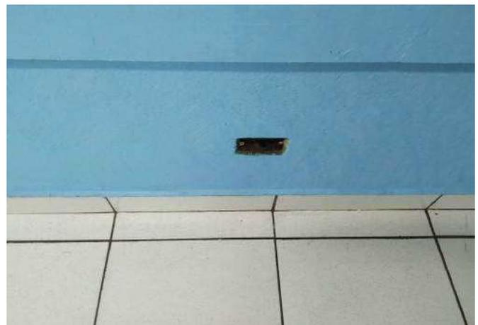
FOTO 184 Sala de aula 14, necessário revisão das instalações elétricas.
