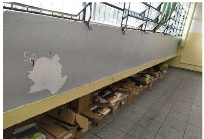
FOTO 138 Sala de aula 04, necessita de pintura das paredes.
