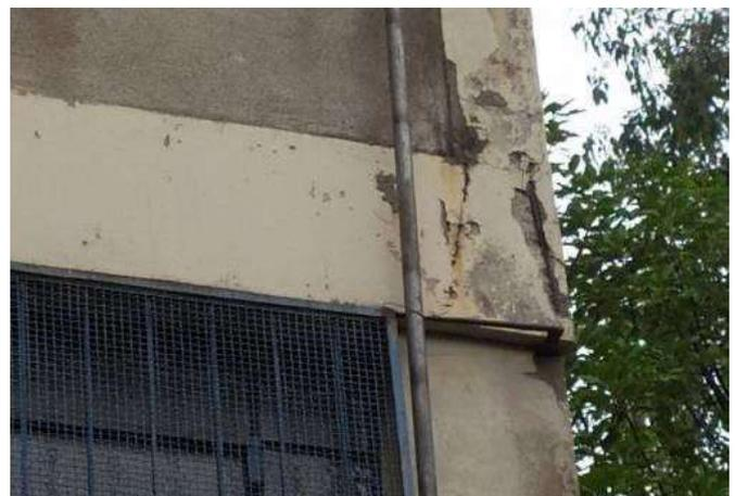
FOTO 216 Armadura do pilar de canto da fachada da unidade com armadura exposta.
