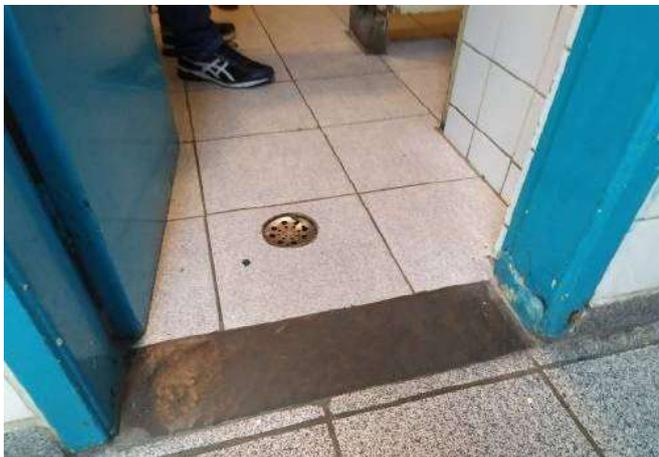
FOTO 73 Vestibário dos funcionários da limpeza, necessário troca de ralo danificado e nivelamento com o piso.
