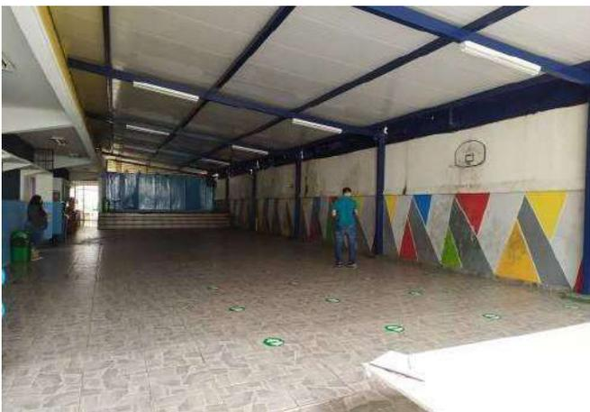
FOTO 93 Pátio Coberto, necessário revisão do fechamento metálico lateral da cobertura.
