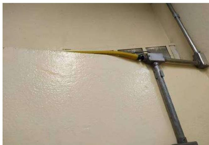
FOTO 40 Sala de auxílio de vida escolar (AVE), necessário revisão das instalações elétricas.
