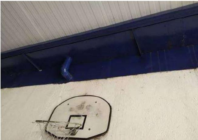
FOTO 85 Pátio Coberto, necessário revisão do fechamento metálico lateral da cobertura
