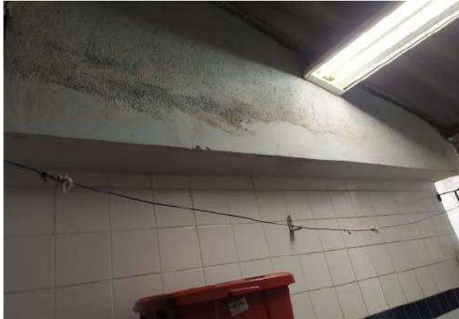
FOTO 211 Lavanderia - necessário pintura de trecho da parede.
