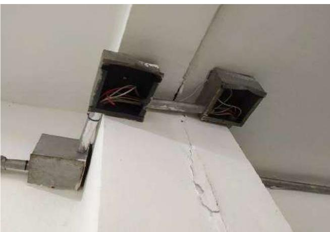
FOTO 113 Corredor pav superior 01 - necessário revisão das instalações elétricas.
