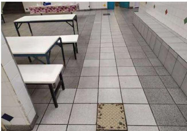
FOTO 55 Refeitório, necessário nivelamento do piso com as caixas de gordura e tampas de inspeção
