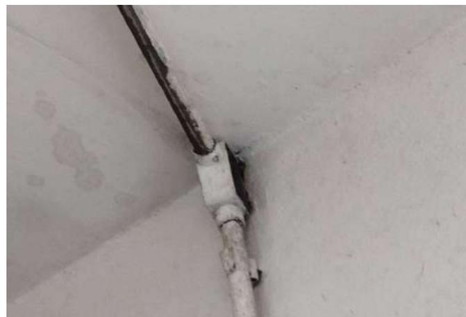
FOTO 198 Depósito 02 pav. Superior 02 - necessário revisão das instalações elétricas.
