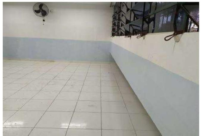
FOTO 190 Sala de aula 16, necessário pintura das paredes.
