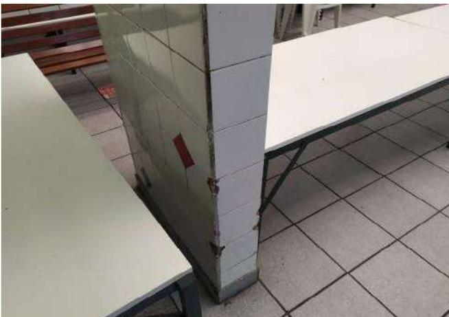
FOTO 51 Refeitório dos alunos, necessário recomposição dos revestimento cerâmicos das paredes.
