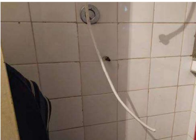
FOTO 81 Vestiário dos funcionários da limpeza, necessário revisão revestimento cerâmico.
