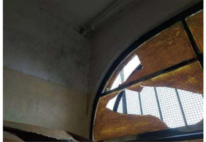
FOTO 194 Depósito 02 pav. Superior 02 - necessário troca de vidros quebrados no caixilho.
