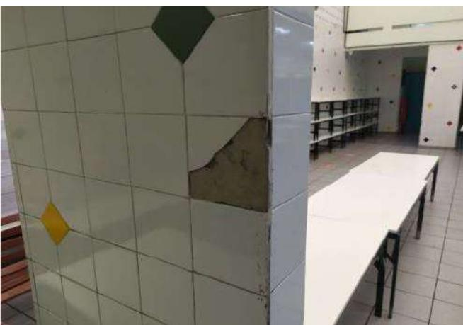
FOTO 53 Refeitório dos alunos, necessário recomposição dos revestimento cerâmicos das paredes.
