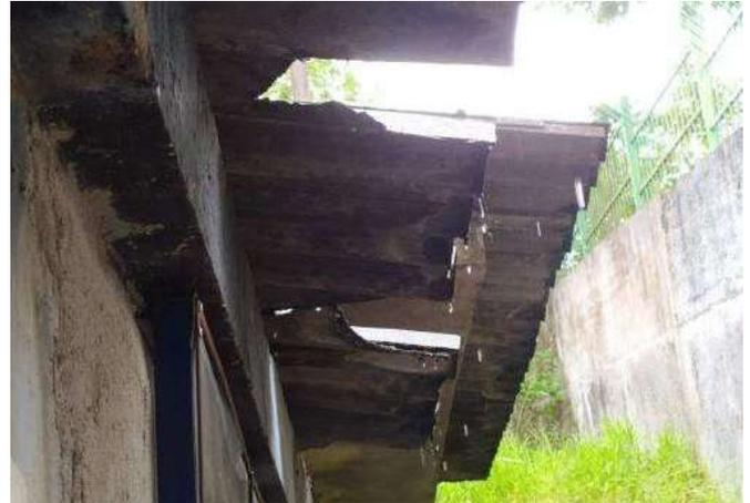
FOTO 212 Telhas danificadas na cozinha, despensa e copa dos funcionários, necessário revisão.
