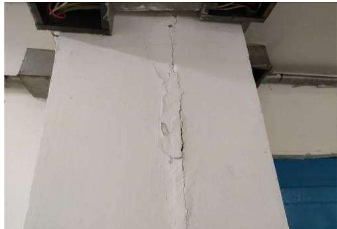
FOTO 112 Corredor pav superior 01 - necessário revisão das juntas de dilatação.
