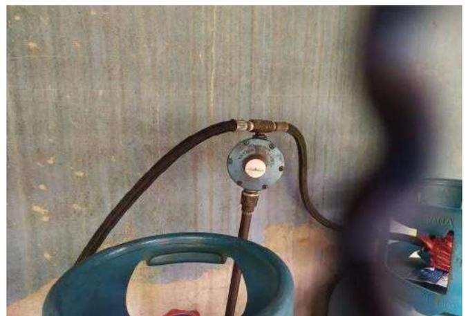
FOTO 214 Abrigo do gás, necessário revisão do registro e pintura das tubulações.
