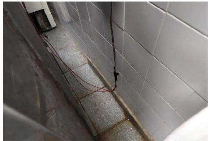
FOTO 68 Cozinha, necessário revisão das instalações elétricas.
