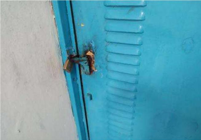
FOTO 61 Depósitos embaixo das escadas, necessário revisão das portas metálicas e fechaduras.
