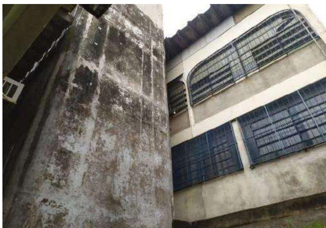
FOTO 215 Reservatório e fachada necessário pintura.
