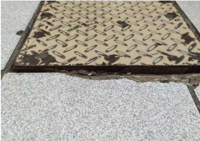
FOTO 49 Refeitório, necessário nivelamento do piso com as caixas de gordura e tampas de inspeção
