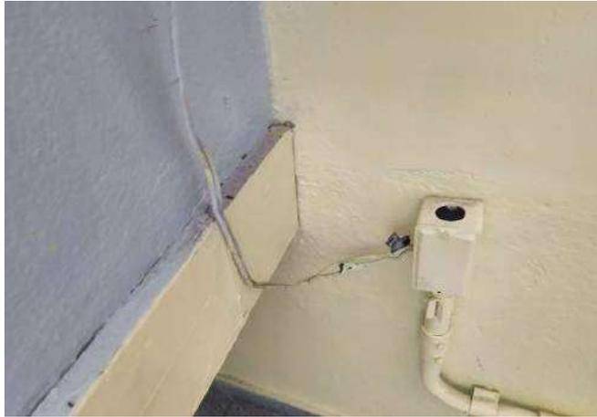
FOTO 139 Sala de aula 04, necessário revisão nas instalações elétricas.
