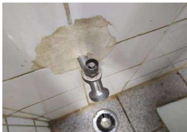
FOTO 18 Necessário instalação de nova torneira no banheiro masculino dos funcionários.
