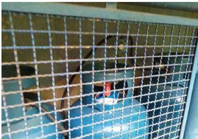
FOTO 213 Abrigo do gás, necessário revisão do registro e pintura das tubulações.
