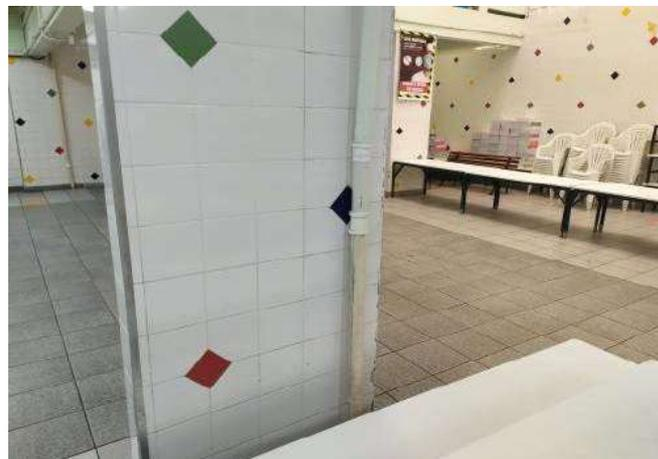
FOTO 56 Refeitório dos alunos, necessário recomposição dos revestimento cerâmicos das paredes
