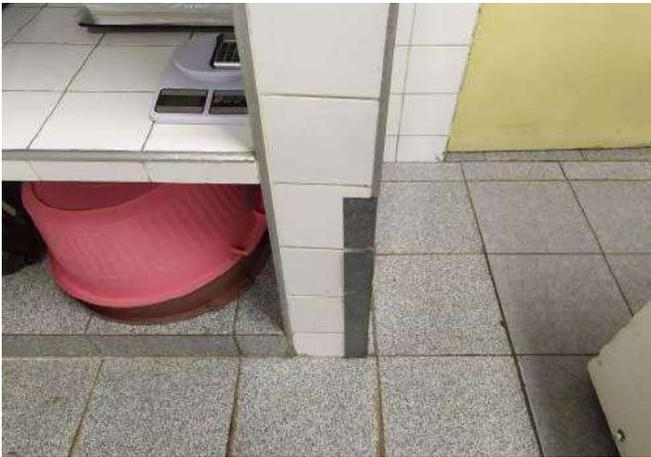
FOTO 67 Cozinha, necessário troca de revestimento cerâmico das paredes e bancadas.
