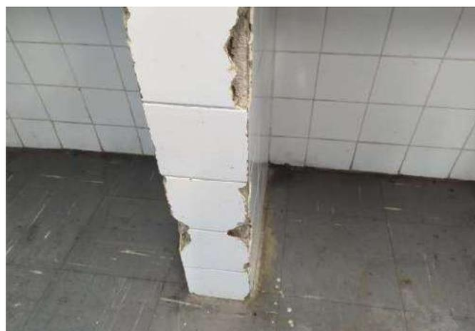
FOTO 124 Sala de aula 01, necessário substituição de revestimento cerâmico danificados.
