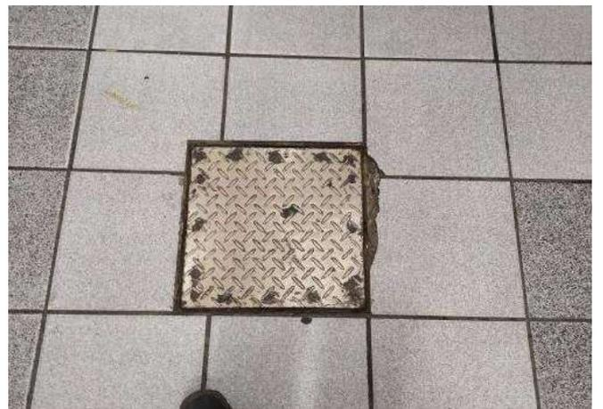
FOTO 48 Refeitório, necessário nivelamento do piso com as caixas de gordura e tampas de inspeção.
