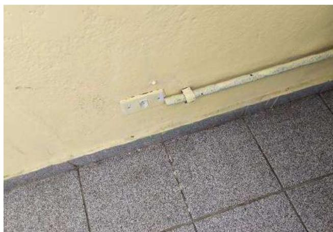
FOTO 147 Sala de aula 06, necessário revisão das paredes e instalações elétricas.
