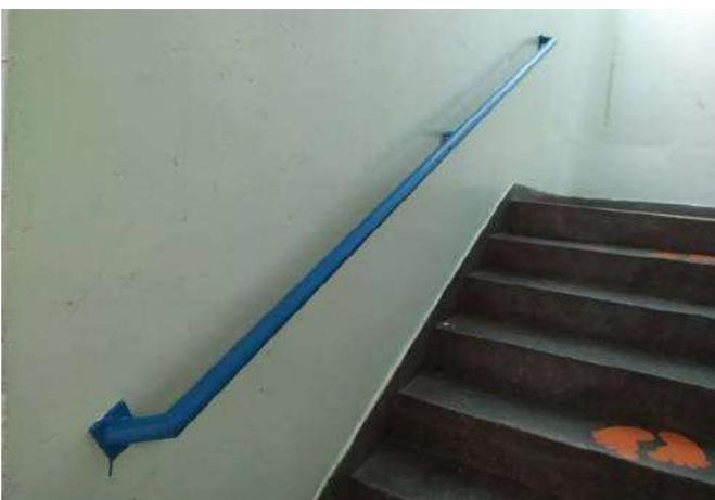
FOTO 108 Escada acesso pav superior, necessário revisão de pintura e acessibilidade.
