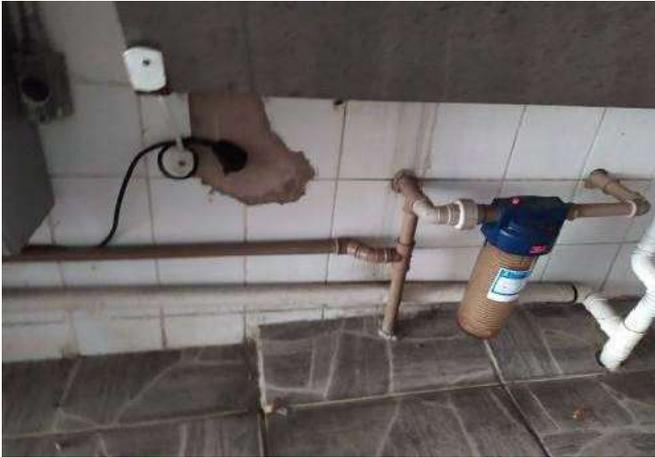
FOTO 91 Pátio coberto, necessário revisão do revestimento cerâmico danificado na parede do bebedouro.
