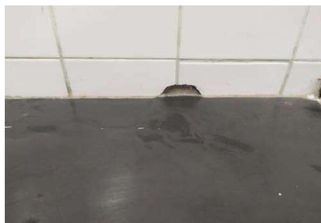
FOTO 125 Sala de aula 01, necessário substituição de revestimento cerâmico danificados
