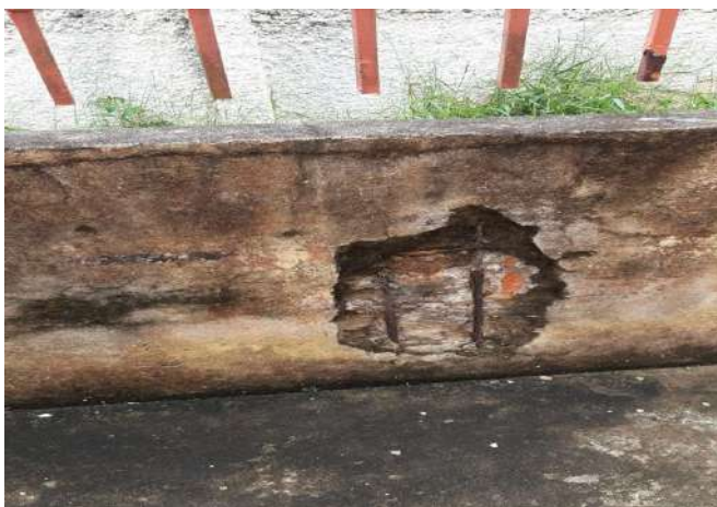
FOTO 41 REFORMA NA PAREDE DO CORREDOR DO FUNDO DA ESCOLA
