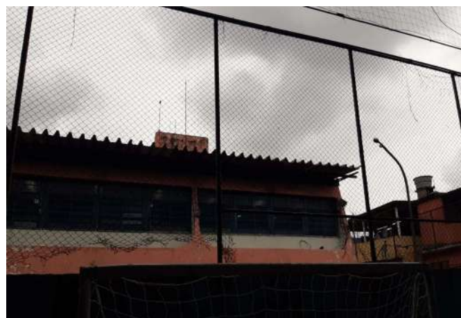
FOTO 46 SUBSTITUIR 500 METROS DE ALAMBRADO DA QUADRA COBERTA
