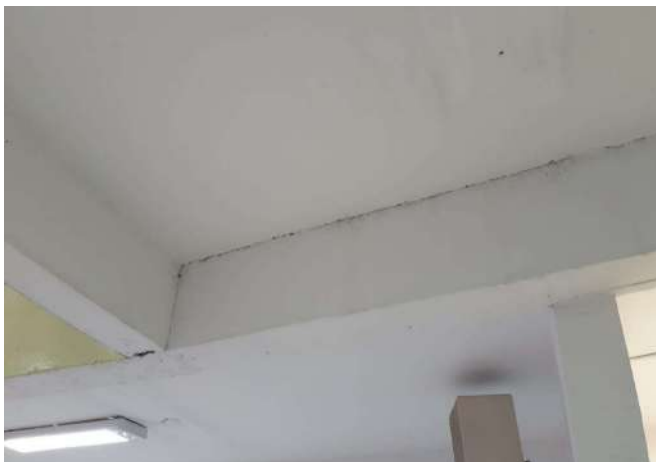
FOTO 37 TRINCA NO REFEITÓRIO
