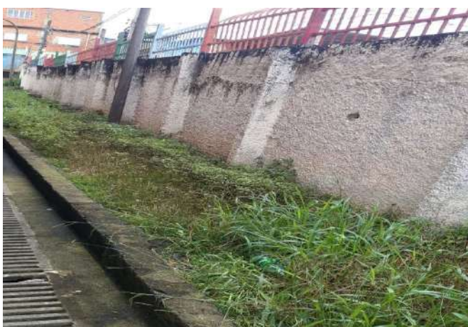
FOTO 15 PINTURA E ROÇAGEM NA PAREDE LATERAL DA ESCOLA
