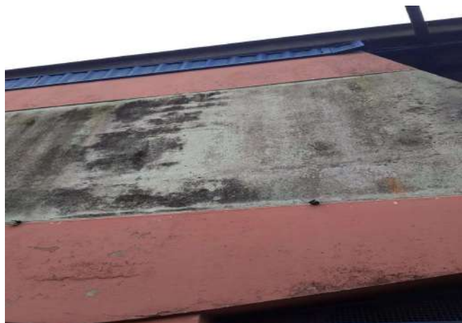
FOTO 30 PINTURA E SISTEMA DE DRENAGEM DE ÁGUAS PLUVIAIS
