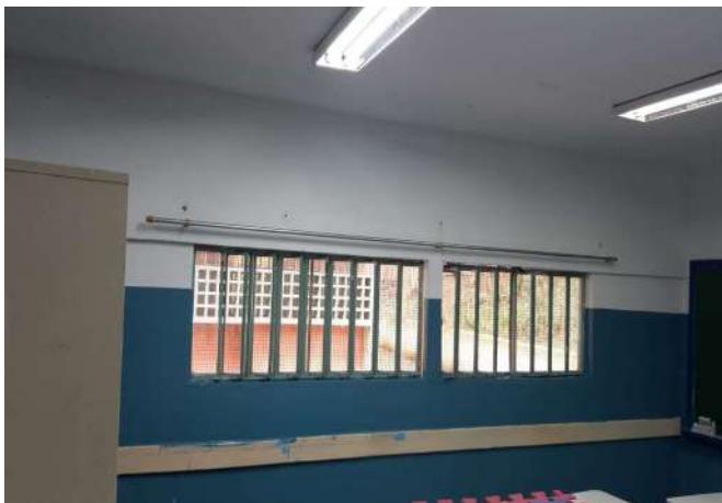
FOTO 1 SUBSTITUIÇÃO DE JANELAS DA SALA 13
