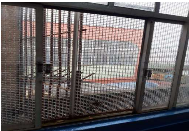
FOTO 19 Substituição de janelas da sala 6
