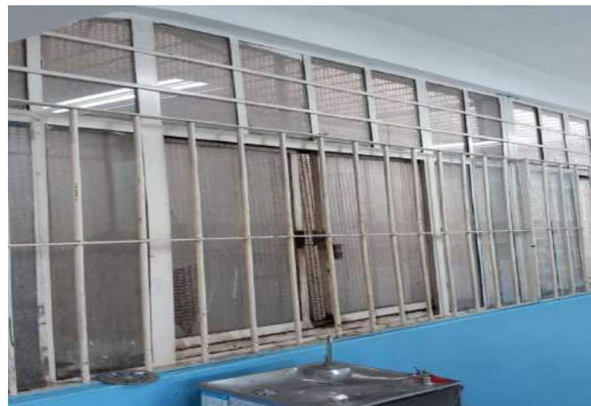
FOTO 2 SUBSTITUIÇÃO DE JANELAS DO CORREDOR DAS SALAS 6, 7 E 8
