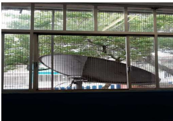
FOTO 3 SUBSTITUIÇÃO DE JANELAS DA SALA 10
