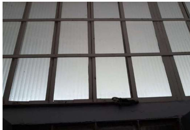
FOTO 26 SUBSTITUIÇÃO DE JANELAS E INSTALAR GRADES NO BANHEIRO FEMININO DOS ALUNOS
