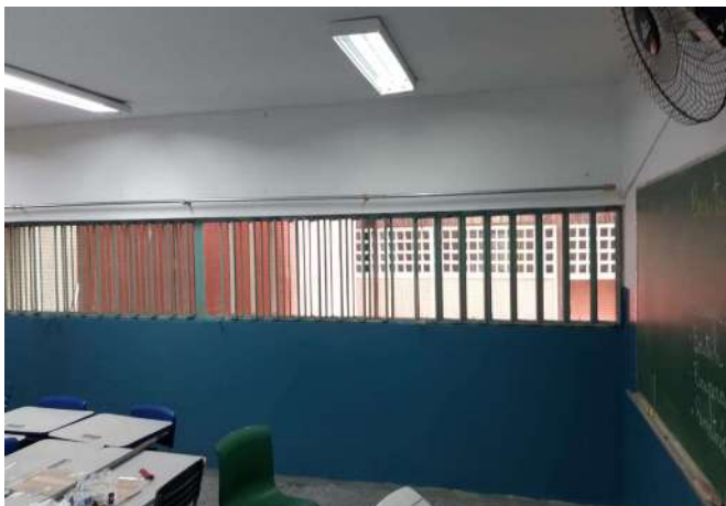
FOTO 25 SUBSTITUIÇÃO DE JANELAS DA SALA 14
