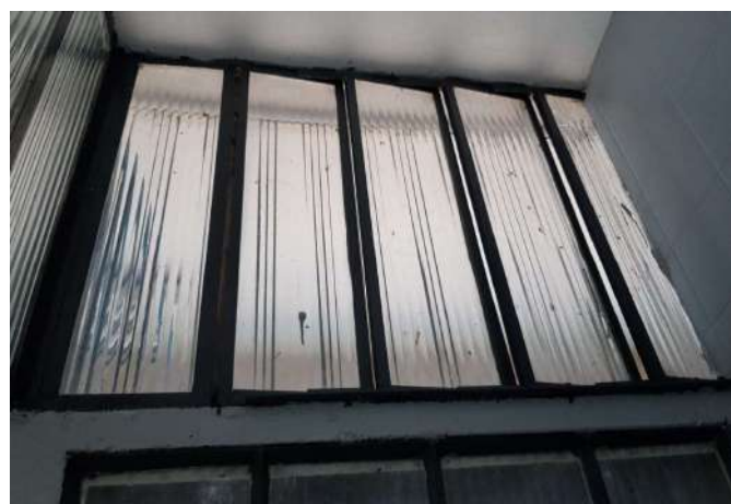
FOTO 30 SUBSTITUIÇÃO DE JANELAS NO REFEITÓRIO DOS FUNCIONÁRIOS
