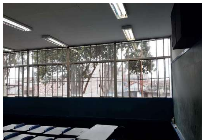
FOTO 4 SUBSTITUIÇÃO DE JANELAS DA SALA 8
