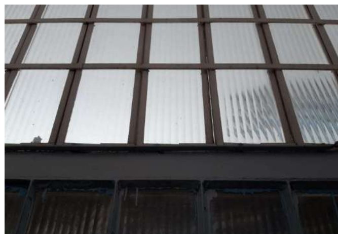
FOTO 22 Substituição de janelas no banheiro masculino dos alunos
