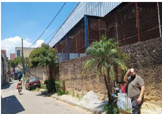
FOTO 97 MURO DE DIVISA DA LATERAL DIREITA.
