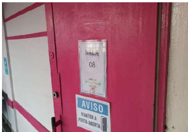
FOTO 210 SALA DE AULA 08.
