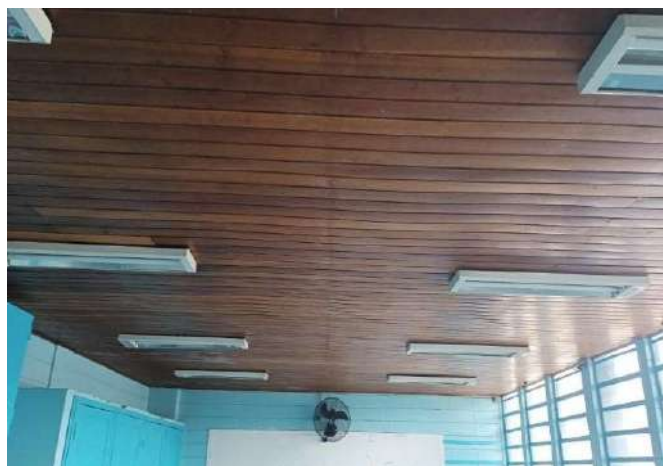
FOTO 206 SALA DE AULA 5, ADAPTAÇÕES DE TOMADAS E VENTILADORES.
