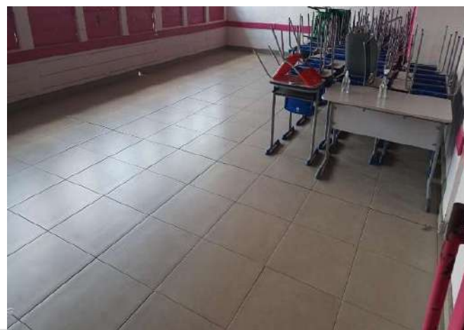
FOTO 211 SALA DE AULA 08.
