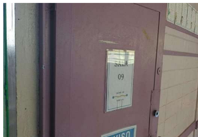
FOTO 233 SALA DE AULA 09.
