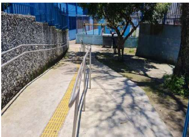
FOTO 3 RAMPA DE ACESSO A SECRETARIA
