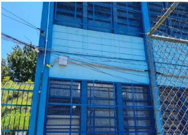
FOTO 13 FACHADA FRONTAL COM SPDA.
