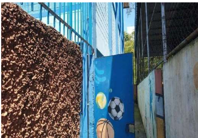
FOTO 117 CORREDOR DA QUADRA COBERTA, ACESSO AO PÁTIO EXTERNO.
