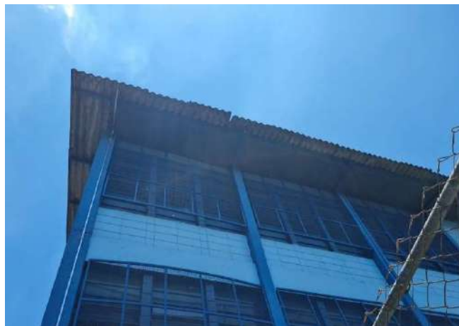
FOTO 14 FACHADA FRONTAL COM SPDA.
