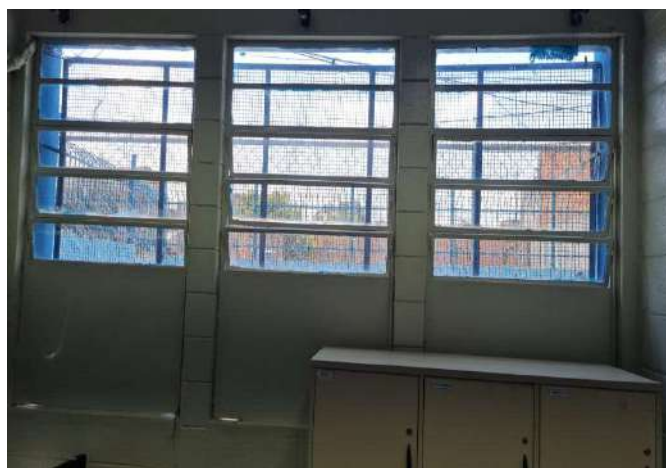
FOTO 22 LUBRIFICAÇÃO DOS CAIXILHO DA SECRETARIA.
