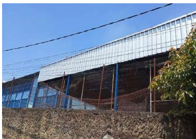
FOTO 100 MURO DE DIVISA /ALAMBRADO.
