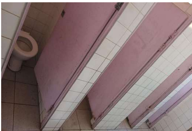
FOTO 151 BANHEIRO FEMININO ALUNO.
