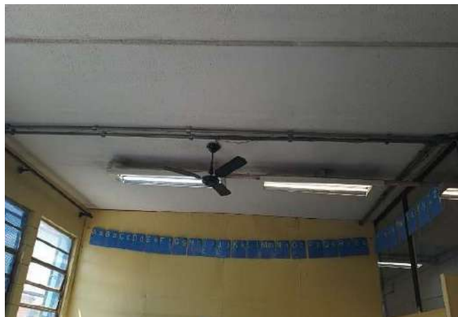
FOTO 110 SALA DE AULA 11
