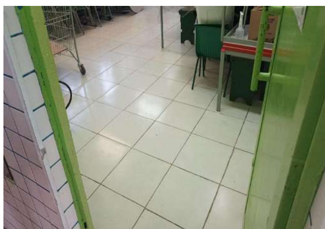
FOTO 166 SALA DE AULA 2.
