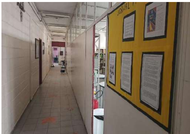
FOTO 109 CORREDOR ACESSO AS SALAS DE AULAS
