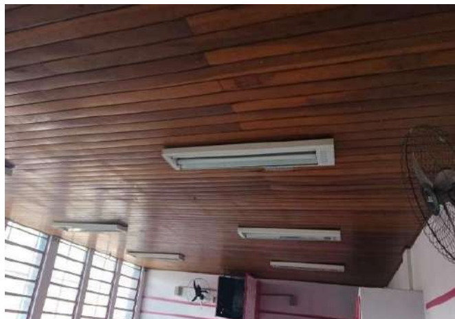
FOTO 212 SALA DE AULA 08, ADAPTAÇÕES DE TOMADAS E VENTILADORES.
