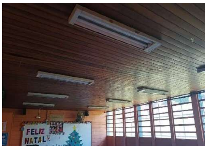
FOTO 248 SALA DE AULA 13, ADAPTAÇÕES DE TOMADAS E VENTILADORES.
