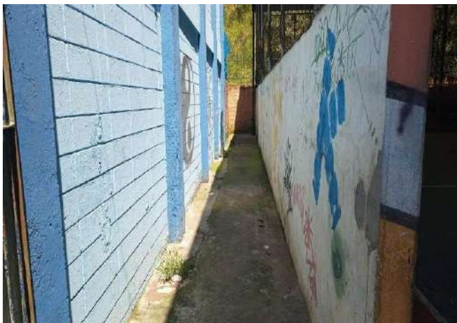
FOTO 115 PISO DO CORREDOR.
