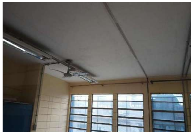
FOTO 192 SALA DE APOIO PEDAGÓGICO, ADAPTAÇÕES DE TOMADAS E VENTILADORES.
