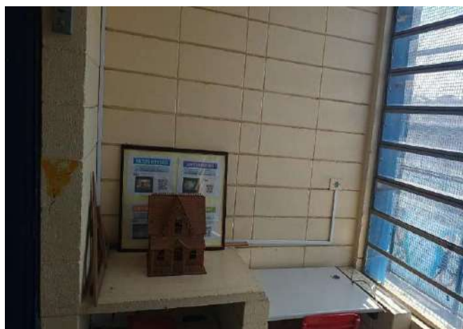
FOTO 262 SALA DE AULA 11 COM ADAPTAÇÕES DE TOMADAS.
