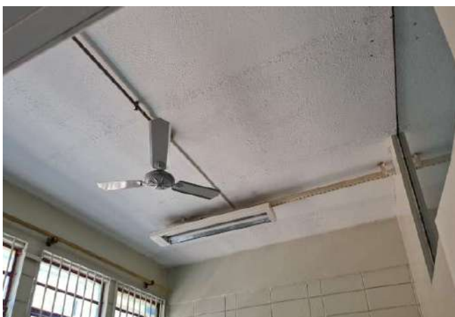
FOTO 39 ADAPTAÇÕES DE TOMADAS E VENTILADORES SALA ASSISTENTES/DIREÇÃO.
