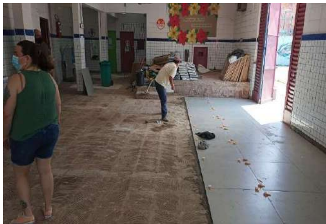
FOTO 121 PÁTIO INTERNO (EM MANUTENÇÃO).
