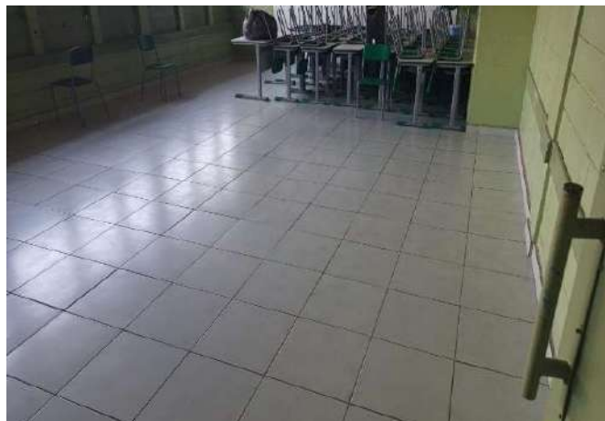
FOTO 244 SALA DE AULA 14.
