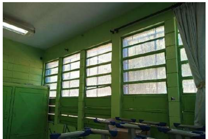
FOTO 110 SALA DE AULA 2.
