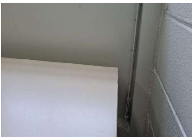
FOTO 21 LUBRIFICAÇÃO DOS CAIXILHO DA SECRETARIA.
