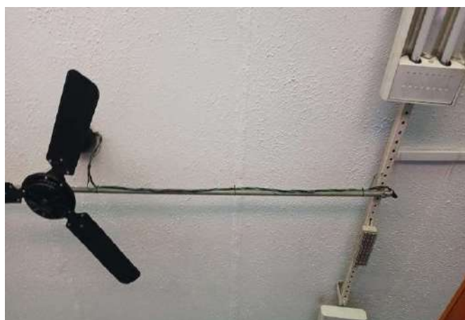
FOTO 188 SALA DOS PROFESSORES COM ADAPTAÇÕES DE TOMADAS E VENTILADORES.
