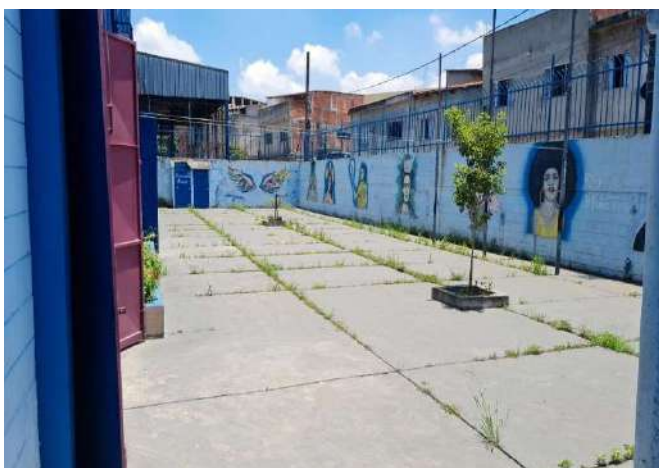
FOTO 15 PISO DO PÁTIO EXTERNO / JUNTA DE DILATAÇÃO.
