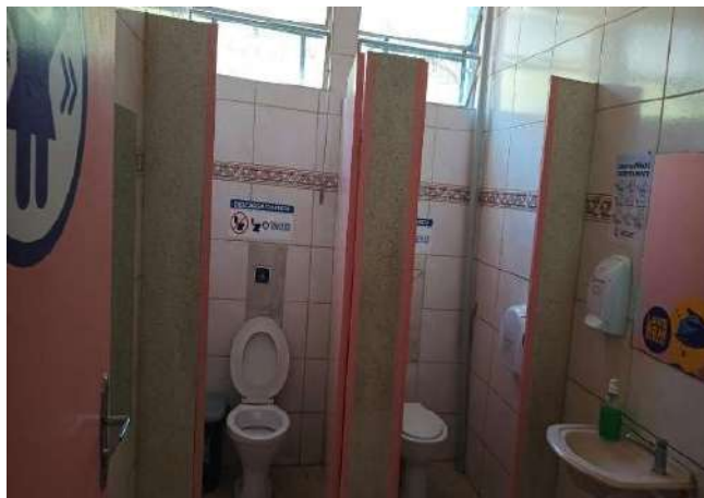
FOTO 177 BANHEIRO FEMININO FUNCIONÁRIO.
