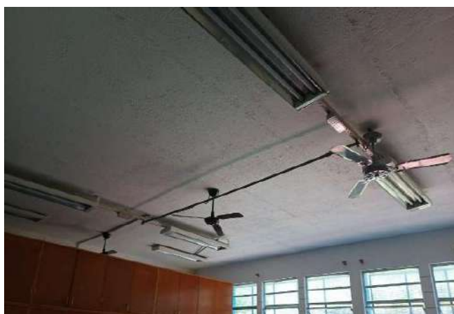
FOTO 187 SALA DOS PROFESSORES COM ADAPTAÇÕES DE TOMADAS E VENTILADORES.
