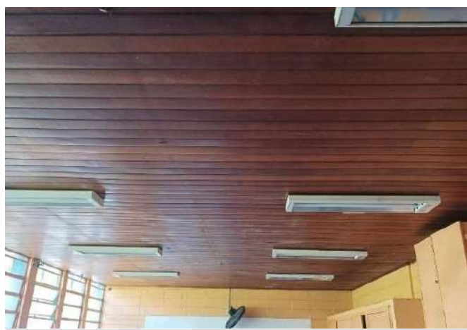
FOTO 200 SALA DE AULA 06.
