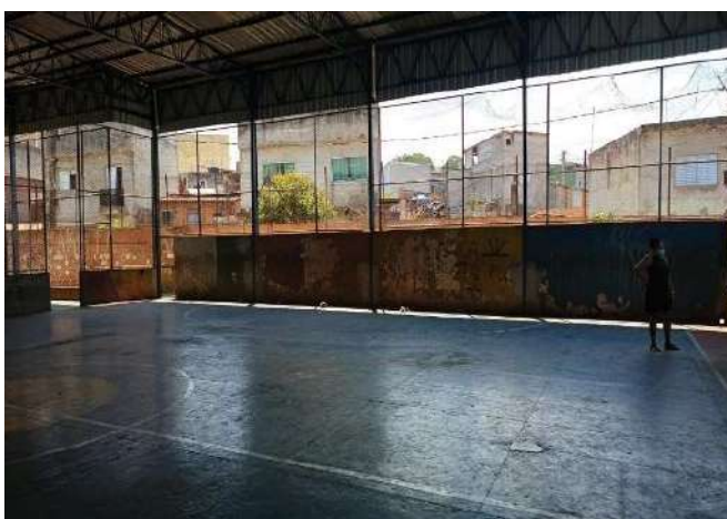
FOTO 113 PISO DA QUADRA COBERTA.
