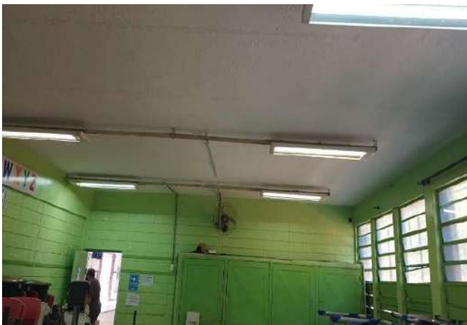
FOTO 167 SALA DE AULA 2, ADAPTAÇÕES DE TOMADAS E VENTILADORES.
