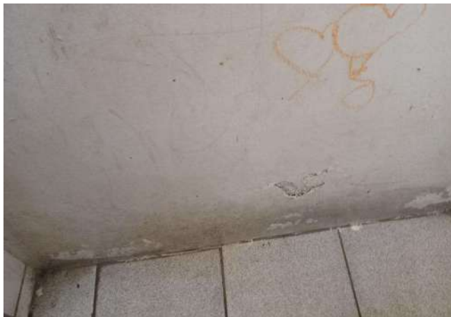
FOTO 158 BANHEIRO FEM ALUNO.
