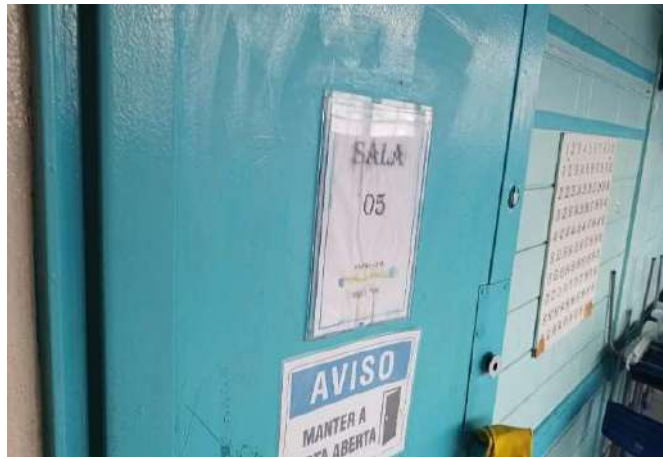
FOTO 204 SALA DE AULA 5.
