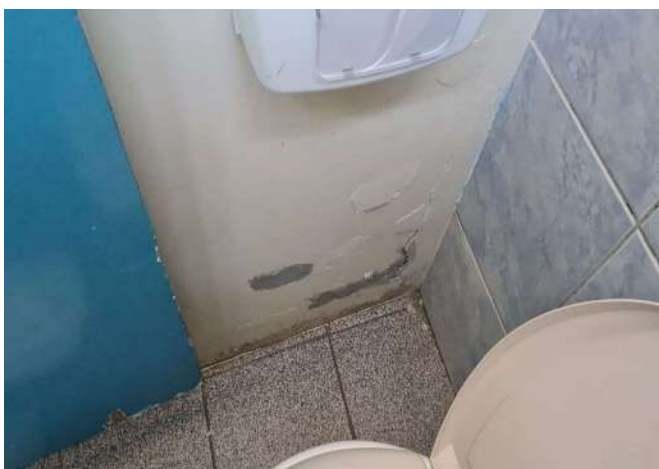
FOTO 69 BANHEIRO DE FUNCIONÁRIOS.
