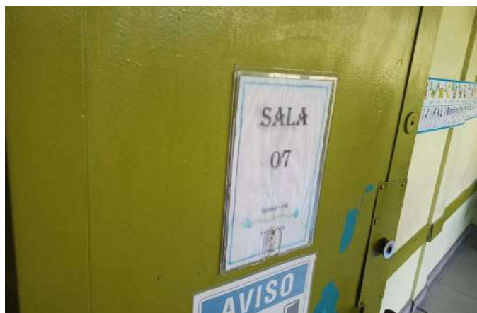
FOTO 215 SALA DE AULA 07.
