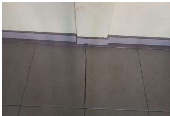
FOTO 218 SALA DE AULA 07.
