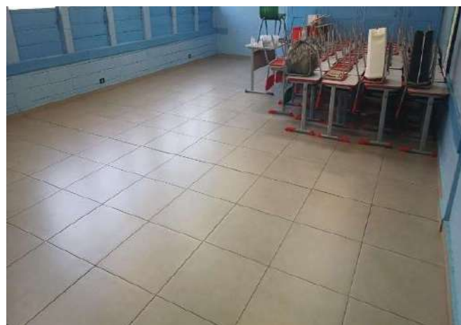
FOTO 252 SALA DE AULA 12.
