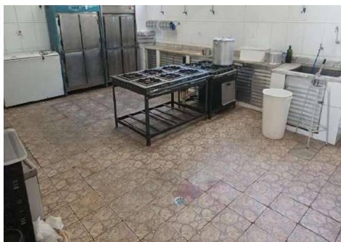
FOTO 124 PISO DA COZINHA.
