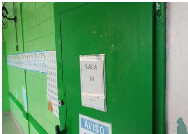
FOTO 236 SALA DE AULA 10.
