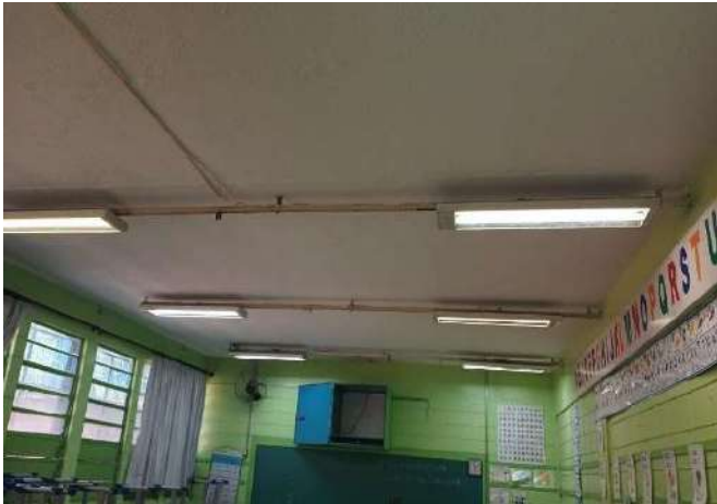
FOTO 109 SALA DE AULA 2.
