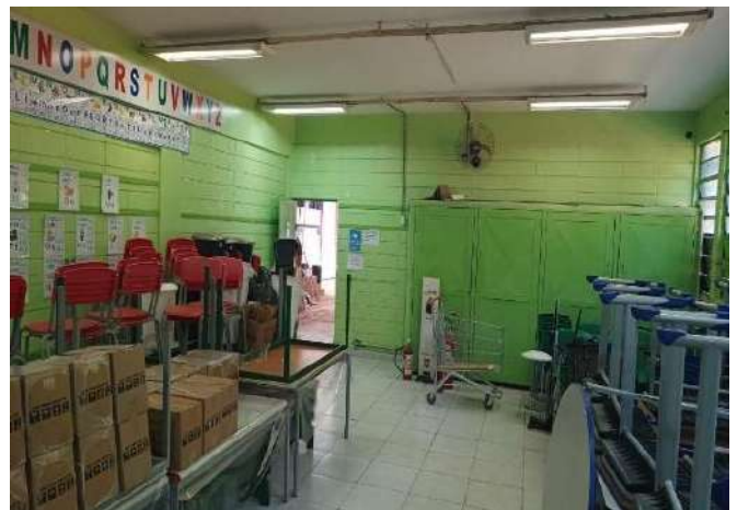
FOTO 168 SALA DE AULA 2.
