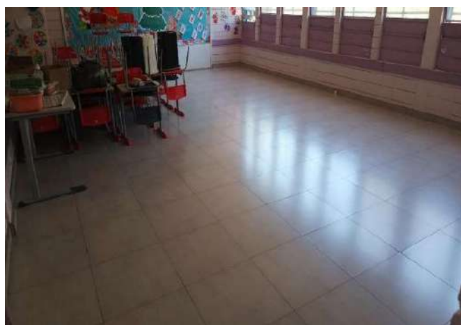
FOTO 234 SALA DE AULA 09.
