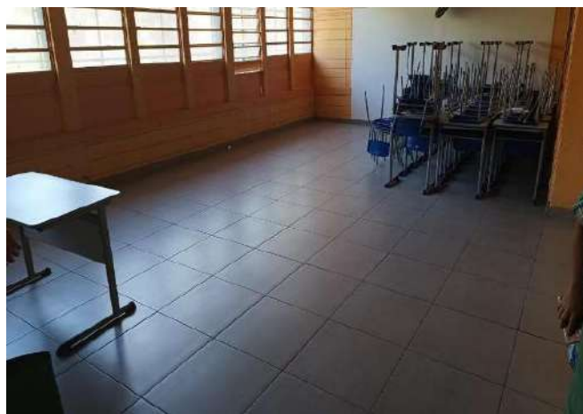
FOTO 198 SALA DE AULA 06.
