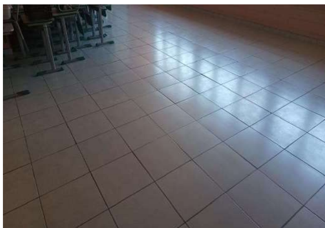
FOTO 247 SALA DE AULA 16.
