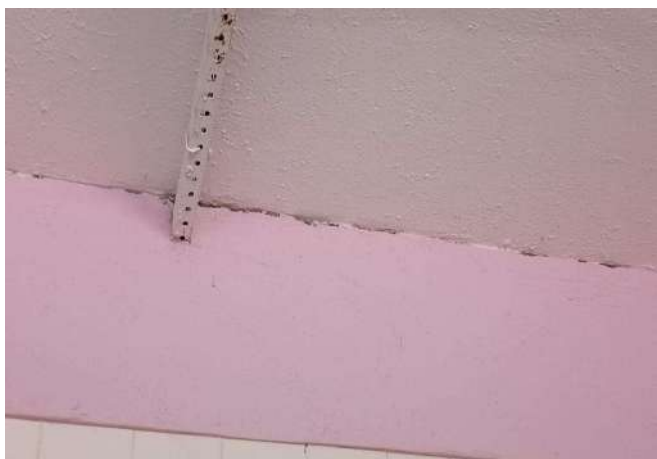
FOTO 160 BANHEIRO FEM ALUNO.
