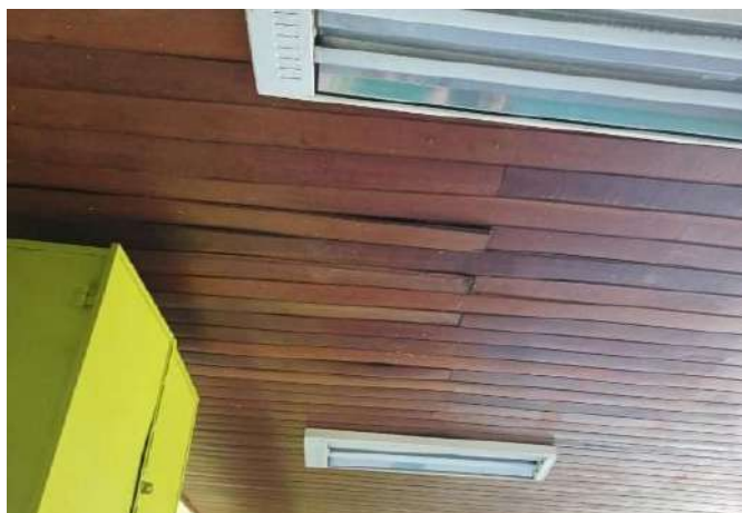
FOTO 217 SALA DE AULA 07.
