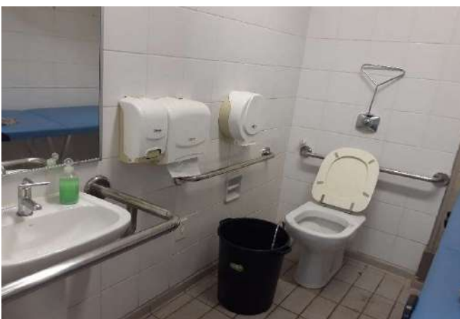
FOTO 107 Sanit. para Deficiente Masc. - Visão geral
