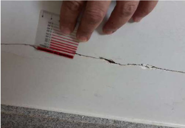
FOTO 31 Laboratório de Informática - Fissura
