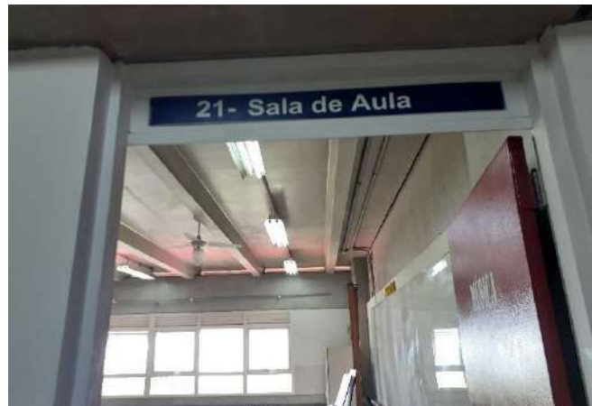
FOTO 74 Sala de Música - Teto com mancha de infiltração
