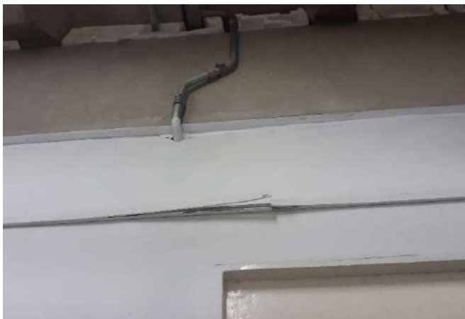
FOTO 67 Sala dos Professores - Canaleta solta
