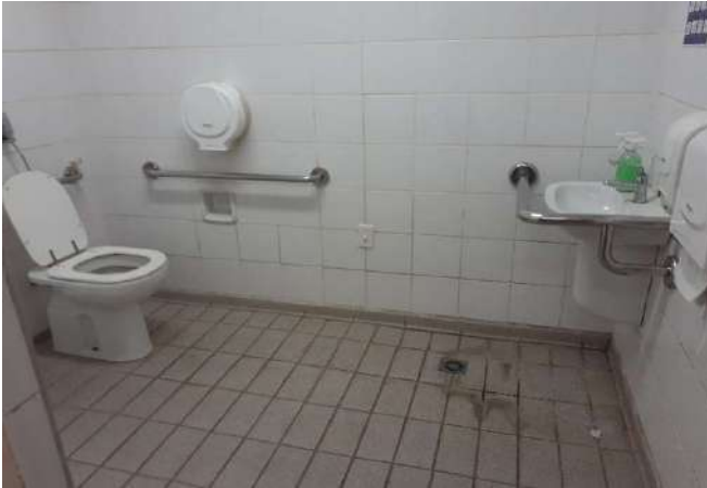
FOTO 103 Sanit. para Deficiente Fem. - Visão geral
