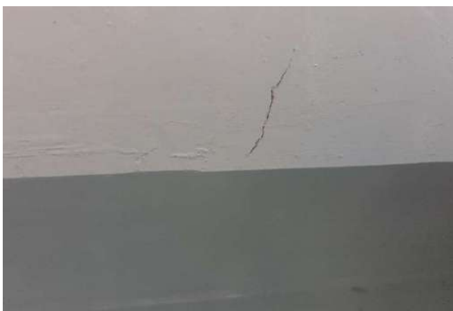
FOTO 71 Sala de Video - Bolhas e trinca
