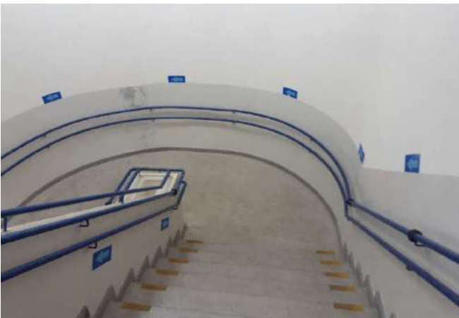
FOTO 105 Escadas e circulação - Visão geral
