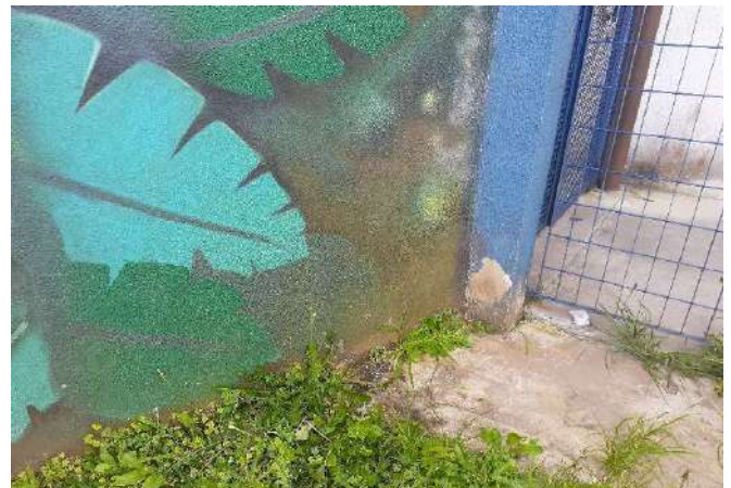
FOTO 58 Refeitório Func. - Umidade do solo
