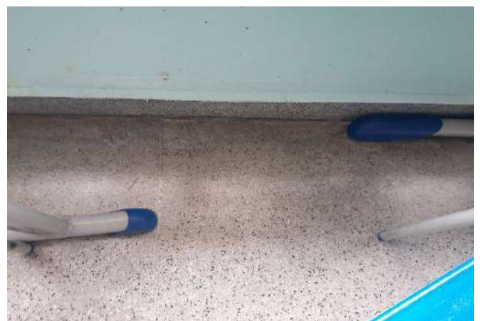
FOTO 96 Sala 15 - Rodapé com deficiência na juntas
