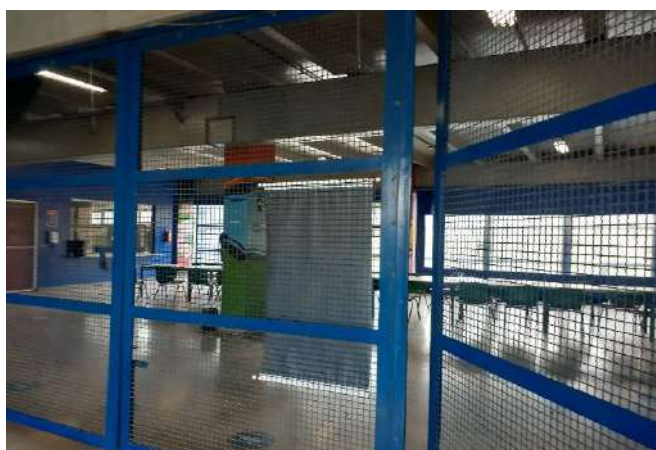
FOTO 3 Acesso - Visão geral
