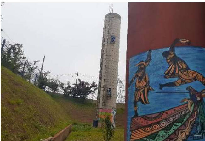
FOTO 105 Caixa d' Água - Visão geral
