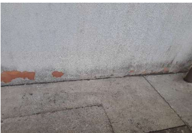
FOTO 59 Refeitório Func. - Umidade do solo
