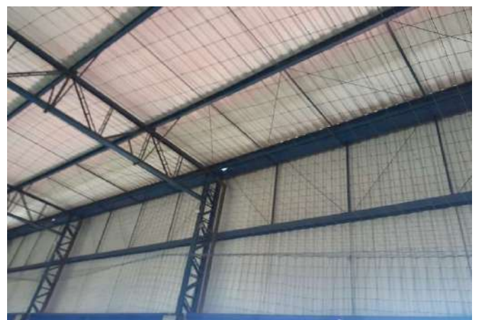
FOTO 108 Cobertura - Abertura 2 aberturas
