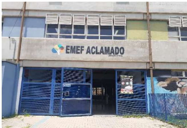
FOTO 1 Fachada / Entrada - Visão geral
