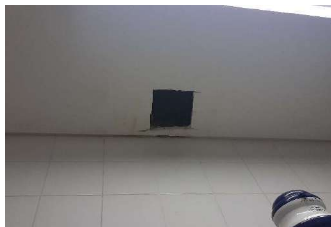
FOTO 108 Sanit Func Masc - Abertura Teto (Forro)
