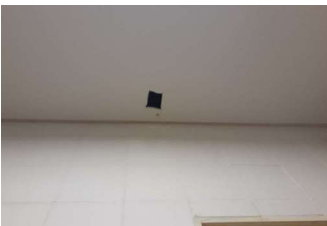
FOTO 107 Escada e circulação - Abertura no teto
