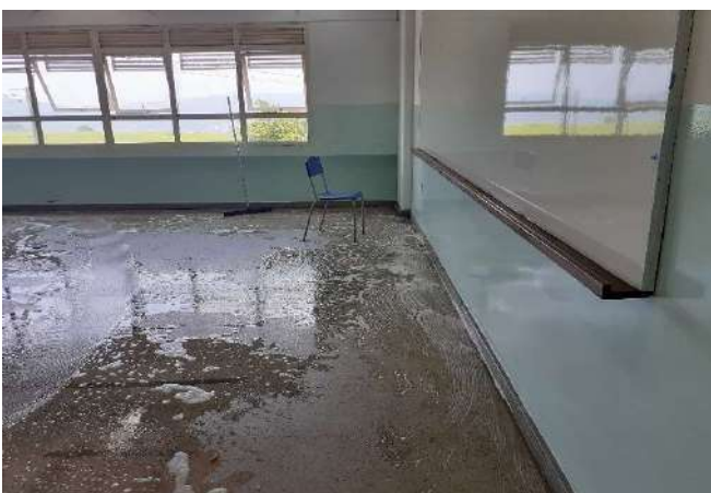
FOTO 101 Sala 23 - Lavagem da sala
