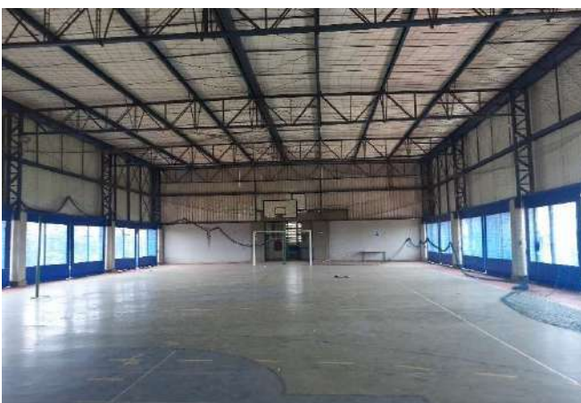
FOTO 107 Cobertura - Visão geral
