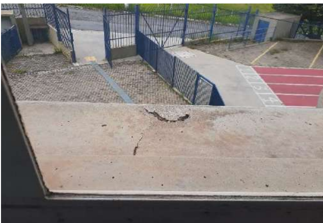
FOTO 99 Sala 17 - Beiral com partes quebradas
