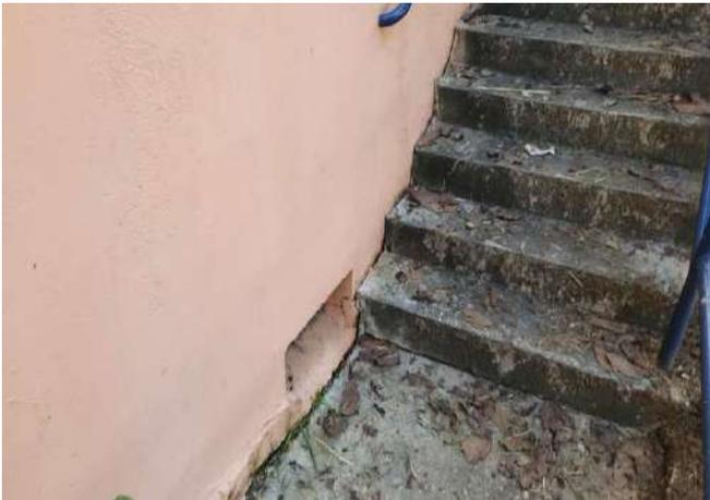
FOTO 19 PASSEIO INTERNO, RECALQUE DE PISO
