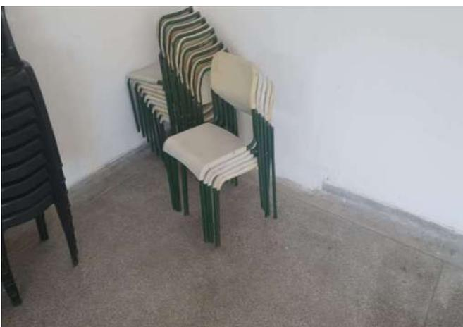
FOTO 71 LABORATÓRIO COM AUSÊNCIA DE RODAPÉ.
