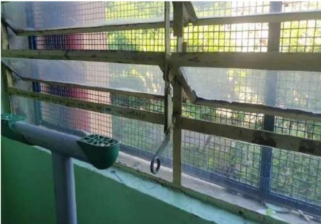
FOTO 175 SALA DE AULA, CAIXILHO SEM PINTURA E SEM LUBRIFICAÇÃO.
