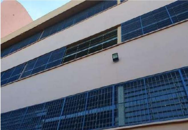
FOTO 31 FACHADA, AUSÊNCIA DA TELA DE PROTEÇÃO.
