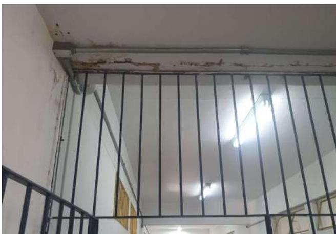
FOTO 185 CORREDOR INTERNO COM INFILTRAÇÃO PELA JUNTA DE DILATAÇÃO DO BLOCO.
