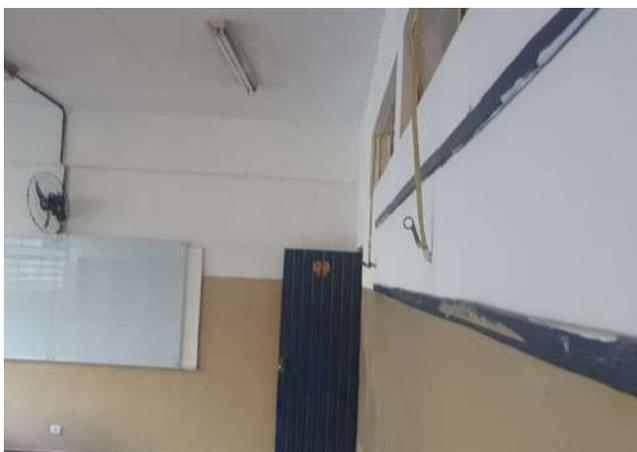
FOTO 287 SALA DE AULA 04 COM IMPROVISO NA REDE ELÉTRICA DE ILUMINAÇÃO E VENTILAÇÃO.
