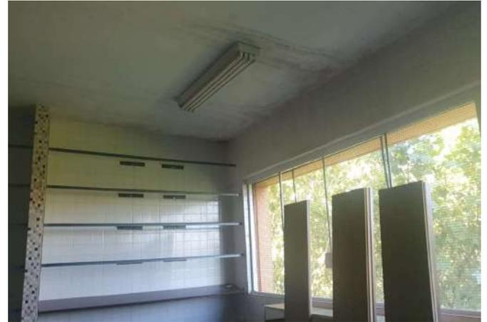
FOTO 134 SALA DE LEITURA COM INFILTRAÇÃO.
