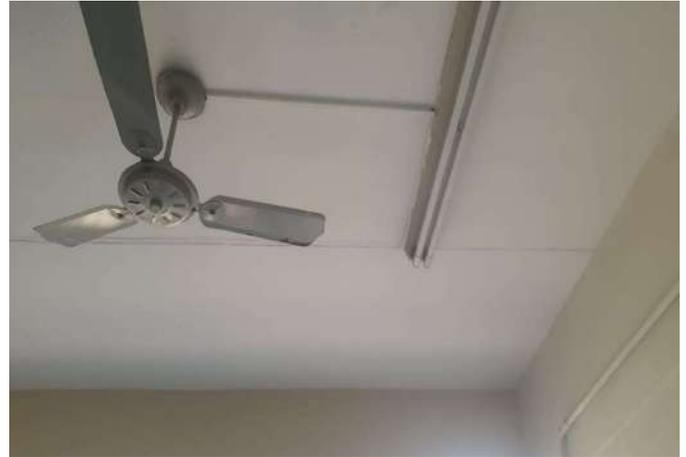
FOTO 224 SALA DE AULA 09, IMPROVISO NA REDE ELÉTRICA DE ILUMINAÇÃO E VENTILAÇÃO.
