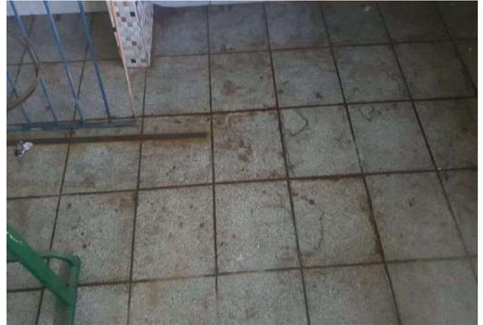
FOTO 140 DEPÓSITO COM PISO DANIFICADO COM FERRUGEM E PEÇAS OCAS.
