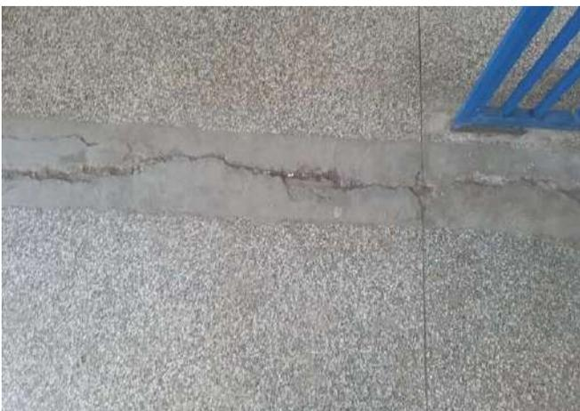
FOTO 179 CORREDOR INTERNO COM TRINCA NA JUNTA DE DILATAÇÃO DO PISO GRANILITE.
