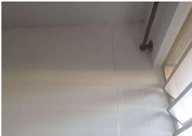
FOTO 355 SALA DE AULA 11 COM TRINCA NO REVESTIMENTO DE PAREDE.
