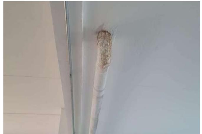
FOTO 360 CORREDOR INTERNO COM IMPROVISO NA REDE DE ESGOTO/CAPTAÇÃO DE ÁGUA.
