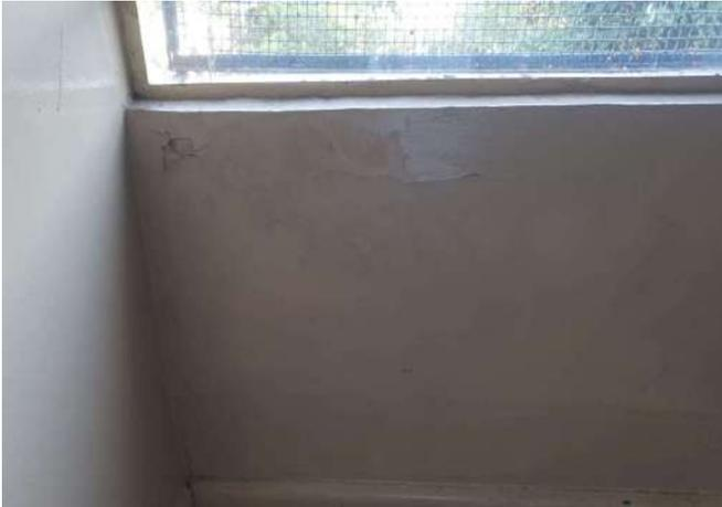
FOTO 193 SALA DE ARTE COM INFILTRAÇÃO PRÓXIMO AO CAIXILHO.
