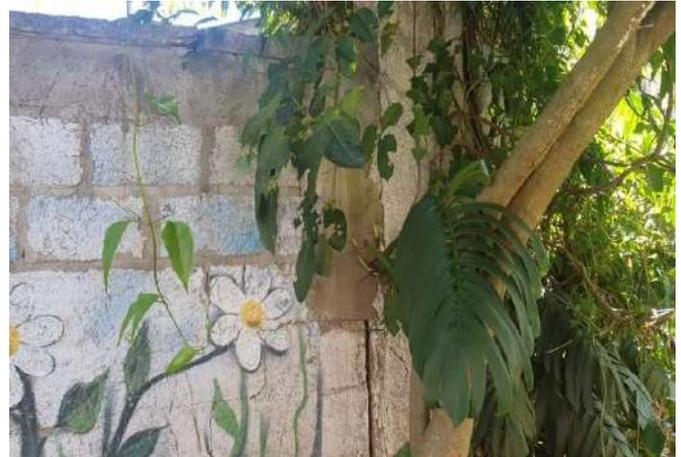
FOTO 2 MURO DE DIVISA COM JUNTA DE DILATAÇÃO SEM TRATAMENTO.
