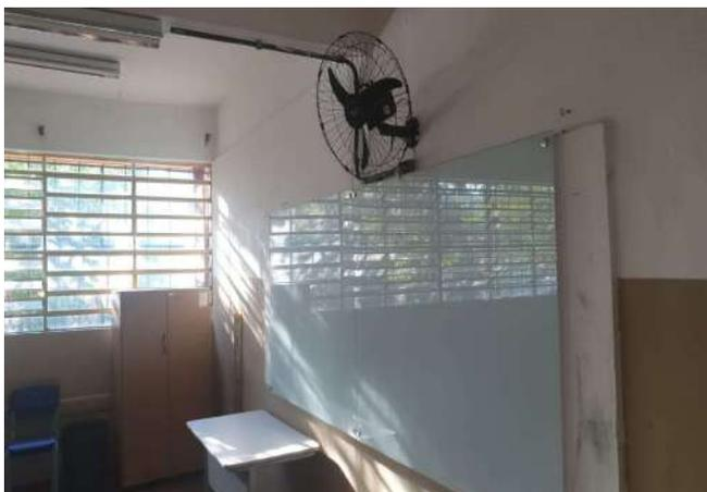
FOTO 321 SALA DE AULA 16 COM IMPROVISO NA REDE ELÉTRICA DE ILUMINAÇÃO E VENTILAÇÃO.
