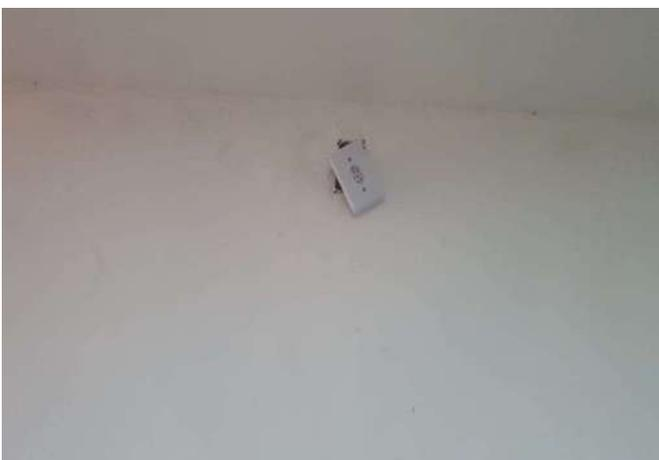
FOTO 203 SALA DE ARTE, IMPROVISO NA REDE ELÉTRICA ACABAMENTO SOLTO/DANIFICADO.
