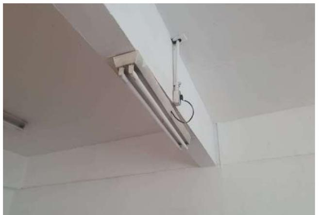
FOTO 352 SALA DE AULA 17 COM IMPROVISO NA REDE ELÉTRICA DE ILUMINAÇÃO E VENTILAÇÃO.
