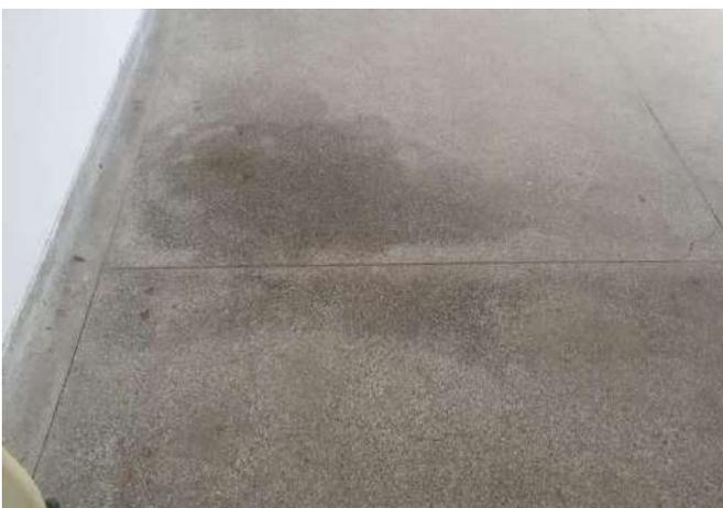
FOTO 101 LABORATÓRIO COM UMIDADE NO PISO DEVIDO A INFILTRAÇÃO DO TETO.
