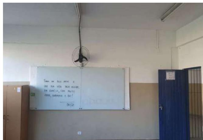
FOTO 357 SALA DE AULA 03 COM IMPROVISO NA REDE ELÉTRICA DE ILUMINAÇÃO E VENTILAÇÃO.
