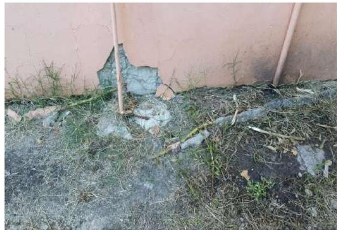
FOTO 28 PASSEIO EXTERNO, REVESTIMENTO SOLTO.
