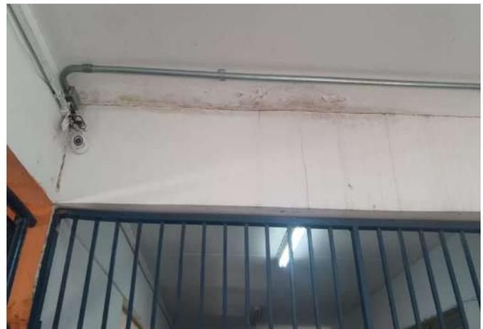
FOTO 94 CORREDOR INTERNO, INFILTRAÇÃO NA JUNTA DE DILATAÇÃO.
