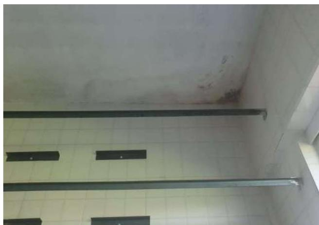
FOTO 143 SALA DE LEITURA(17) INFILTRAÇÃO NO TETO.
