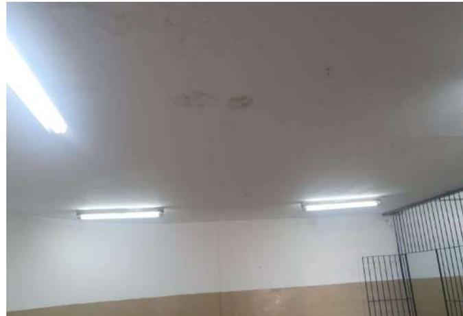
FOTO 200 INFILTRAÇÃO NA ESCADA SOBRE RESERVATÓRIO.
