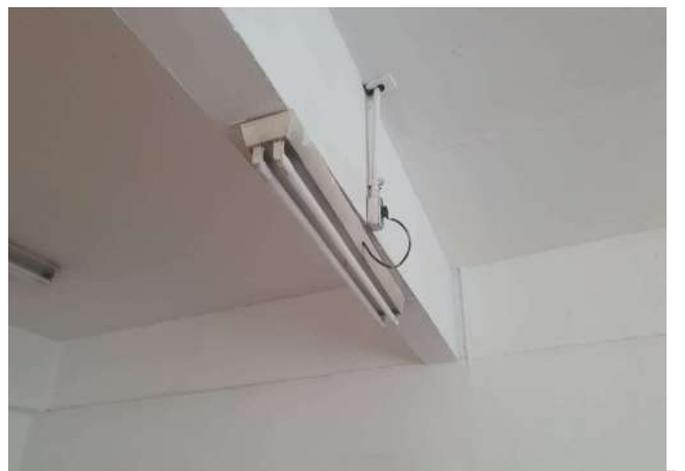
FOTO 326 SALA DE AULA 14 COM IMPROVISO NA REDE ELÉTRICA DE ILUMINAÇÃO E VENTILAÇÃO.
