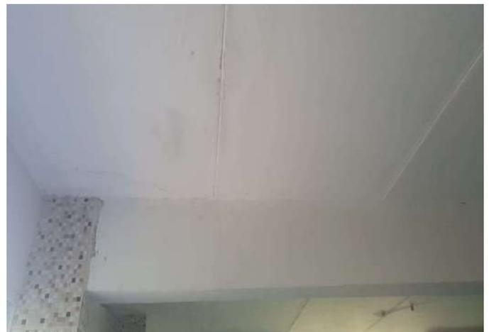
FOTO 152 CORREDOR INTERNO COM INFILTRAÇÃO.
