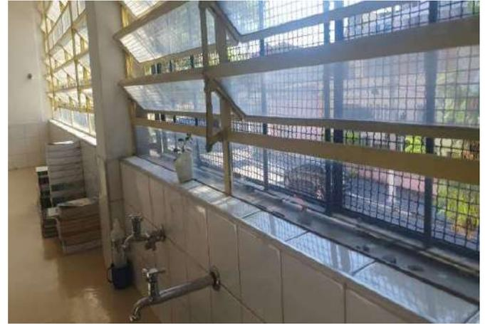
FOTO 86 LABORATÓRIO, CAIXILHO COM AUSÊNCIA DE BRAÇO DE ALAVANCA E ALAVANCA.
