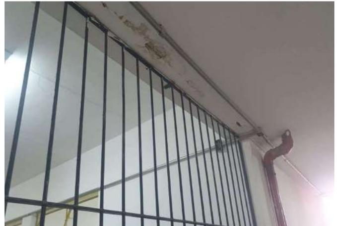
FOTO 188 CORREDOR INTERNO, INFILTRAÇÃO NA JUNTA DE DILATAÇÃO DOS BLOCOS.
