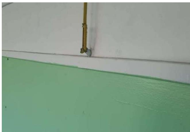
FOTO 166 SALA DE AULA 13 COM AUSÊNCIA DE BRAÇO DE ALAVANCA.
