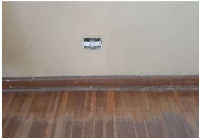
FOTO 349 SALA DE AULA 17 COM IMPROVISO NA REDE ELÉTRICA DE ILUMINAÇÃO E VENTILAÇÃO.
