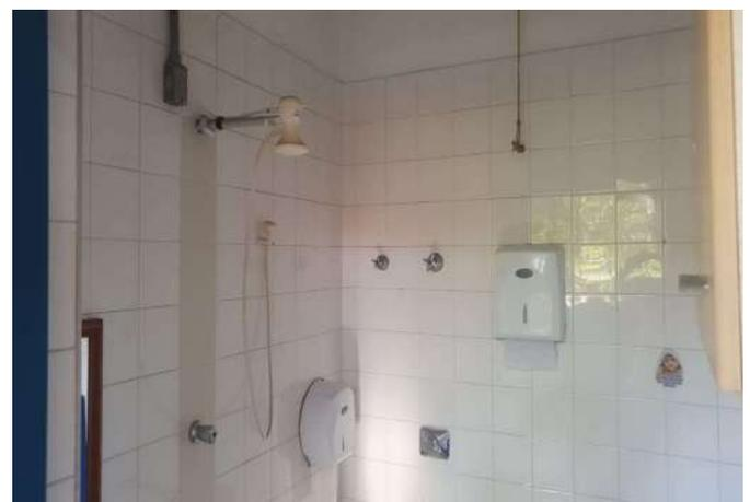
FOTO 24 BANHO E TROCA, REVESTIMENTO DISTOANTE E AUSÊNCIA DE BRAÇO DE ALAVANCA.
