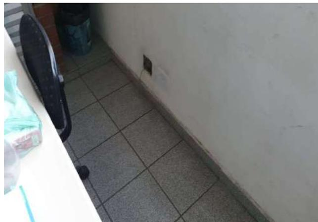
FOTO 278 SALA DOS PROFESSORES COM FALTA DE ACABAMENTO DE TOMADA.
