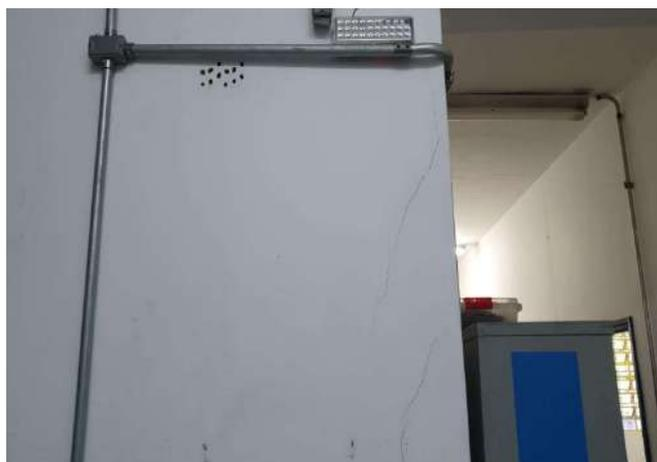
FOTO 262 SECRETARIA COM TRINCA NO REVESTIMENTO DA PAREDE.
