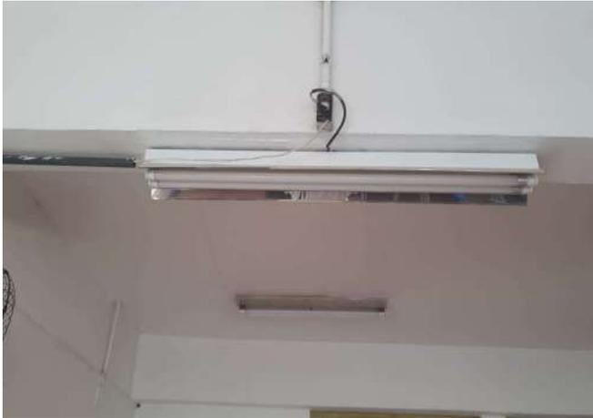
FOTO 323 SALA DE AULA 14 COM IMPROVISO NA REDE ELÉTRICA DE ILUMINAÇÃO E VENTILAÇÃO.
