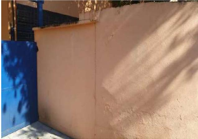
FOTO 283 MURO DE DIVISA COM TRINCA MAPEADA NA JUNTA.
