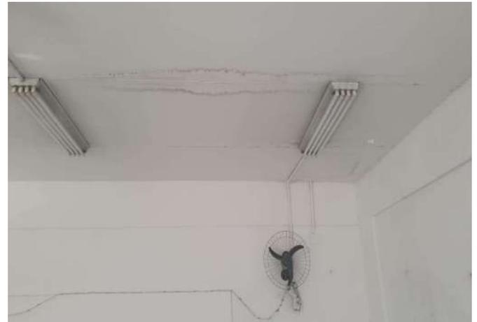
FOTO 68 LABORATÓRIO, IMPROVISO NA REDE ELÉTRICA DE ILUMINAÇÃO E VENTILAÇÃO.
