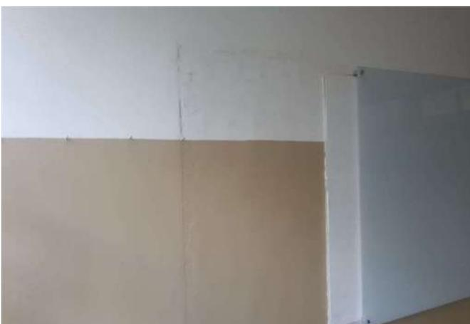
FOTO 293 SALA DE AULA 04 COM REVETIMENTO DE PINTURA DANIFICADO.
