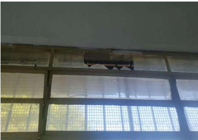
FOTO 63 LABORATÓRIO, CAIXILHO INEFICIENTE E VIDROS QUEBRADOS.
