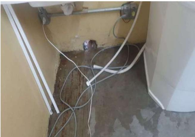
FOTO 225 LAVANDERIA COM IMPROVISO NA REDE HIDRÁULICA E DE ESGOTO.
