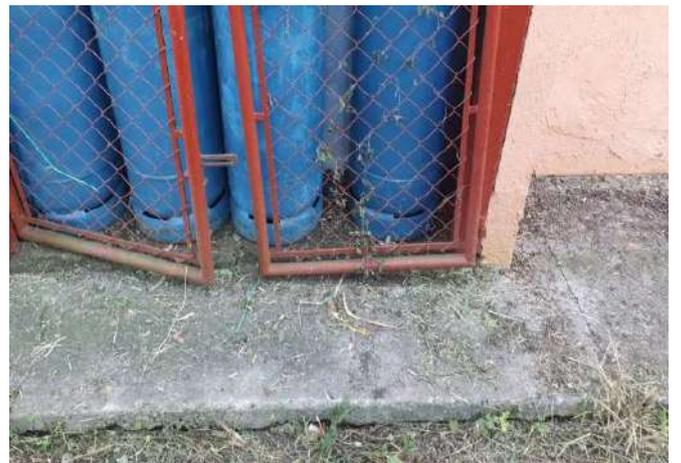
FOTO 52 ABRIGO DE GÁS, COM RECALQUE.
