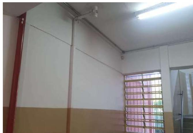
FOTO 363 CORREDOR INTERNO COM IMPROVISO NA REDE DE ESGOTO/CAPTAÇÃO DE ÁGUA.
