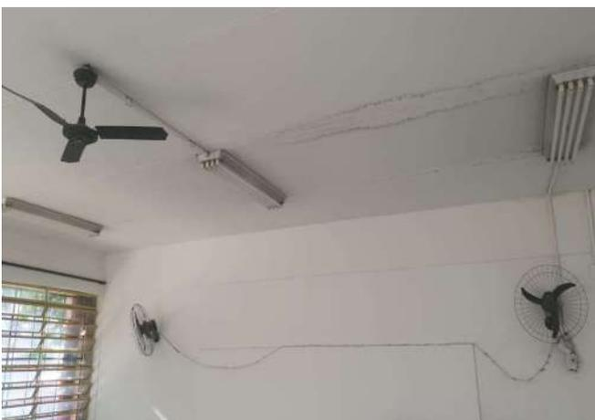
FOTO 95 LABORATÓRIO COM IMPROVISO NA REDE ELÉTRICA DE ILUMINAÇÃO E VENTILAÇÃO.
