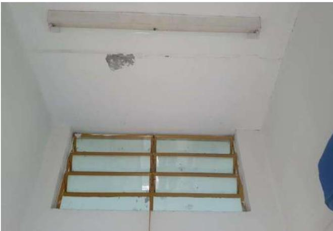
FOTO 33 BANHO E TROCA, REVESTIMENTO DE PINTURA DANIFICADO.
