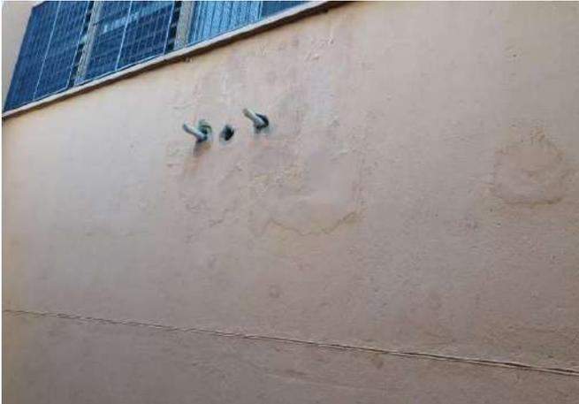
FOTO 55 FACHADA, IMPROVISO NA REDE HIDRÁULICA.
