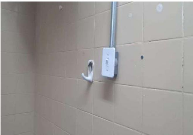
FOTO 201 SALA DE ARTE COM IMPROVISO NA REDE ELÉTRICA.
