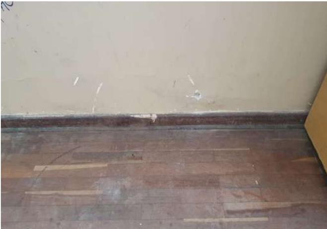
FOTO 217 SALA DE AULA 09 COM REVESTIMENTO DE PINTURA DANIFICADO.
