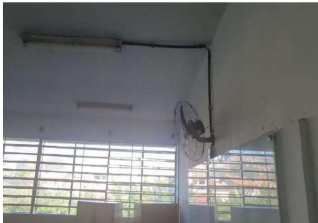
FOTO 341 SALA DE AULA 16 COM IMPROVISO NA REDE ELÉTRICA DE ILUMINAÇÃO E VENTILAÇÃO.
