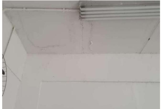
FOTO 74 LABORATÓRIO COM INFILTRAÇÃO.
