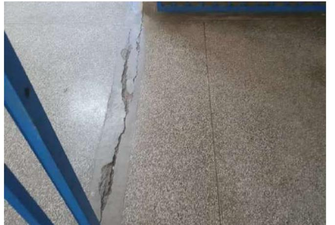
FOTO 328 CORREDOR INTERNO COM TRINCA NO PISO GRANILITE NA JUNTA DE DILATAÇÃO DO BLOCO.
