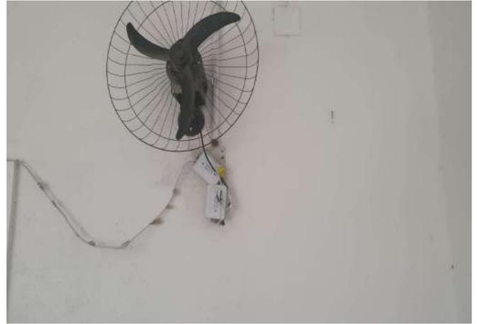
FOTO 98 SALA DOS PROFESSORES, IMPROVISO NA REDE ELÉTRICA FIOS EXPOSTOS.
