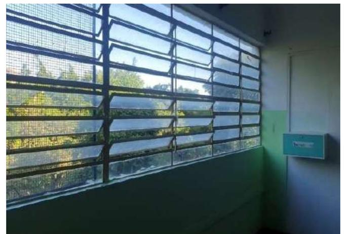
FOTO 172 SALA DE AULA 06, AUSÊNCIA DA TELA DE PROTEÇÃO E CAIXILHO DEFICIENTE.
