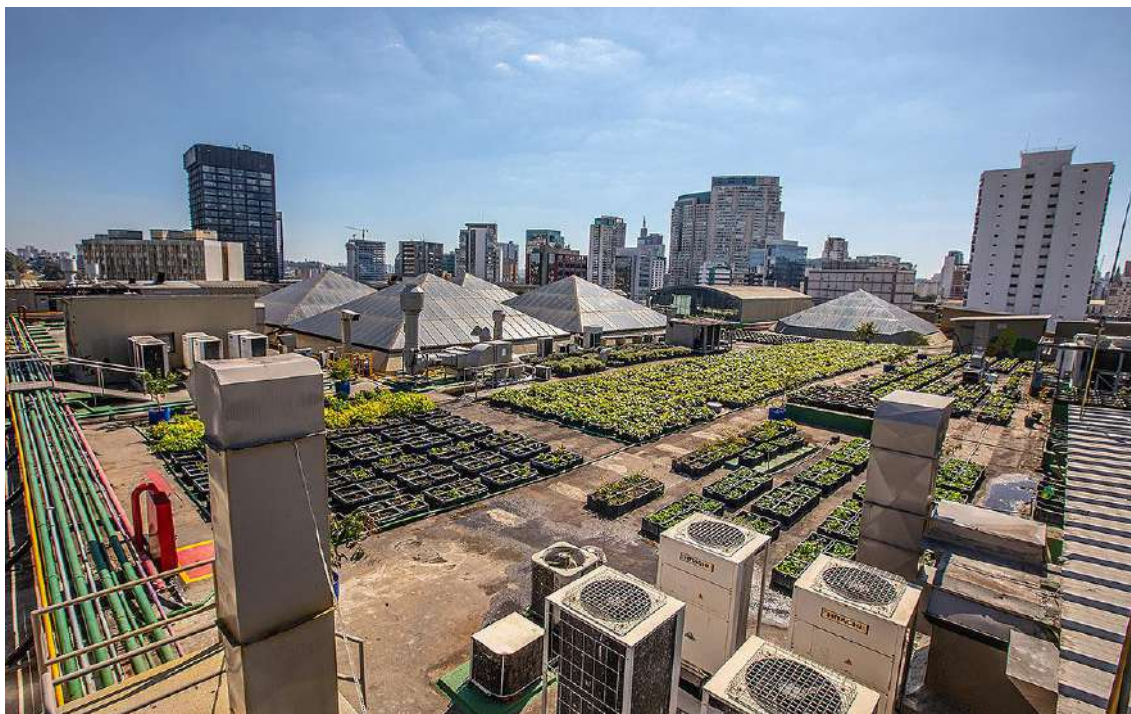
Figura 67. Referencial: Horta e compostagem em laje de cobertura de Shopping Center.
