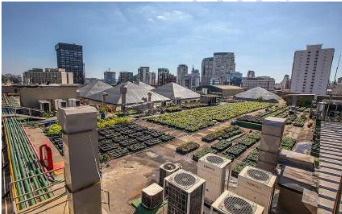
Figura 68. Referencial: Horta e compostagem em laje de cobertura de Shopping Center.
