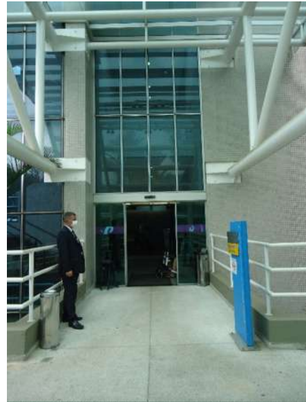
Figura 13 – Prédio 01 – Entrada Centro
