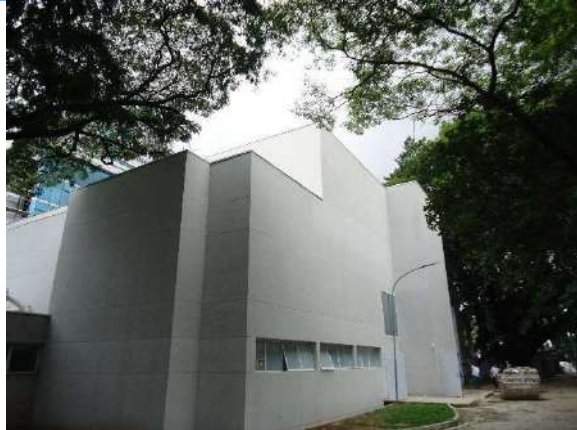
Figura 24 – Prédio 04 –Centro Cirúrgico/ UTI
