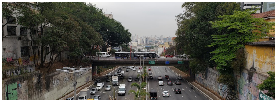
Figura 14 - Vista do Viaduto Mie-Ken a partir do Viaduto Cidade de Osaka Fonte: Acervo SPP
