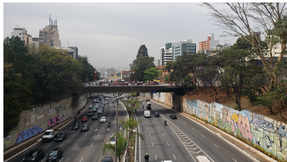
Figura 9 - Vista da Avenida Radial Leste e do Viaduto Cidade de Osaka a partir do Viaduto Guilherme de Almeida Fonte: Acervo SPP
