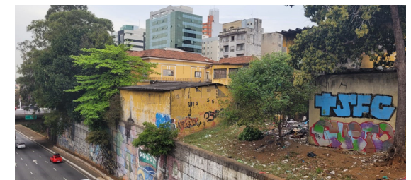
Figura 7 - Imóvel da Prefeitura Municipal de São Paulo (canto direito da imagem), localizado na Rua Galvão Bueno, nº 147 Fonte: Acervo SPP
