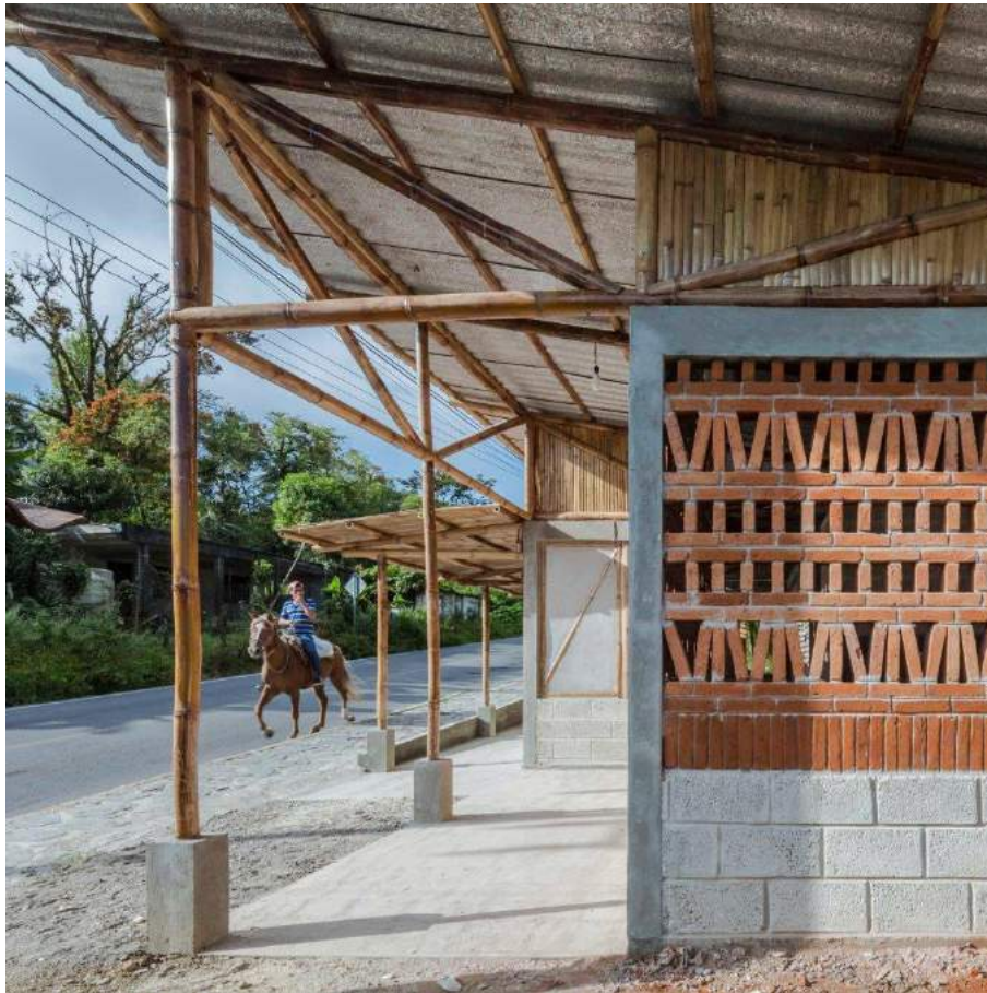
Figura 77. Referencial: Sala Verde (CEU Jardim Campinas), construção com estrutura de bambu.
