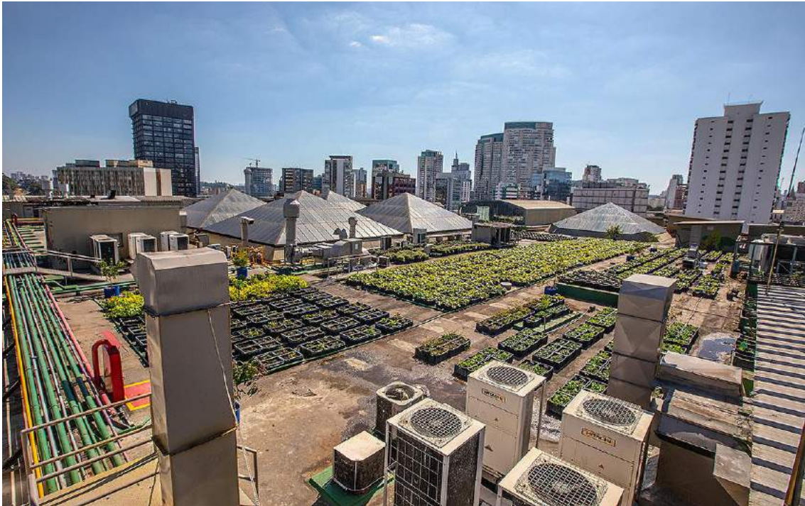
Figura 39. Referencial: Horta e compostagem em laje de cobertura de Shopping Center.
