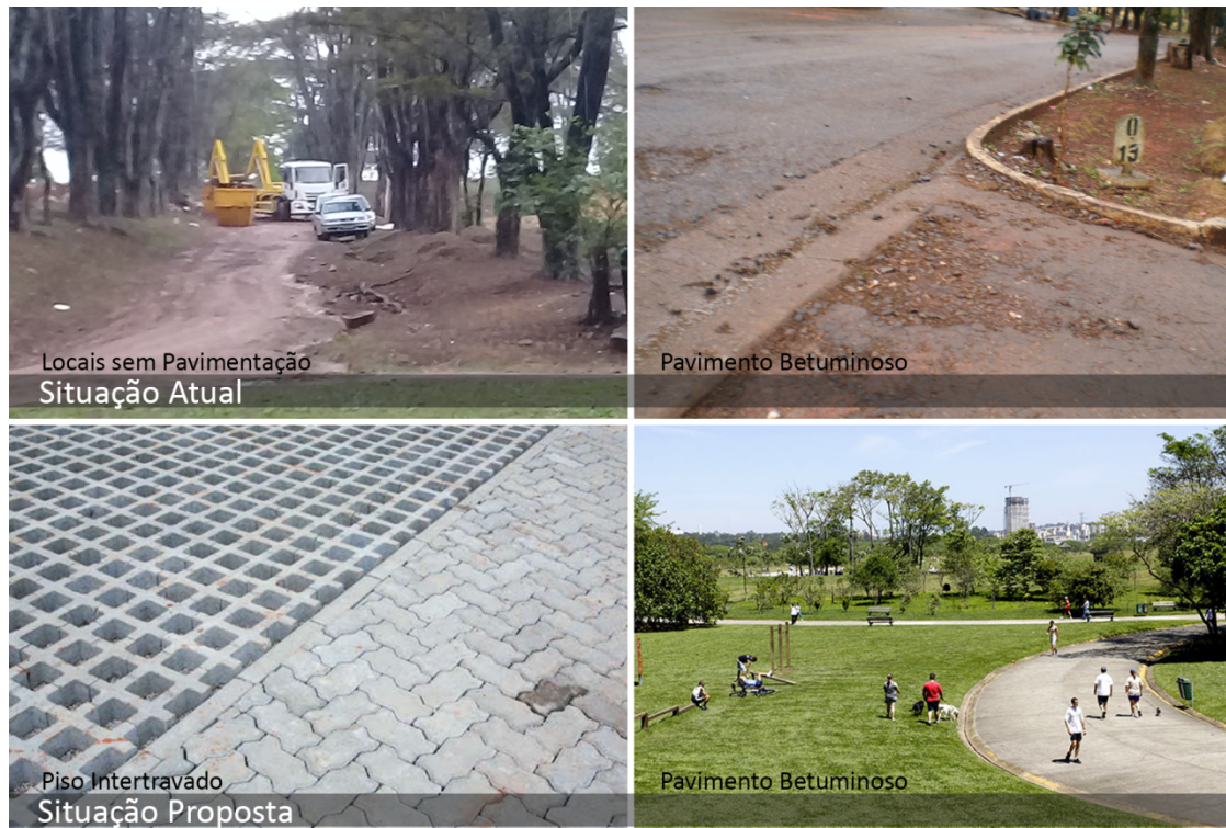
Figura 29 - Infraestrutura de Pavimentação Atual e Proposta
