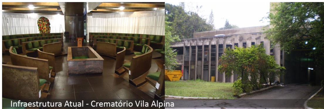
Figura 25 - Infraestrutura Crematório Vila Alpina
