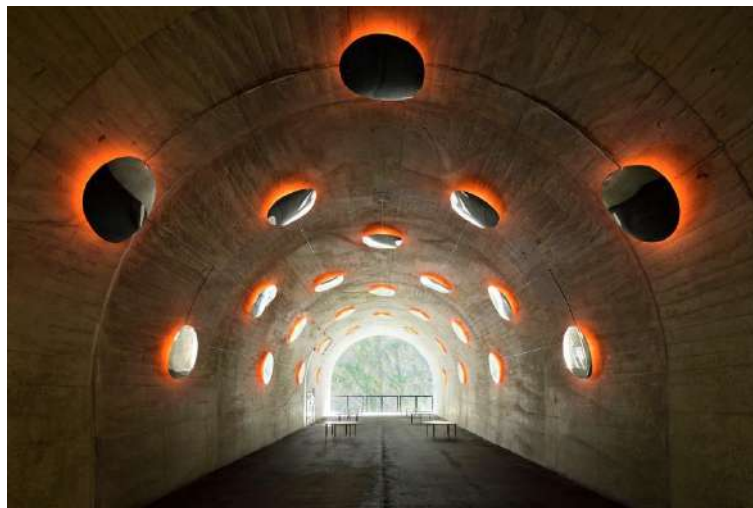
Figura 26 – Túnel restaurado em Kiyotsu, Japão – MAD Architects Foto: Nacasa&Partners Inc.
