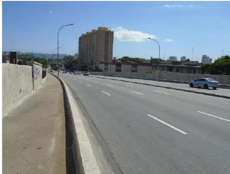
FOTO 1 – Vista superior do tabuleiro do viaduto.
