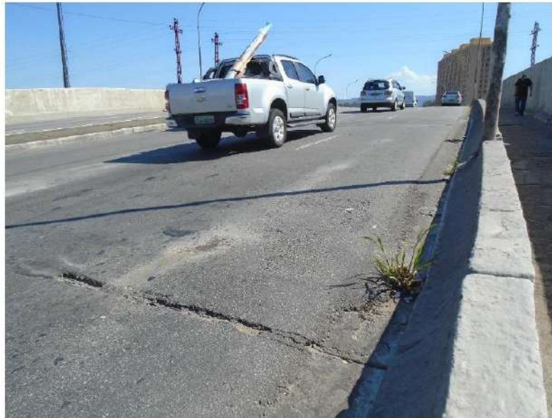
FOTO 5 – Vista de vegetação em área de drenagem sobre o tabuleiro.
