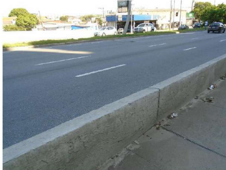
FOTO 3 – Vista da junta de dilatação totalmente revestida com pavimento asfáltico.
