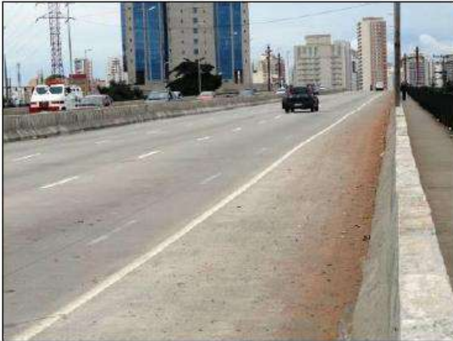
FOTO 1 – Vista superior do tabuleiro do viaduto.
