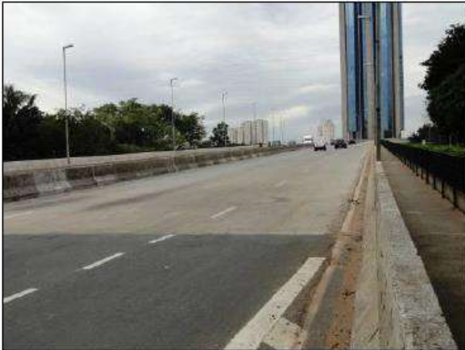
FOTO 1 – Vista superior do viaduto.
