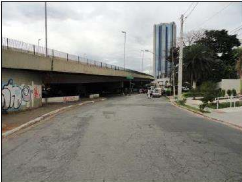
FOTO 2 – Vista lateral do viaduto.
