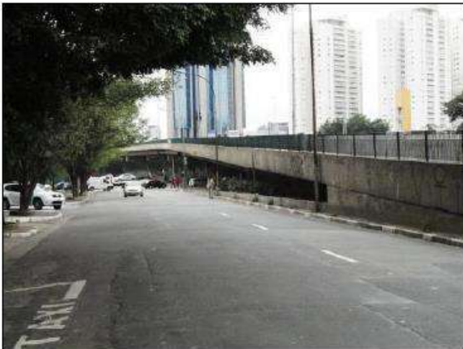
FOTO 2 – Vista lateral do viaduto.
