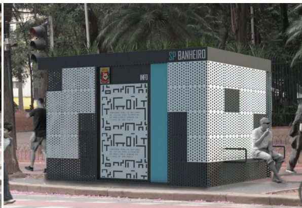
Figura 8 – Sanitário – 2º lugar (trabalho 41)
