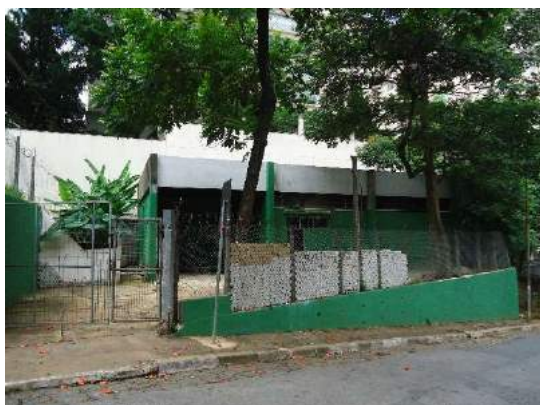
Figura 12- Rua Convenção de Itu x Al. Jaú
